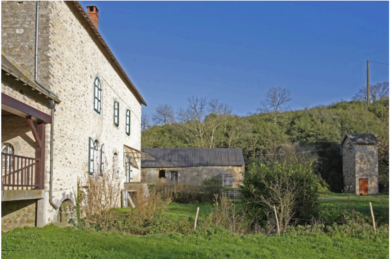
Le moulin, le fournil-étable et le transformateur électrique vus depuis l'ouest.
