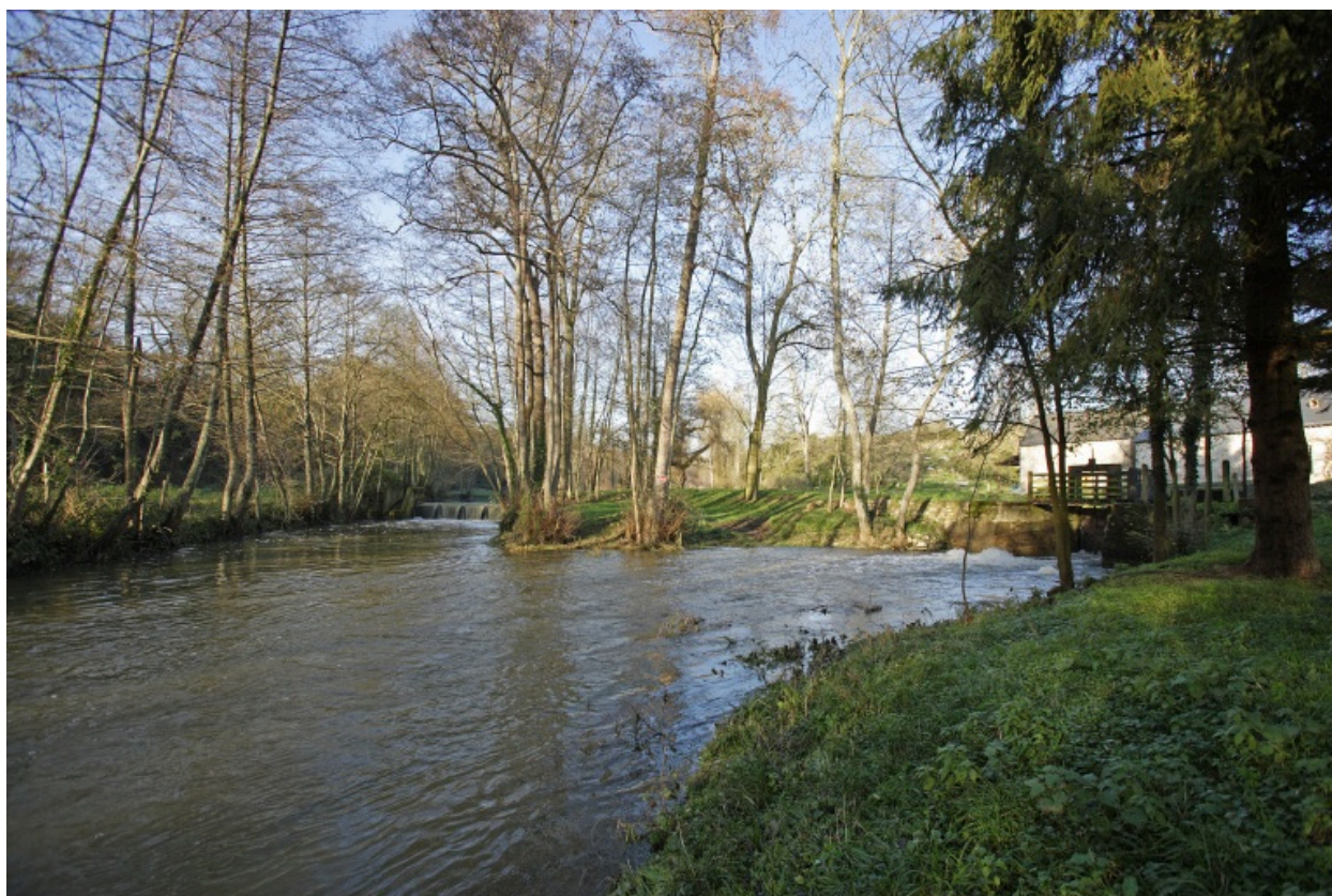
Le déversoir, le barrage et la vanne de décharge vus depuis l'aval.
