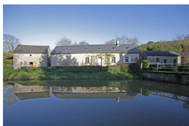
L'écurie, le logis-étable et la porcherie vus depuis l'est. Phot. François Lasa IVR52_20065302883NUCA
