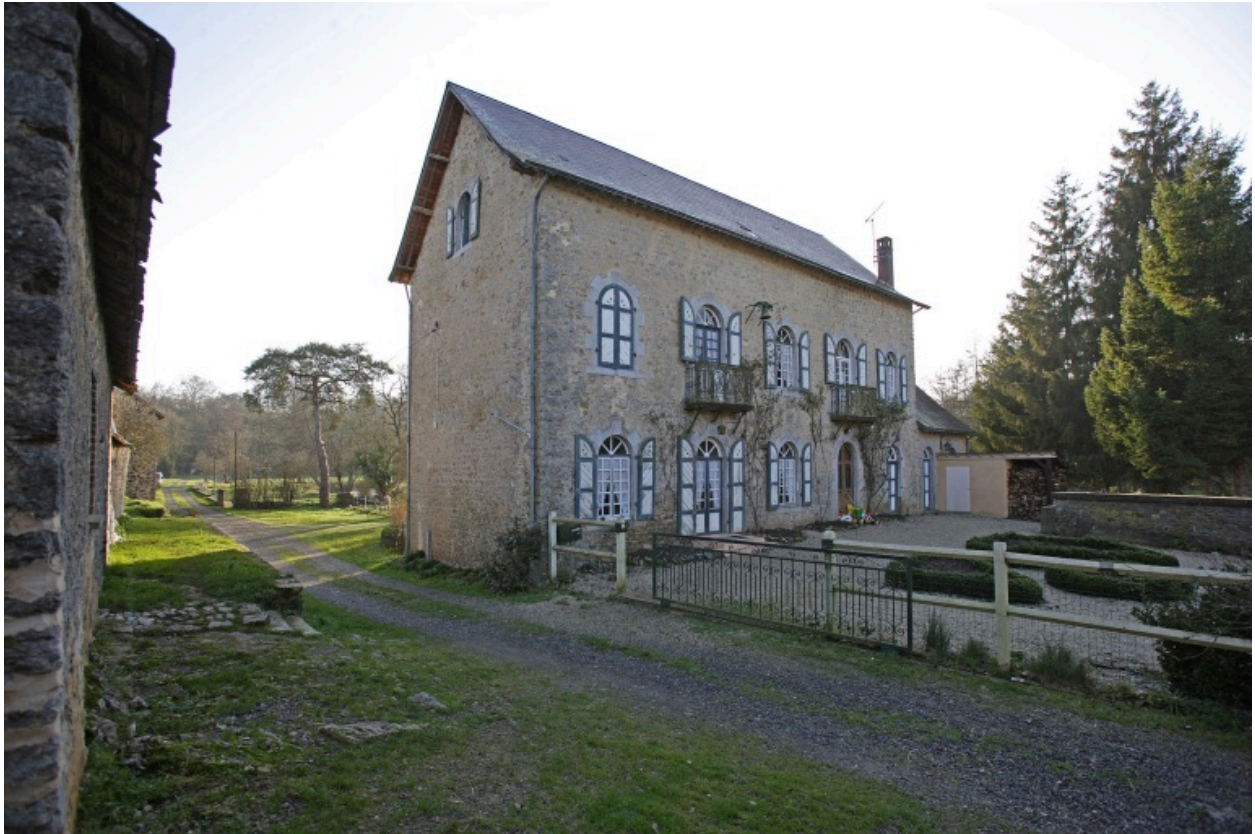
Le moulin vu depuis le nord.
