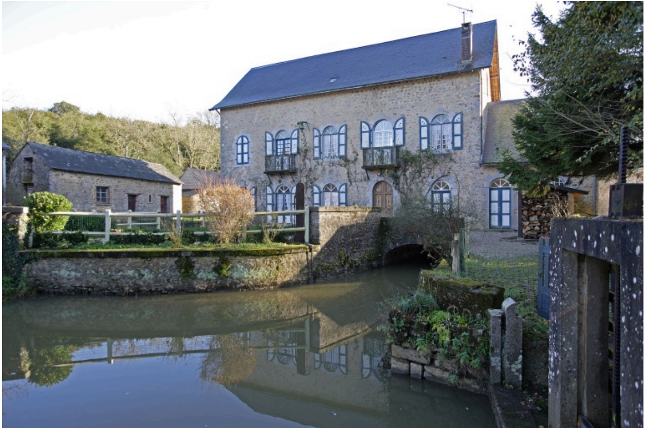
La porcherie, le moulin et le barrage vus depuis l'amont au nord-ouest.
