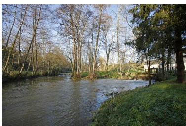
Le déversoir, le barrage et la vanne de décharge vus depuis l'aval. Phot. François Lasa IVR52_20065302887NUCA
