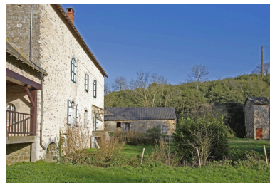
Le moulin, le fournil- étable et le transformateur électrique vus depuis l'ouest. Phot. François Lasa IVR52_20065302885NUCA
