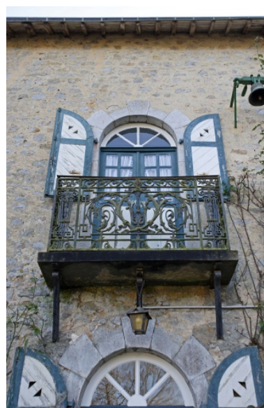
Détail de la façade nord du moulin : garde-corps en remploi. Phot. François Lasa IVR52_20065302882NUCA
