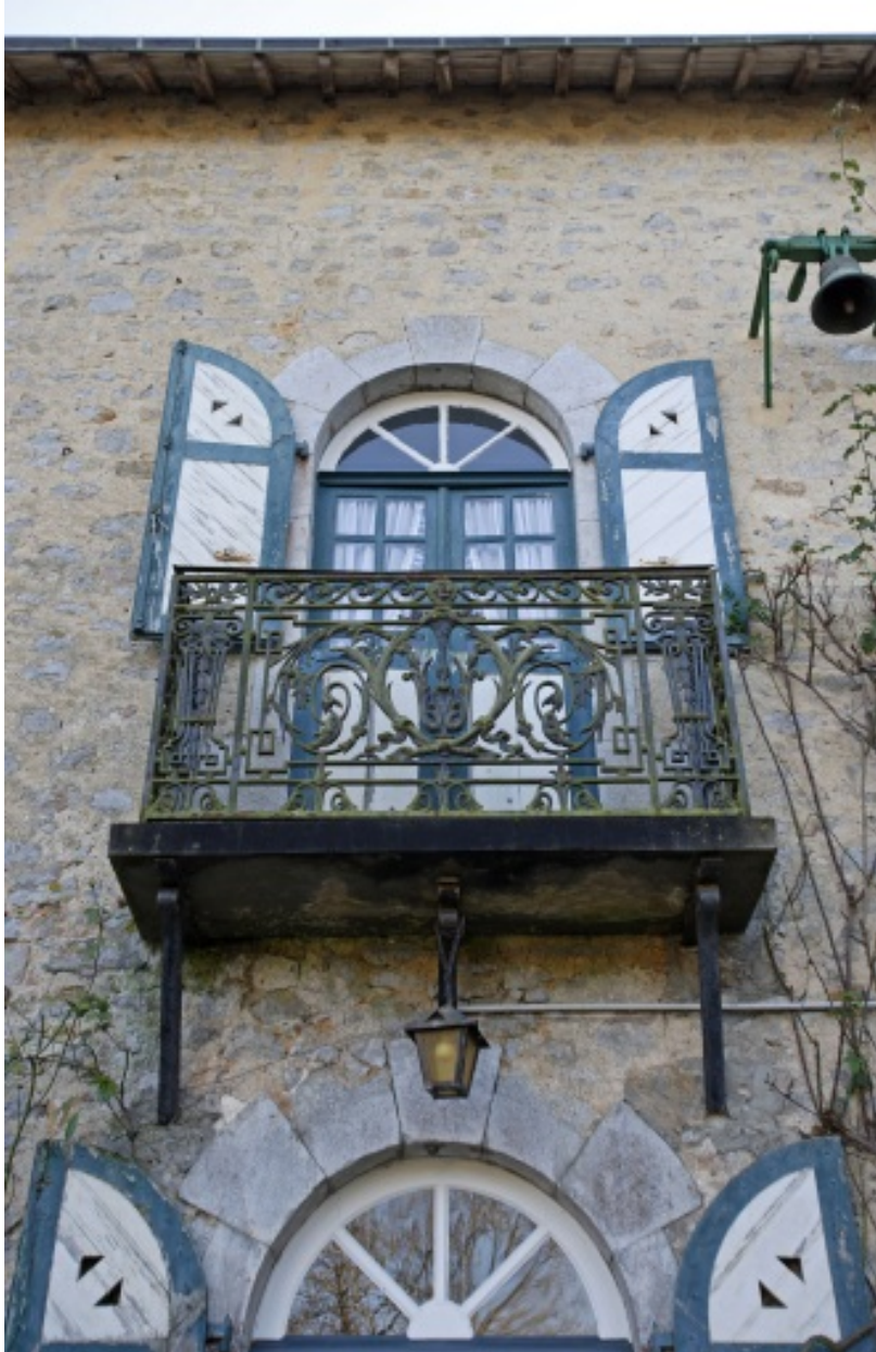
Détail de la façade nord du moulin : garde-corps en remploi.
