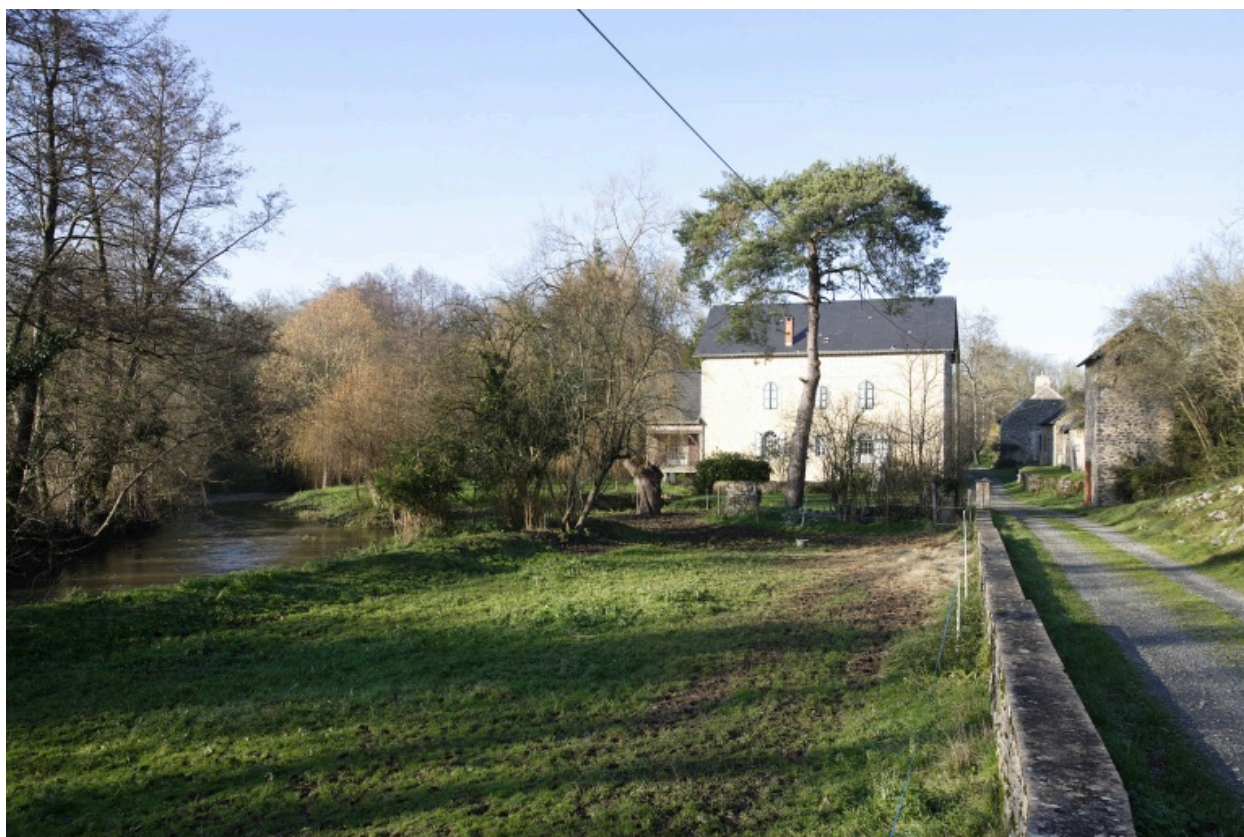
Vue d'ensemble depuis le chemin d'accès au sud-est.
