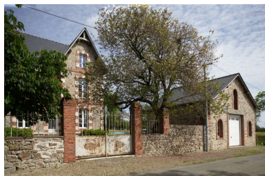
Vue d'ensemble depuis la route au sud. Phot. François Lasa IVR52_20055301556NUCA
