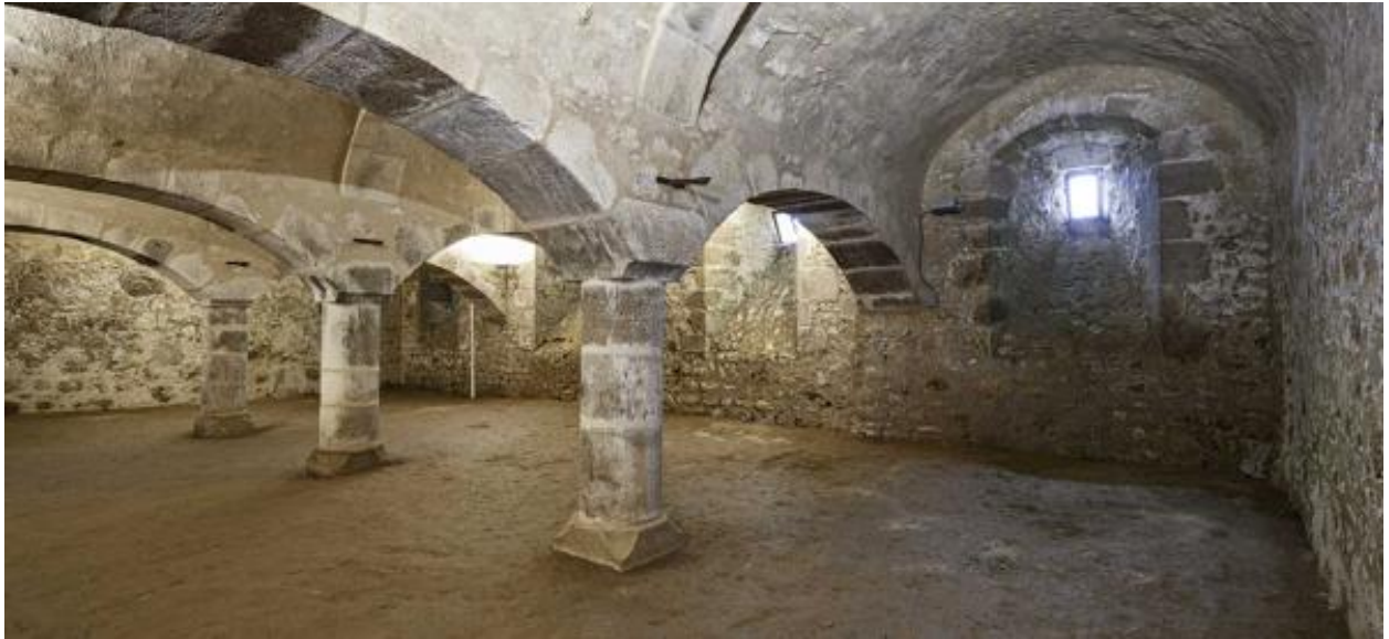
Cave du corps de logis nord-ouest.
