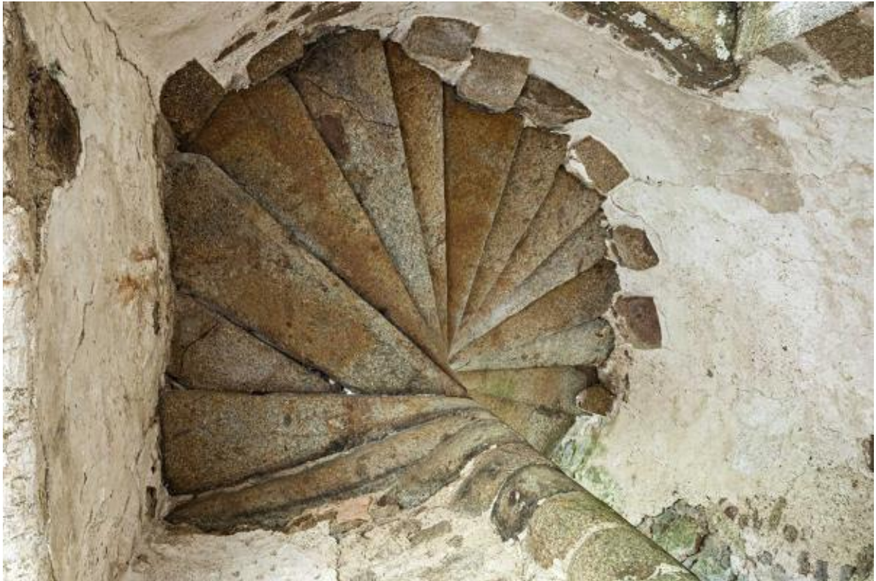
Escalier du corps de logis sud.
