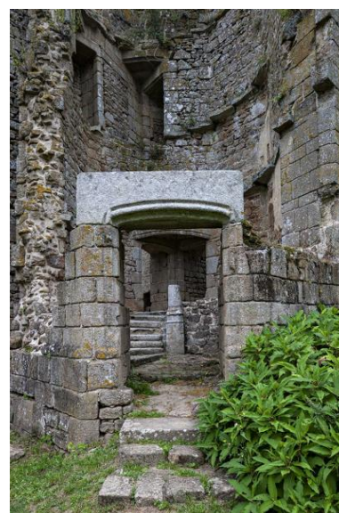
Porte de la tour d'escalier située dans l'angle du corps de logis nord-ouest. Phot. Yves Guillotin IVR52_20215301375NUCA
