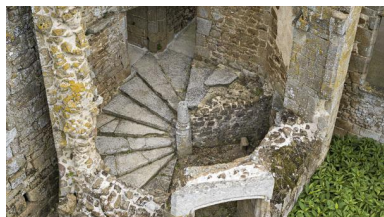
Escalier du corps de logis nord-ouest. Phot. Yves Guillotin IVR52_20215301419NUCA
