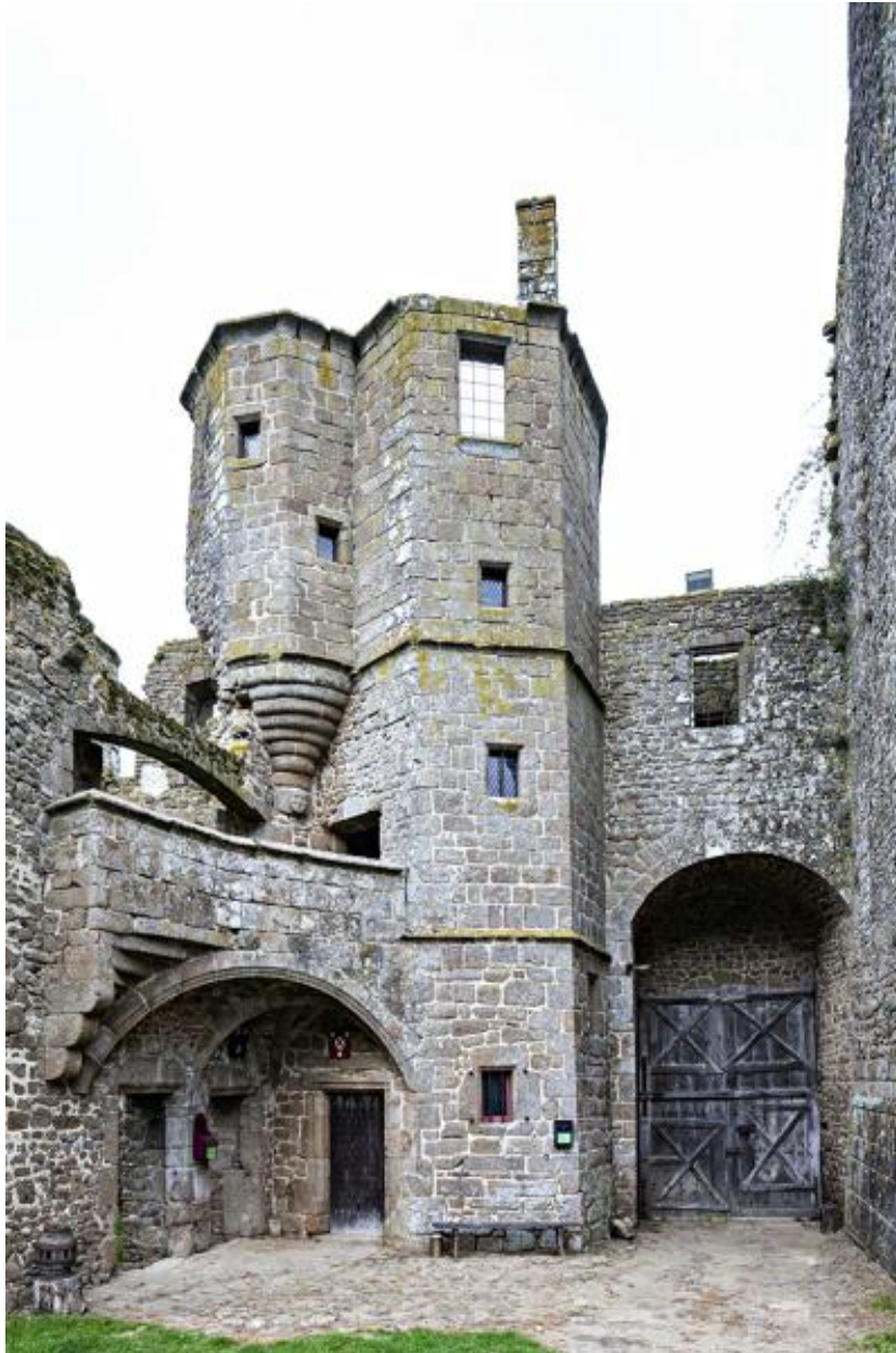
Balcon et tour d'escalier du corps de logis sud, revers du portail.
