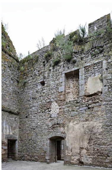
Intérieur de la grande salle, aile ouest du corps de logis nord-ouest, mur oriental. Phot. Yves Guillotin IVR52_20215301380NUCA
