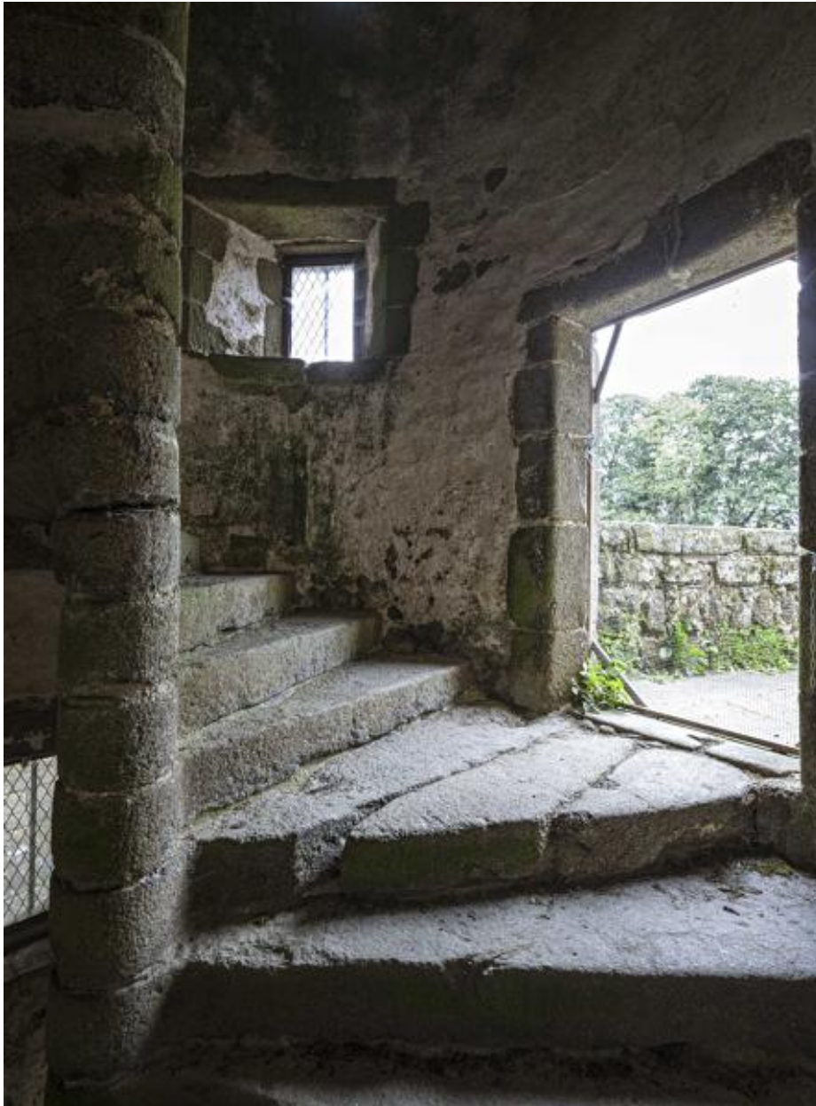
Escalier du corps de logis sud.
