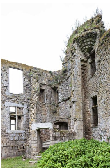
Angle intérieur du corps de logis nord-ouest. Phot. Yves Guillotin IVR52_20215301370NUCA
