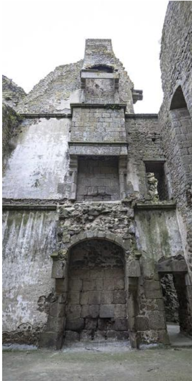
Cheminées de l'aile nord du corps de logis nord-ouest.
