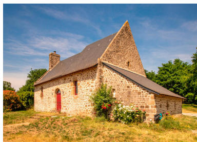
Ferme de la Basse- Cour, corps de logis. Phot. Pierre-Bernard Fourny IVR52_20235300894NUCA
