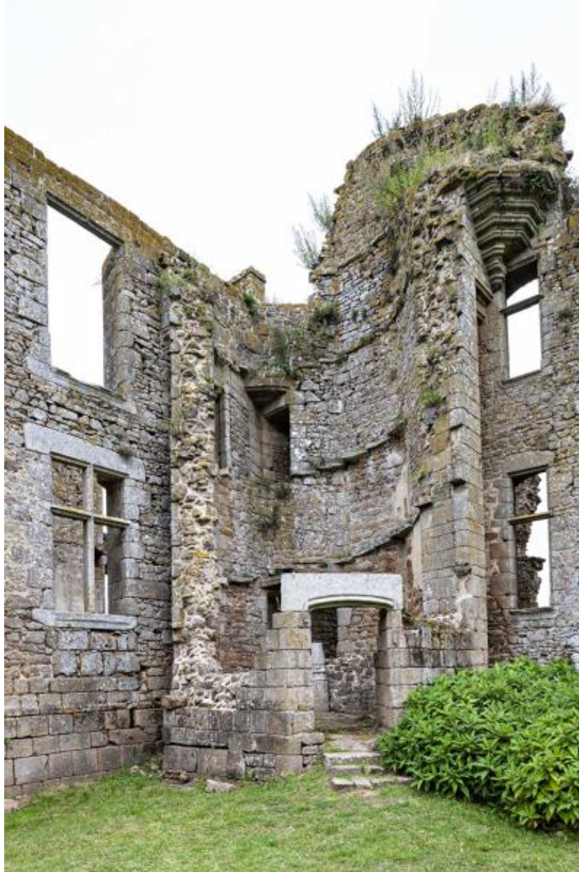
Tour d'escalier dans l'angle du corps de logis nord-ouest.
