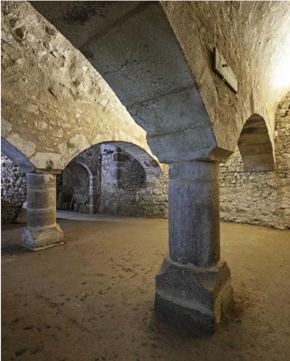
Cave du corps de logis nord-ouest.
