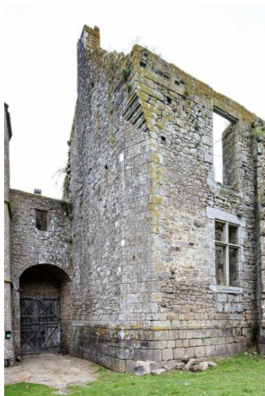
Revers du portail, angle sud-est du corps de logis nord-ouest. Phot. Yves Guillotin IVR52_20215301366NUCA
