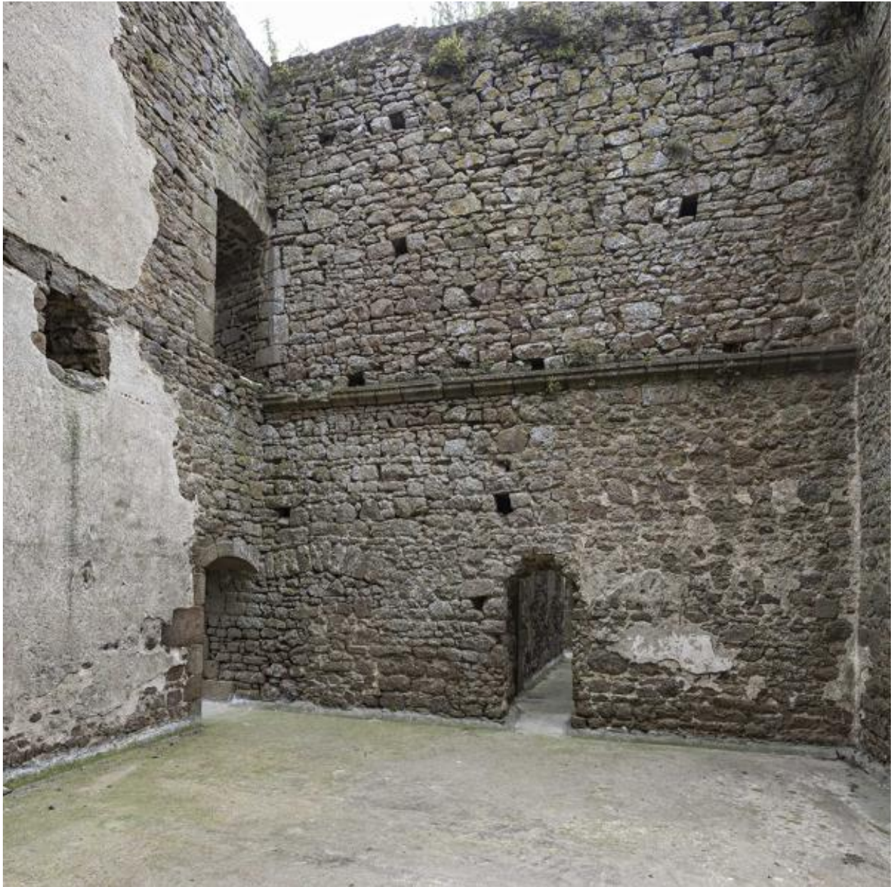
Aile nord, corps de logis nord-ouest.
