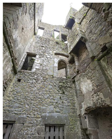
Pièce orientale de l'aile nord du corps de logis nord-ouest. Phot. Yves Guillotin IVR52_20215301390NUCA
