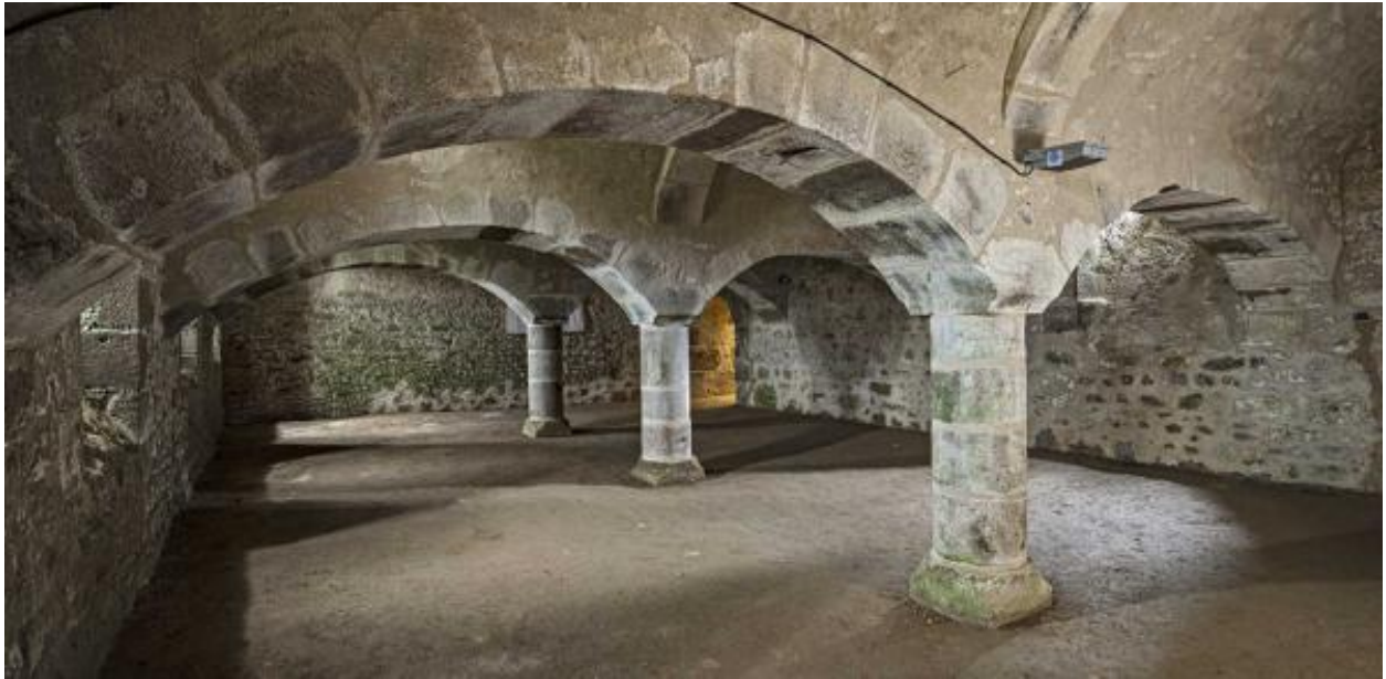
Cave du corps de logis nord-ouest.
