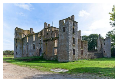
Le château du Bois-Thibault, vu depuis le sud-ouest. Phot. Yves Guillotin IVR52_20175300208NUCA
