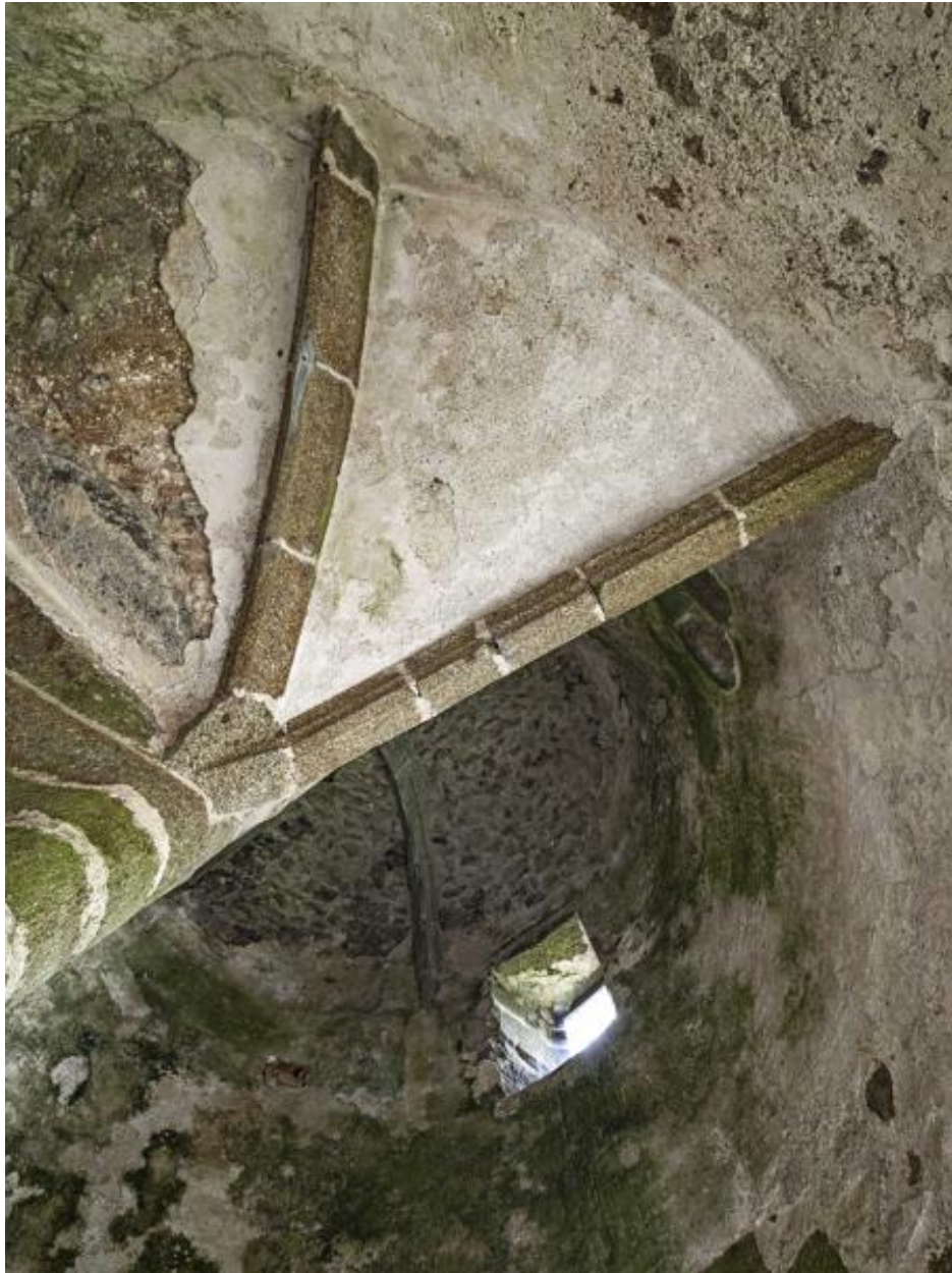
Escalier du corps de logis sud.
