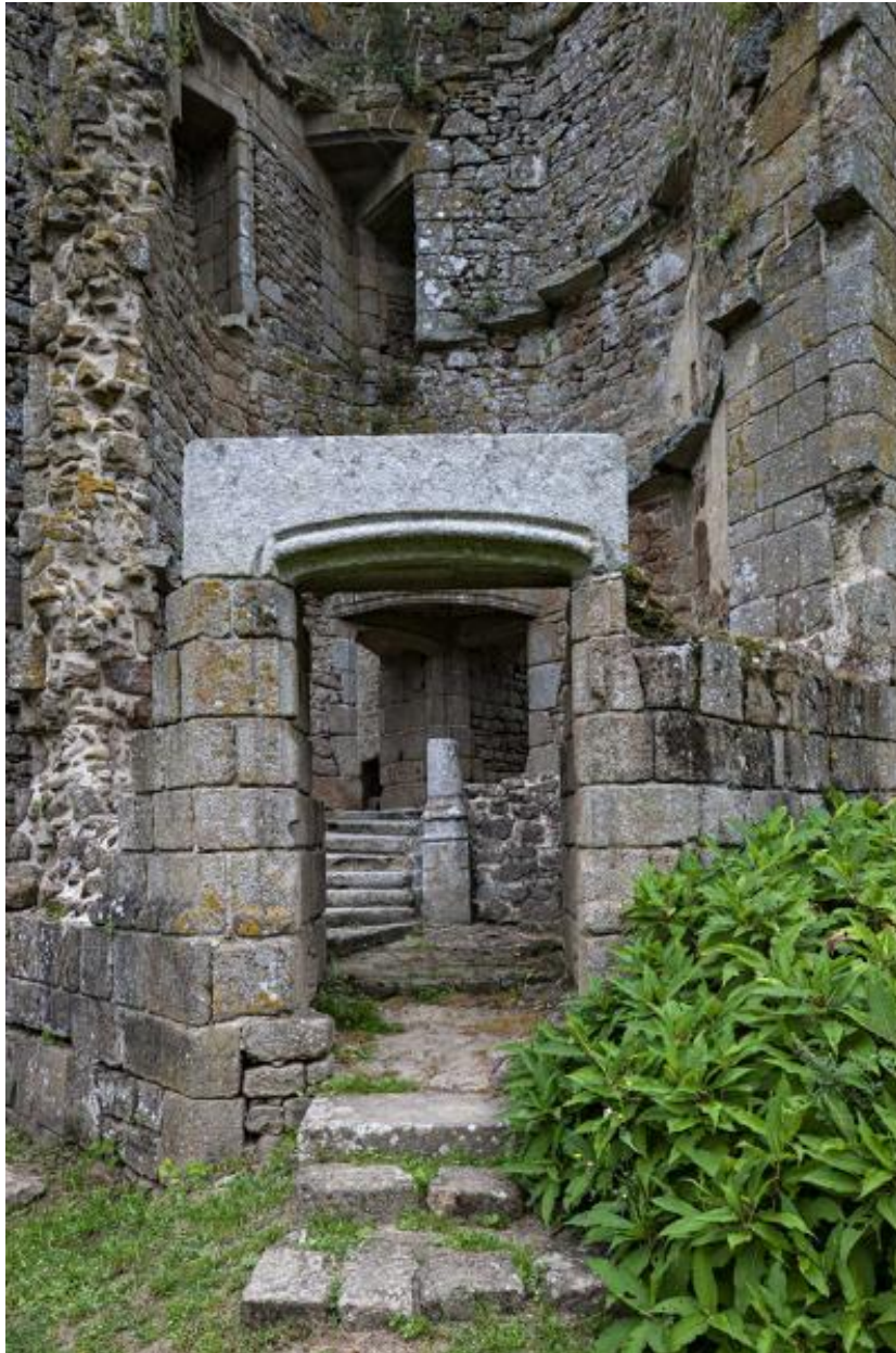
Porte de la tour d'escalier située dans l'angle du corps de logis nord-ouest.
