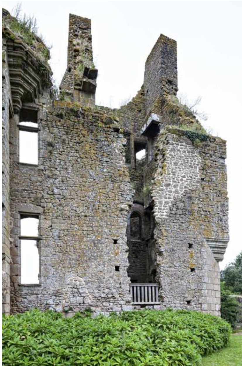
Mur sud de l'aile nord du corps de logis nord-ouest.
