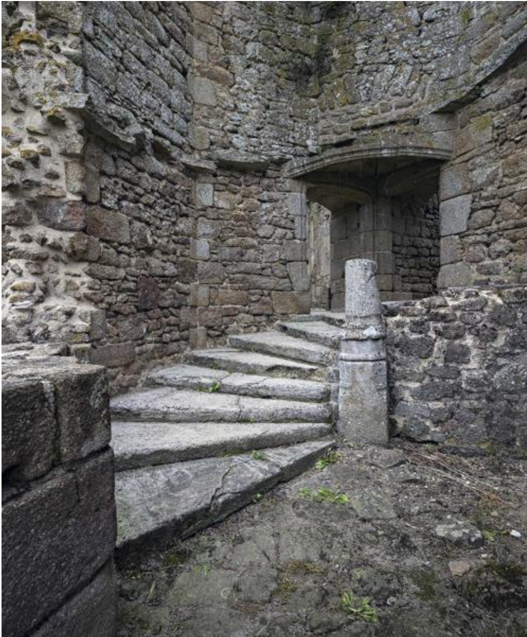
Escalier dans l'angle du corps de logis nord-ouest.
