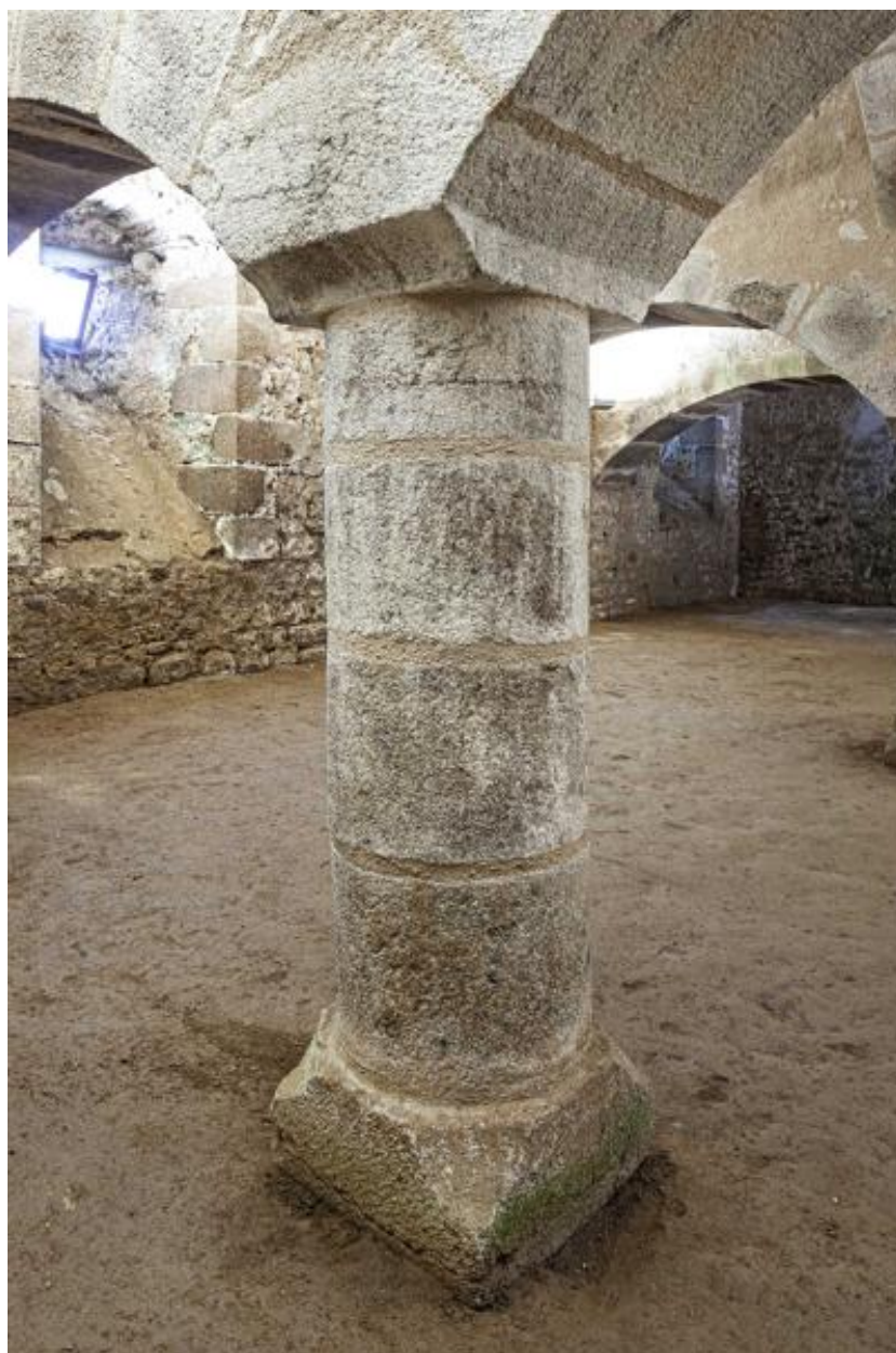
Cave du corps de logis nord-ouest.
