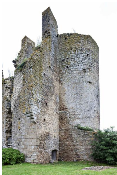
Tour nord-est. Phot. Yves Guillotin IVR52_20215301371NUCA
