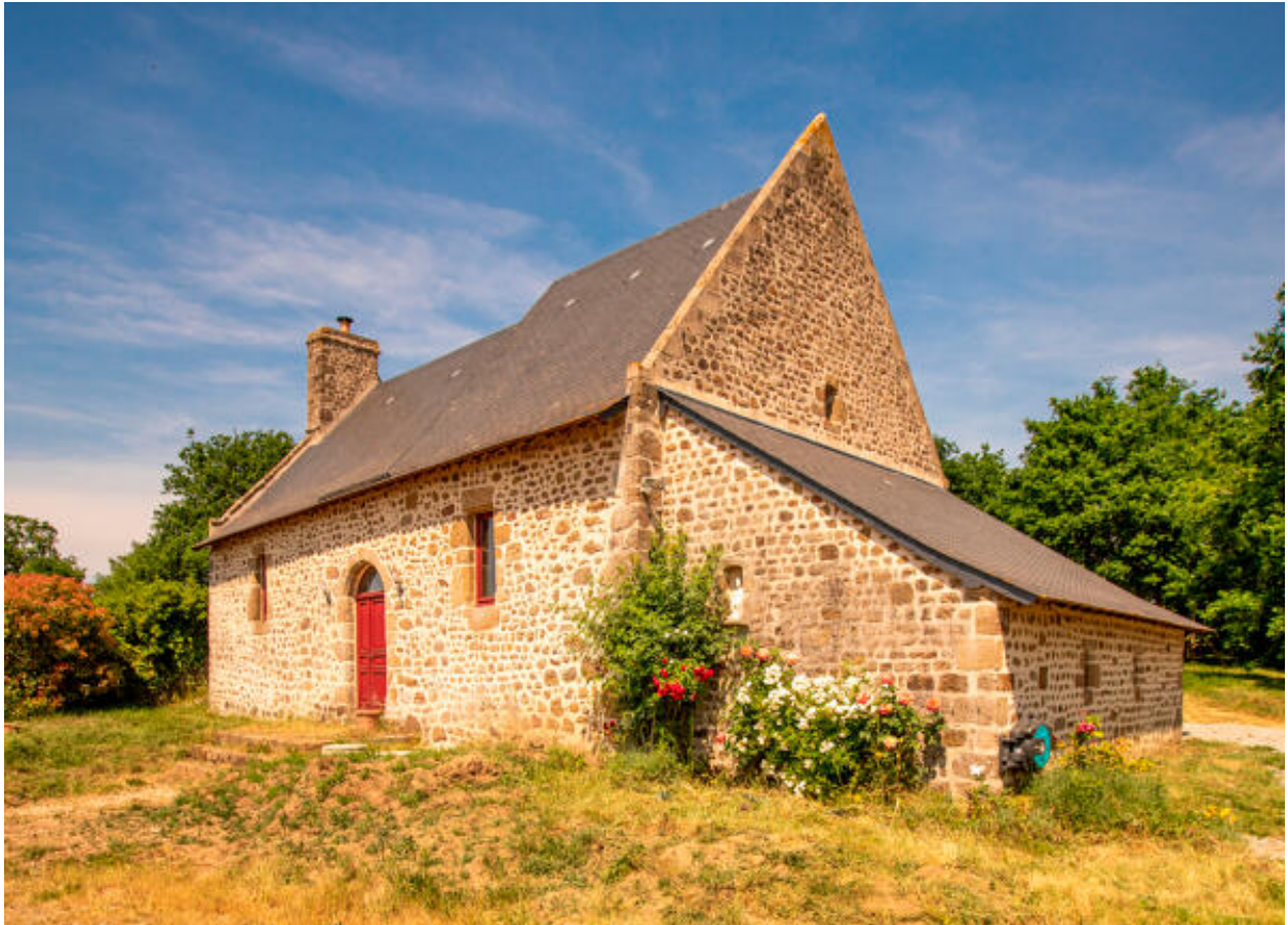
Ferme de la Basse-Cour, corps de logis.
