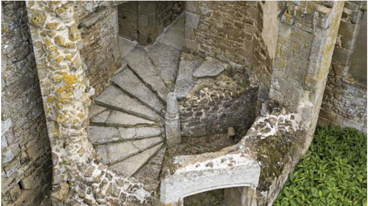
Escalier du corps de logis nord-ouest.
