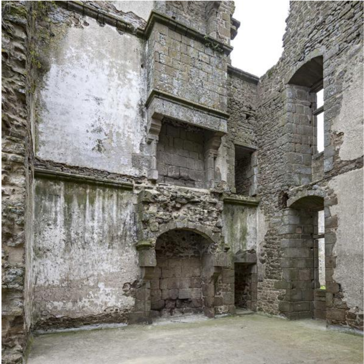
Cheminées de l'aile nord du corps de logis nord-ouest.
