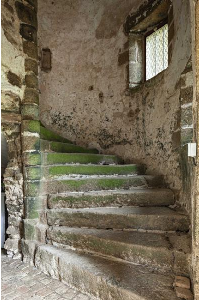
Escalier du corps de logis sud.
