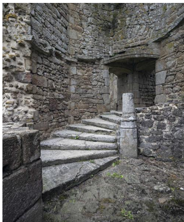
Escalier dans l'angle du corps de logis nord-ouest. Phot. Yves Guillotin IVR52_20215301376NUCA
