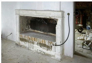
Logis : cheminée, XVIIIe siècle. Phot. François Lasa IVR52_20077200642NUCA
