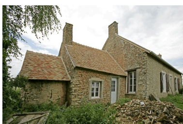
Vue générale. Phot. François Lasa IVR52_20077200647NUCA
