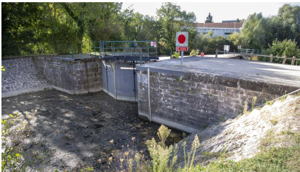
Vue de la porte amont de l'écluse.
