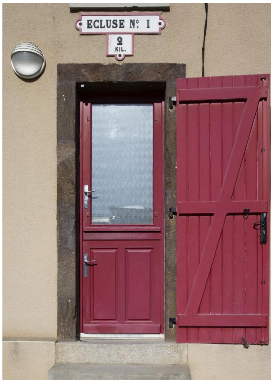
Vue de la porte de la maison de l'éclusier.
