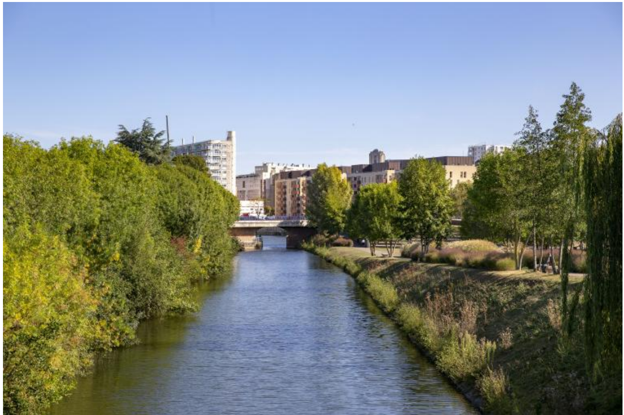
Vue du canal depuis l'aval.
