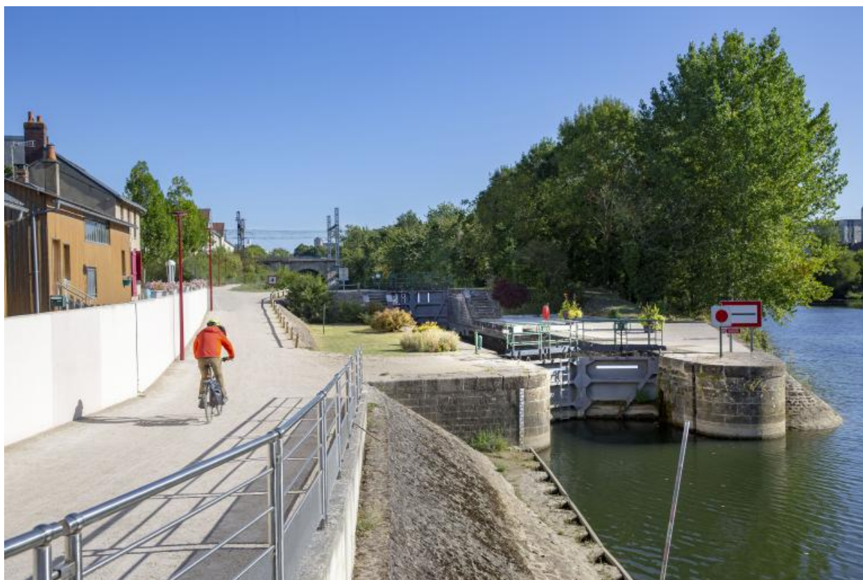
Vue de l'embouchure du canal et de l'écluse.
