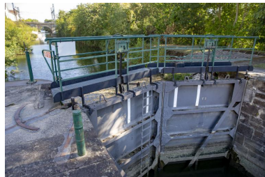
Vue de la porte amont depuis le sas. Repro. Pierre-Bernard Fourny IVR52_20197202129NUCA
