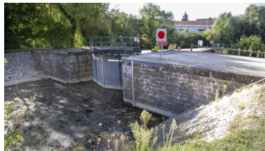
Vue de la porte amont de l'écluse. Repro. Pierre-Bernard Fourny IVR52_20197202128NUCA
