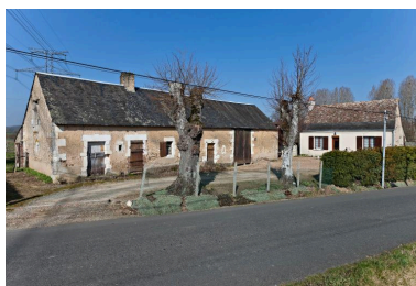
Vue d'ensemble : ferme bloc à terre à gauche, maison à droite. Phot. Yves Guillotin IVR52_20127200377NUCA
