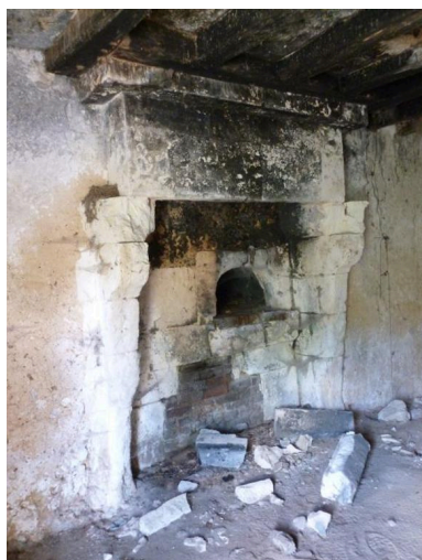
Ferme bloc à terre, maison : cheminée au mur ouest. Phot. Stéphanie Aquilon IVR52_20127200712NUCA
