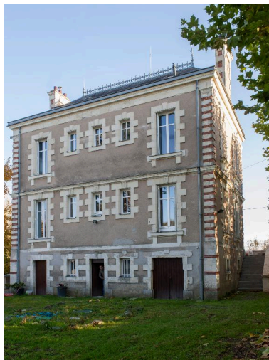
Vue de la façade arrière. Phot. Armelle Maugin IVR52_20174902085NUCA
