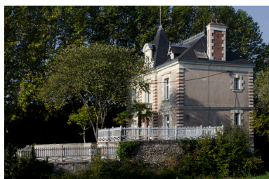
Vue depuis l'est. Phot. Bruno Rousseau IVR52_20134901602NUCA
