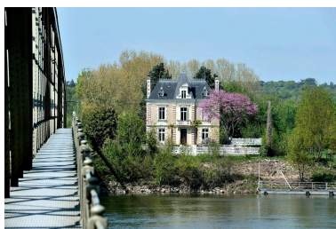
Vue depuis le pont des Lombardières. Phot. Bruno Rousseau IVR52_20174901290NUCA
