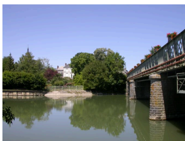
Le pont sur le Loir à Luché.
