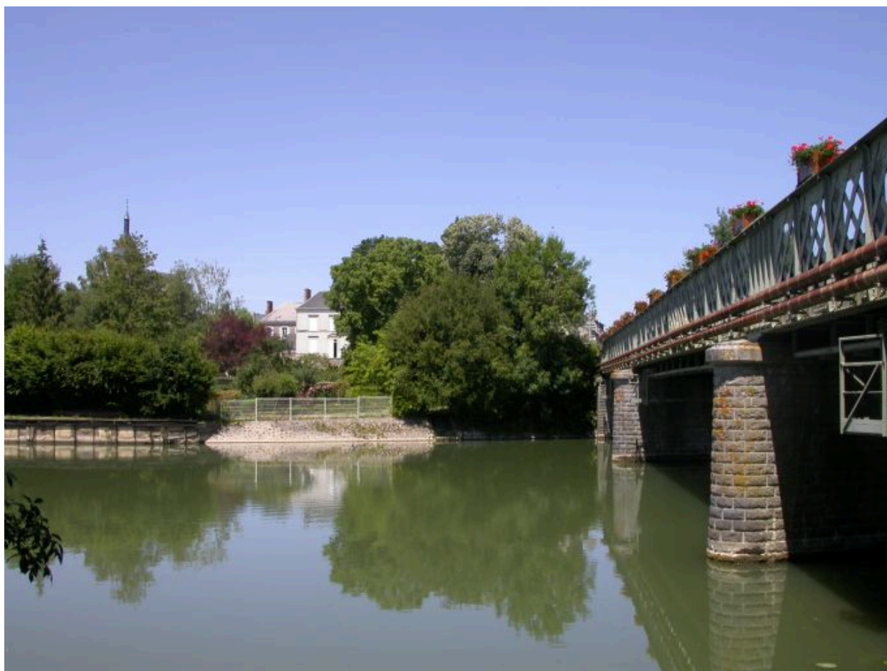
Le pont sur le Loir à Luché.
