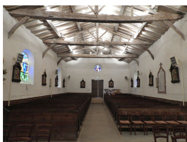
Vue intérieure en direction de l'entrée ouest. Phot. Yannis Suire IVR52_20188500775NUCA
