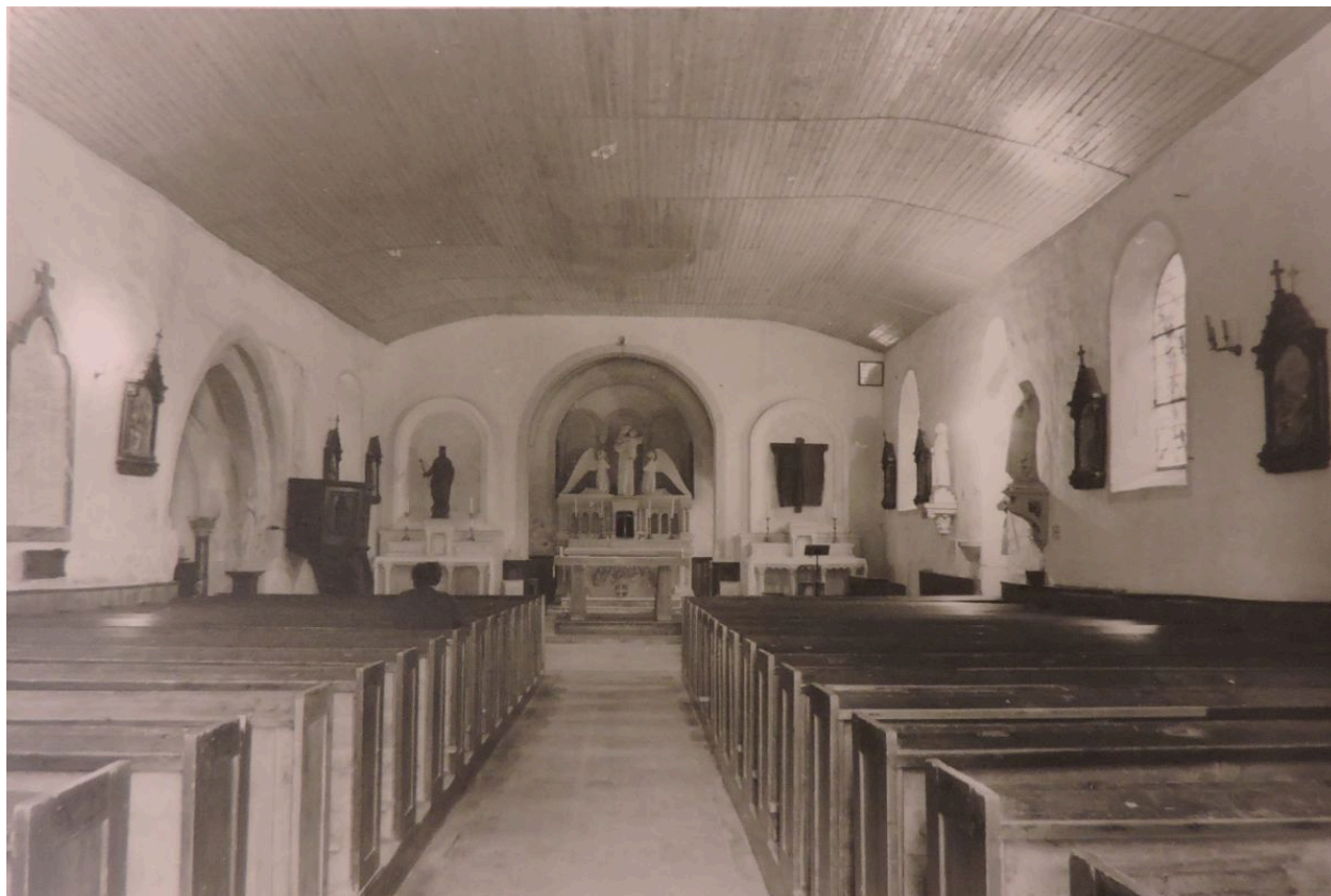
Vue intérieure de l'église en 1969.
