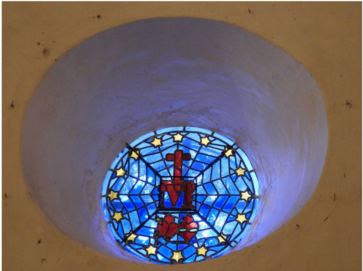
Verrière au-dessus de la porte sud.
