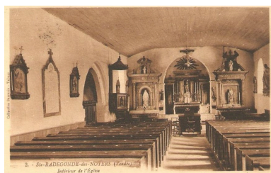
Vue intérieure de l'église vers 1930. Repro. Yannis Suire IVR52_20188501108NUCA
