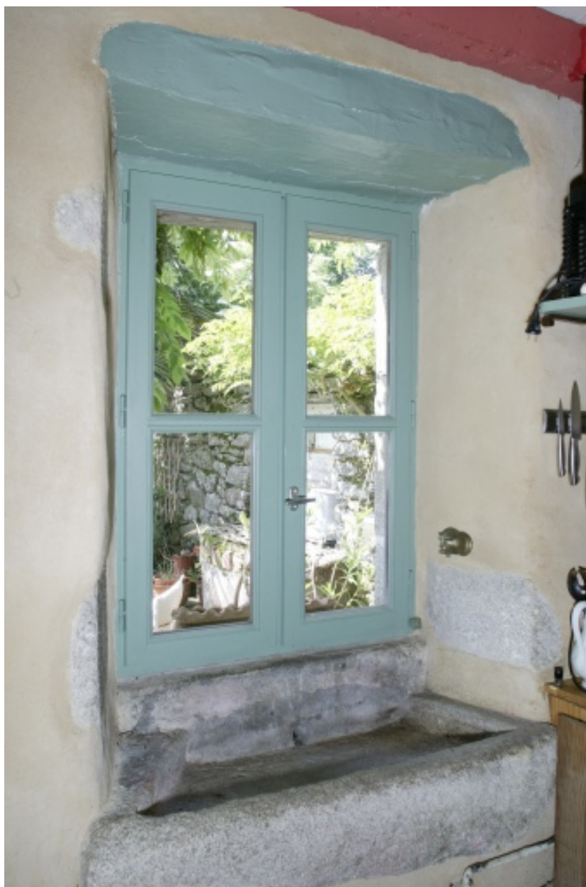
Evier en granite au rez-de-chaussée dans la partie sur jardin.
