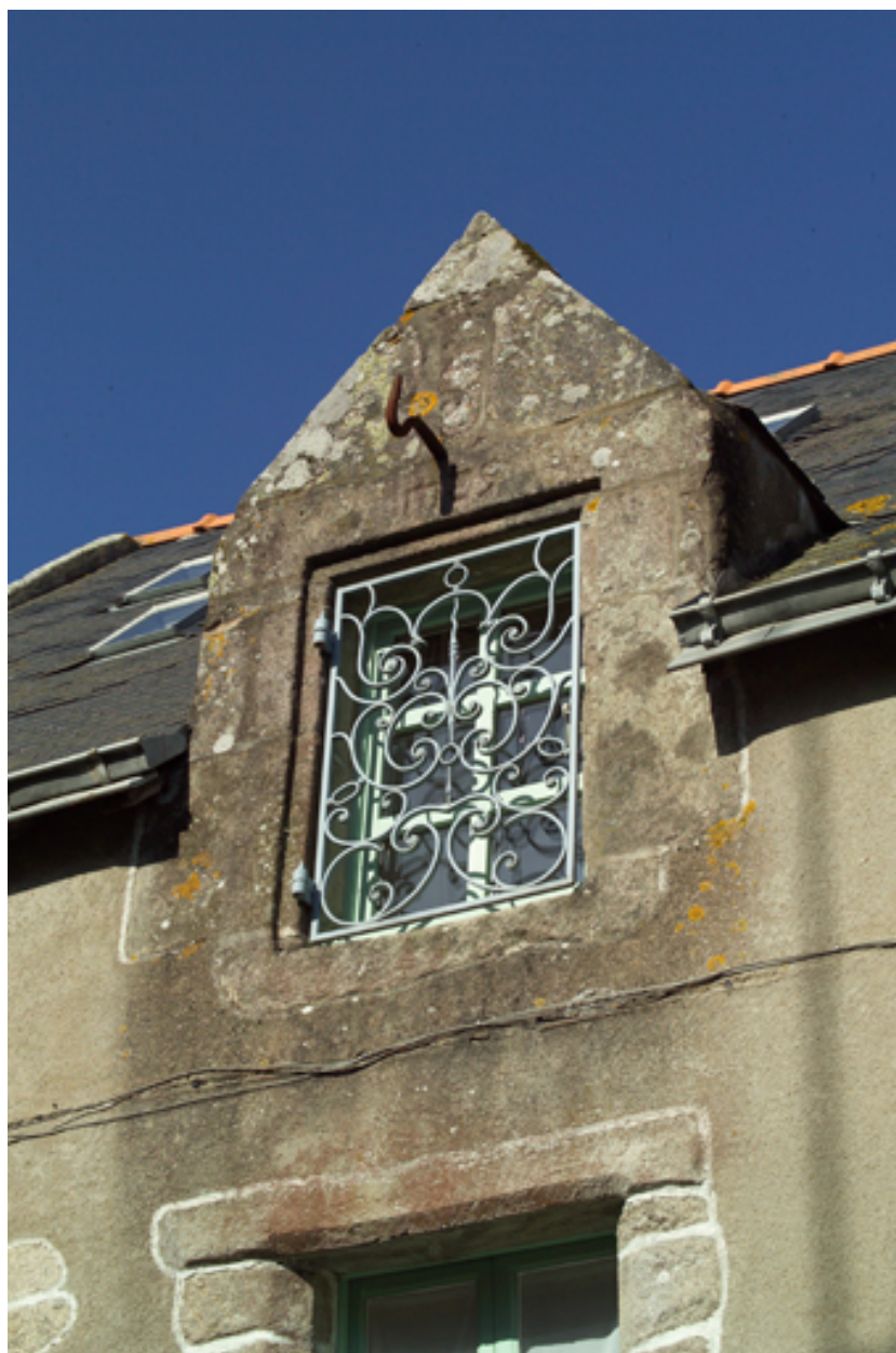
Façade sur rue, détail de la lucarne.
