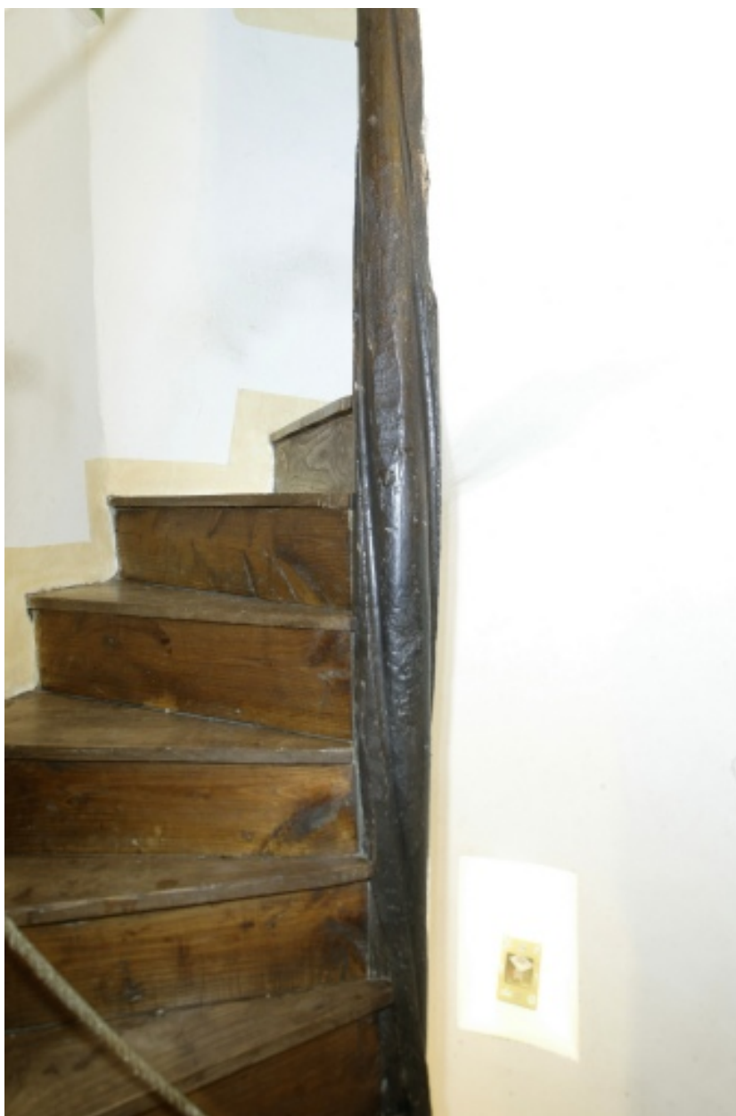
Escalier vu depuis le rez-de-chaussée.
