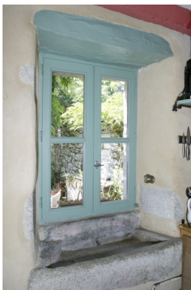
Evier en granite au rez-de- chaussée dans la partie sur jardin. Phot. Denis Pillet IVR52_20074400935NUCA
