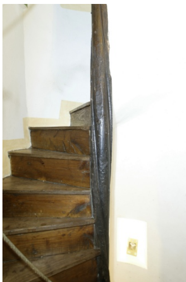
Escalier vu depuis le rez-de-chaussée. Phot. Denis Pillet IVR52_20074400941NUCA
