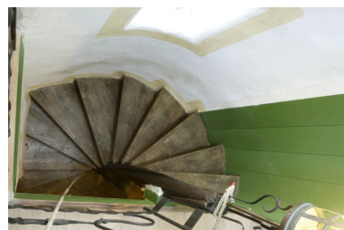
Escalier vu depuis le comble. Phot. Denis Pillet IVR52_20074400939NUCA
