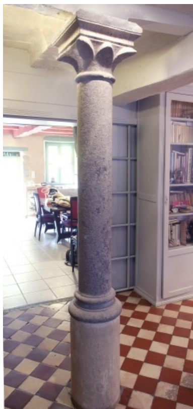
Colonne au rez-de-chaussée. Phot. Denis Pillet IVR52_20074400942NUCA
