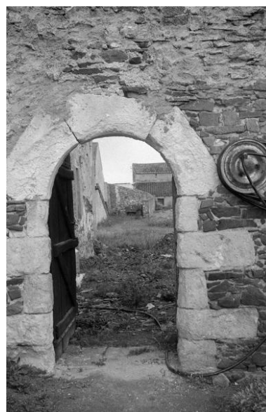
Le Dodineau. "Le Logis". Détail de la porte d'entrée en 1972. Phot. Marie-Anne Eon IVR52_19724900571Z
