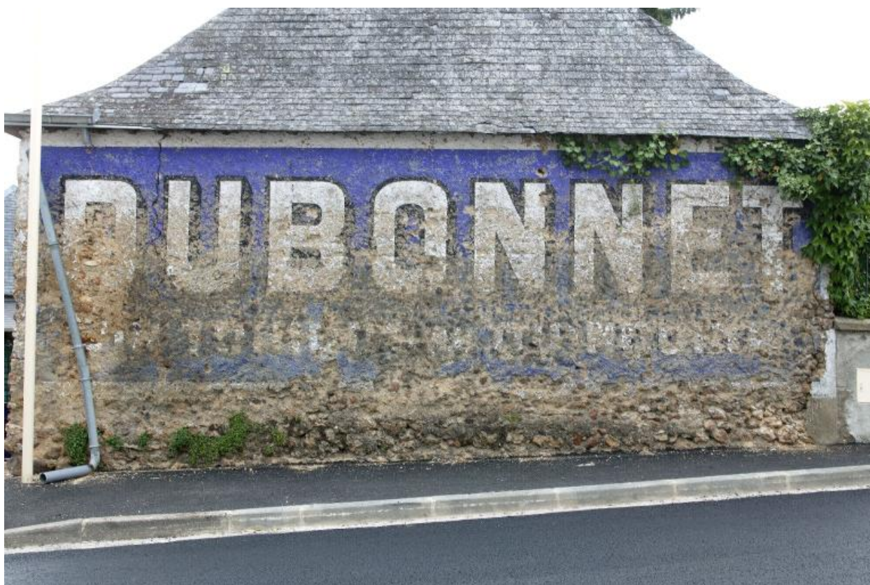
Pignon de la grange.
