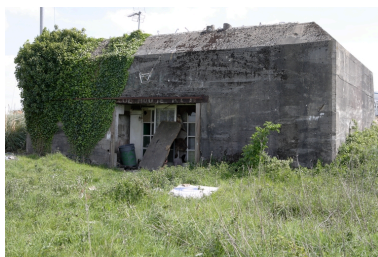
Vue de la casemate n° 4 . Phot. Denis Pillet IVR52_20104401054NUCA
