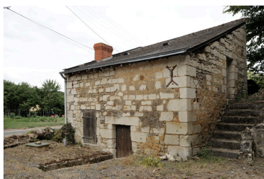
Maison et escalier d'accès au comble Phot. Bruno Rousseau, Phot. Youenn Communeau IVR52_20114902084NUCA
