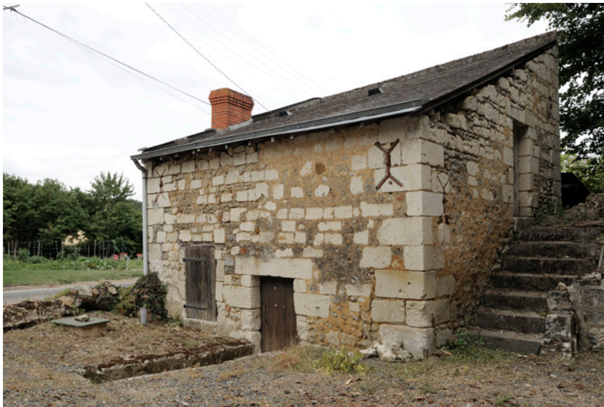
Maison et escalier d'accès au comble
