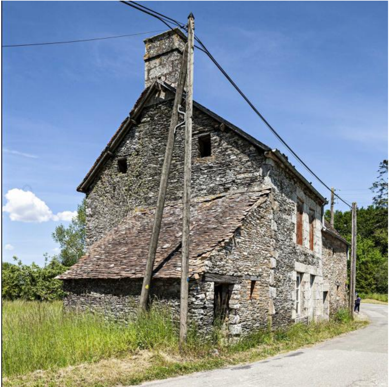
4 Bourgeray (2023 ZH 70), remise en appentis contre maison
