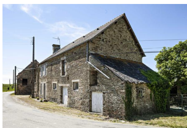
2 Bourgeray (2023 ZH 72), étable-grange et remise Phot. Yves Guillotin IVR52_20215300704NUCA
