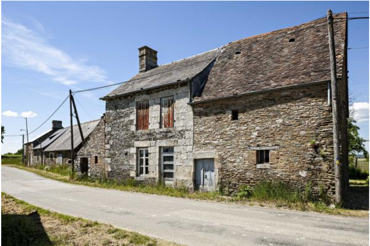
4 Bourgeray (2023 ZH 70), remise, maison et étable-grange
