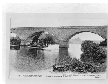
Vue rapprochée de l'arche centrale et de l'arche joignant la rive droite depuis la rive droite en amont. Autr. Léon et Lévy, Autr. Chasseray, Repro. François Lasa IVR52_20025301186X
