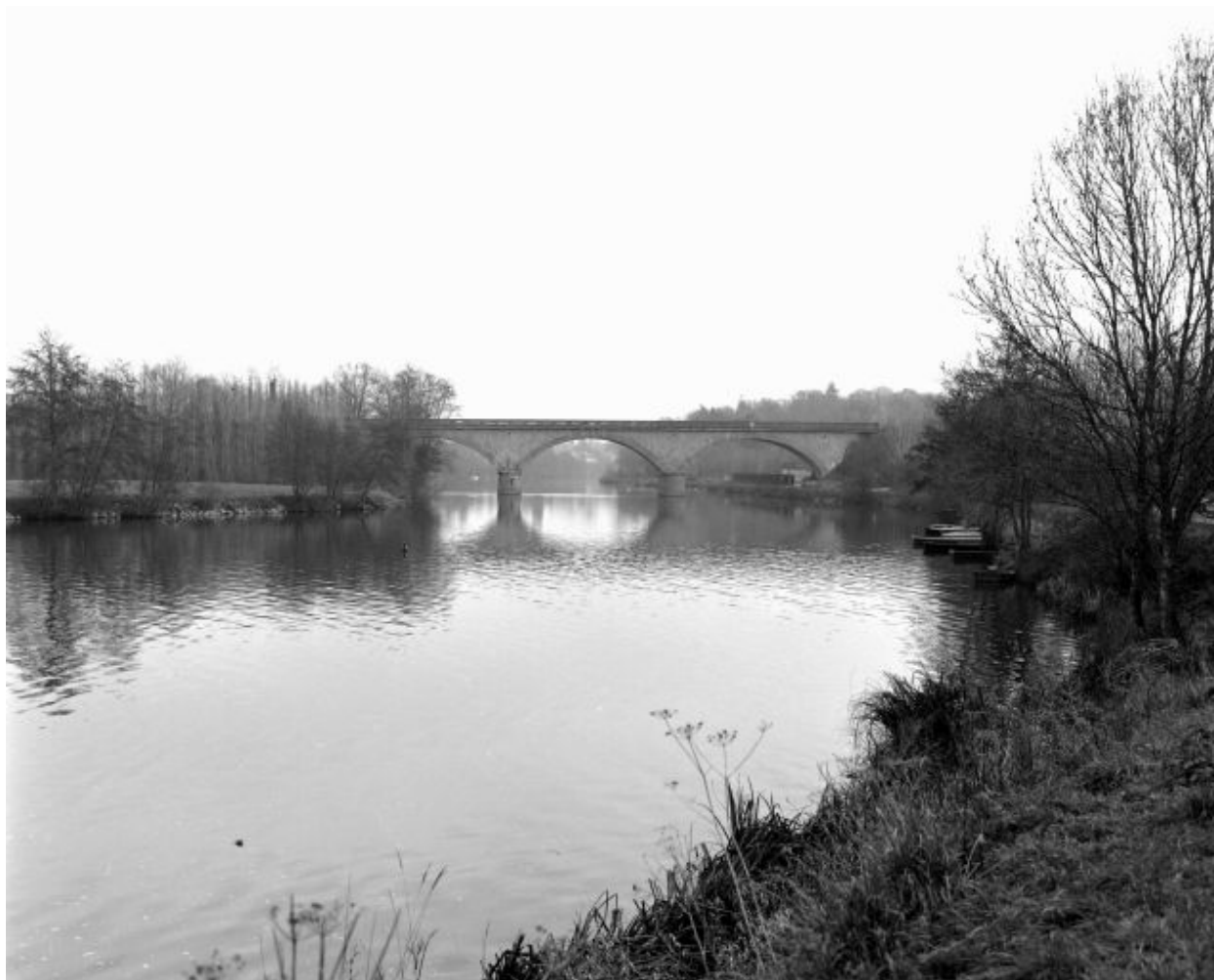
Vue depuis la rive droite en amont.
