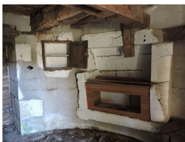
Vue intérieure du moulin, au rez-de-chaussée, en direction du nord-est : niches. Phot. Yannis Suire IVR52_20198502981NUCA
