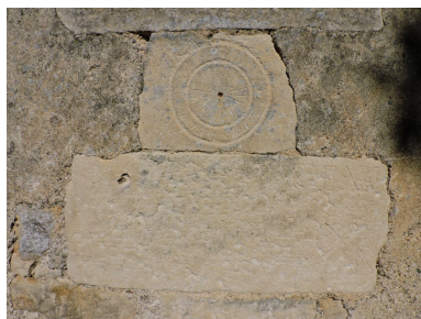
Graffitis et inscription sur le chaînage au sud-est du moulin : cadran solaire, mot Pageau, toit et ailes de moulin. Phot. Yannis Suire IVR52_20198502972NUCA
