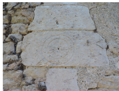
Graffiti sur une pierre au sud- ouest du moulin : cadran solaire. Phot. Yannis Suire IVR52_20198502976NUCA
