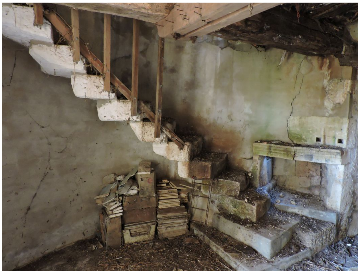
Vue intérieure du moulin, au rez-de-chaussée, en direction du nord-ouest : escalier.
