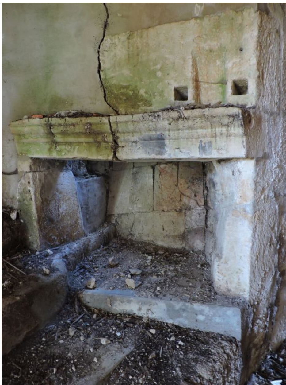
Cheminée au rez-de-chaussée du moulin, côté nord.
