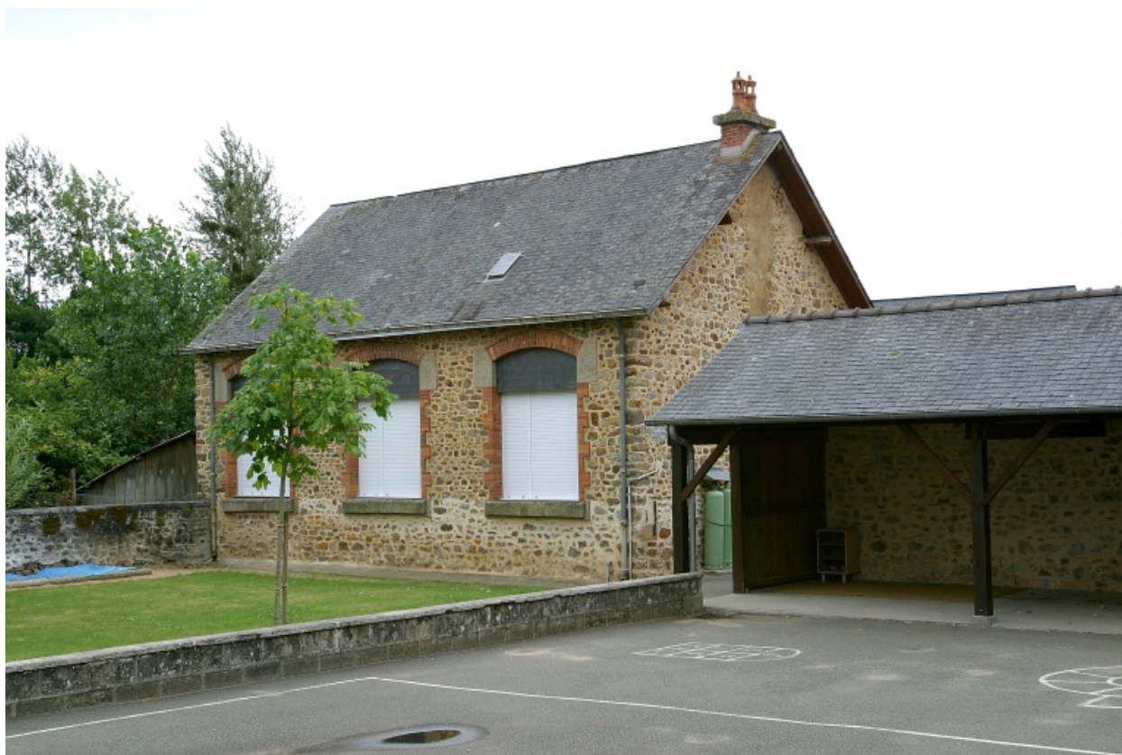
Seconde classe, aujourd'hui cantine : l'élévation principale vue depuis la route de Saint-Pierre au nord-ouest. A droite le préau donnant sur la première cour.
