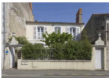
Façade sud, sur cour antérieure. Phot. Patrice Giraud IVR52_20098500198NUCA
