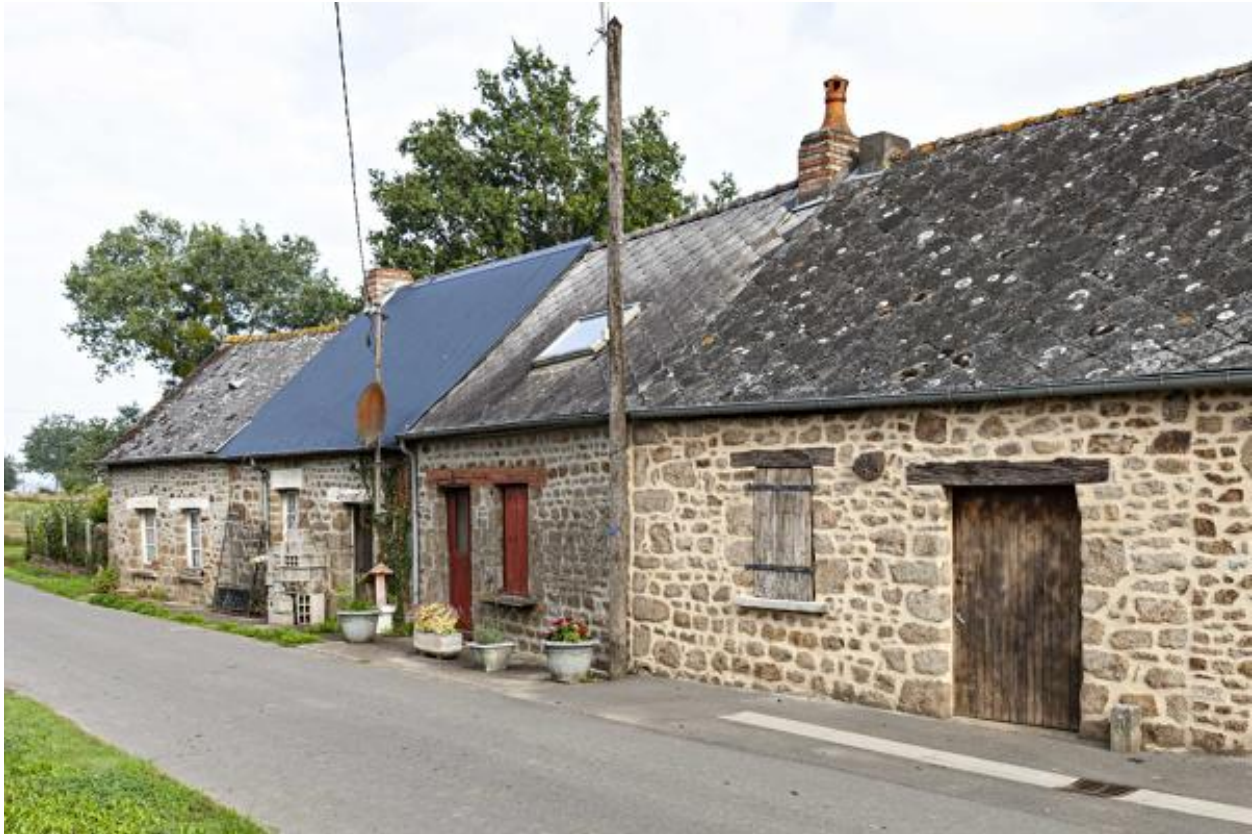
Hameau de la Flandrière, alignement de maisons et d'étables au nord de la route.
