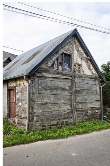
Hameau de la Flandrière, ancienne maison en pan de bois, fin du XVIIIe siècle ? Phot. Yves Guillotin IVR52_20215301538NUCA
