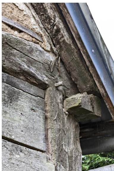
Hameau de la Flandrière, détail de l'assemblage du pan de bois d'une ancienne maison. Phot. Yves Guillotin IVR52_20215301539NUCA
