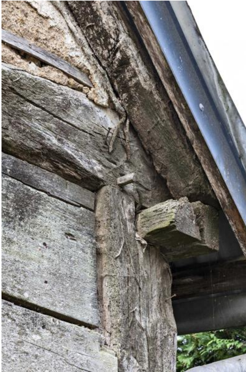
Hameau de la Flandrière, détail de l'assemblage du pan de bois d'une ancienne maison.
