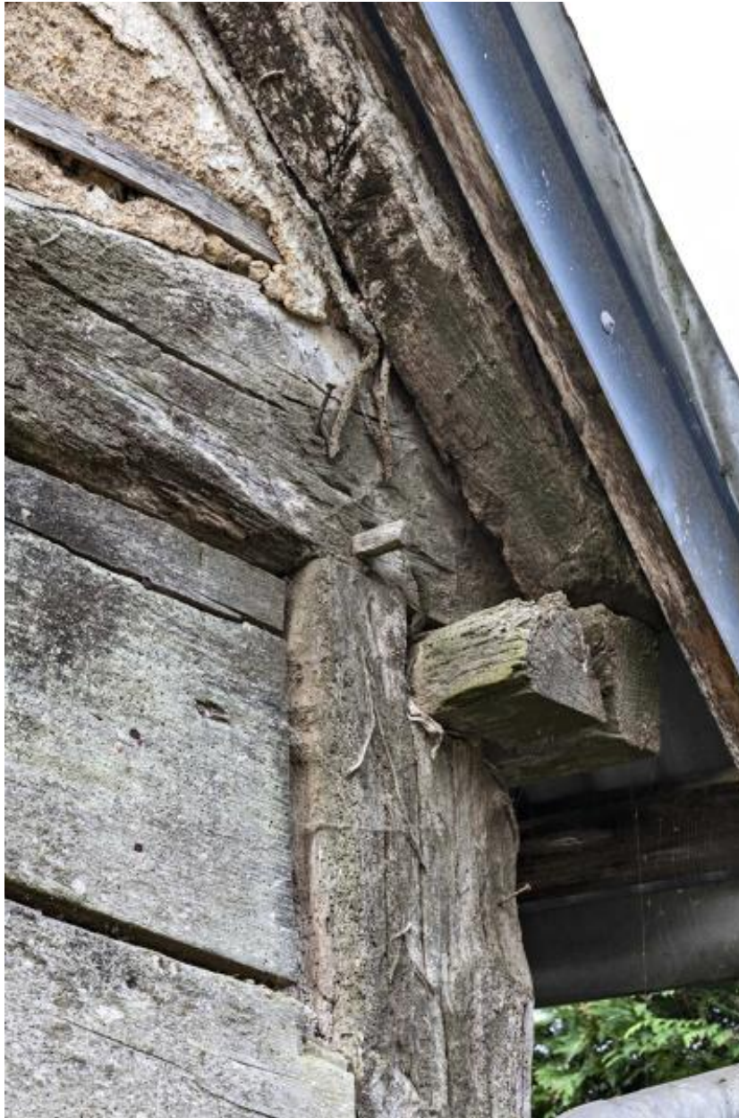
Hameau de la Flandrière, détail de l'assemblage du pan de bois d'une ancienne maison.
