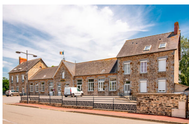
Mairie-école, vue d'ensemble. Phot. Pierre-Bernard Fourny IVR52_20235300861NUCA
