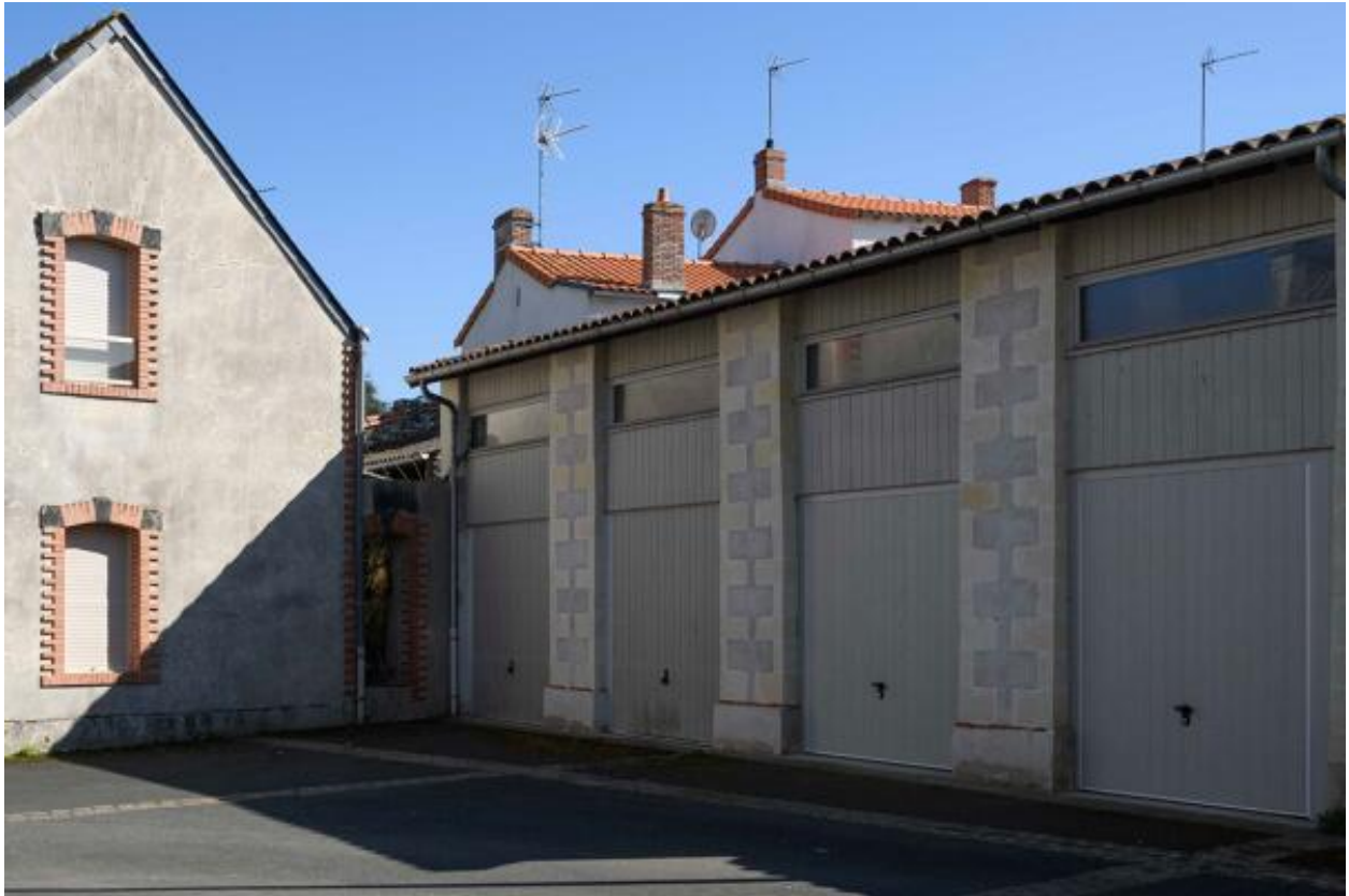
Vue de l'ancienne grange.
