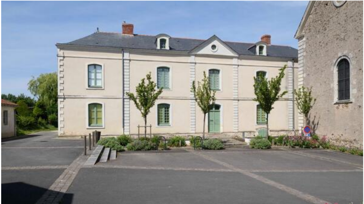
Vue de la façade sur cour.
