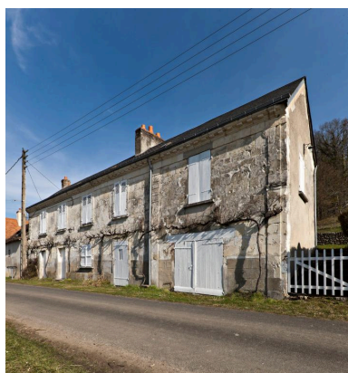
Maison vue de volume depuis le sud-ouest. Phot. Yves Guillotin IVR52_20127200079NUCA
