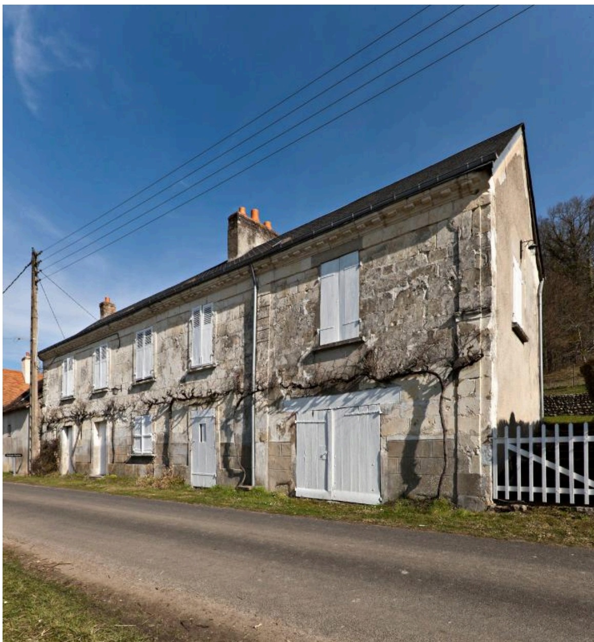
Maison vue de volume depuis le sud-ouest.
