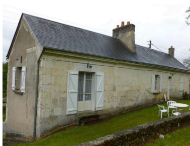
Maison, façade est : étage de plain-pied. Phot. Stéphanie Aquilon IVR52_20117201685NUCA
