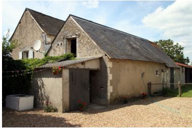
Les dépendances en face de la vieille maison. Phot. Jean-Baptiste Darrasse IVR52_20077201042NUCA
