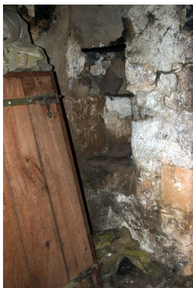
La vieille maison : niche à étagère près de la cheminée. Phot. Jean-Baptiste Darrasse IVR52_20077201040NUCA
