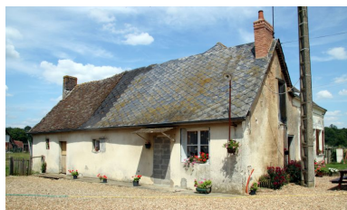
Vue d'ensemble de la vieille maison. Phot. Jean-Baptiste Darrasse IVR52_20077201035NUCA
