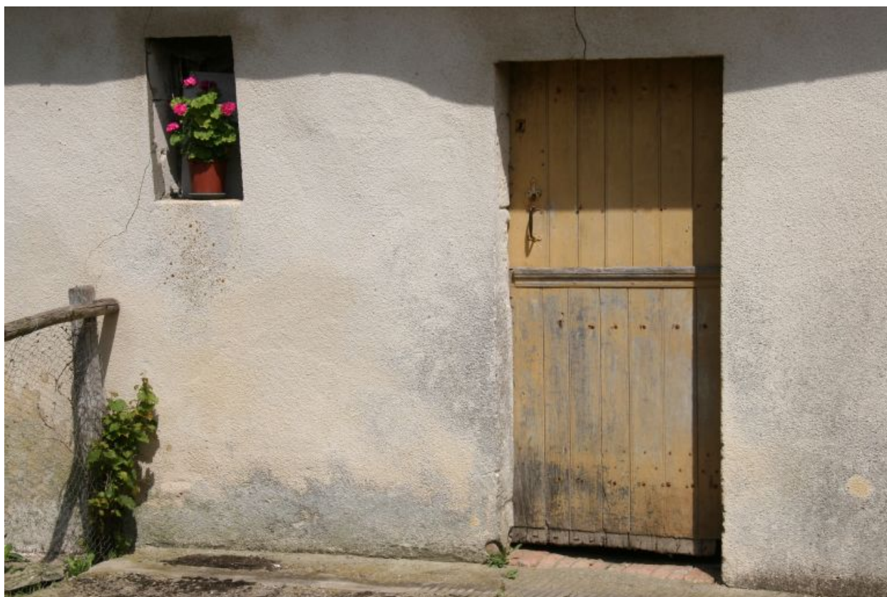
La vieille maison : porte et fenêtre de la chambre à feu.
