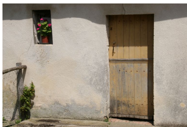
La vieille maison : porte et fenêtre de la chambre à feu. Phot. Jean-Baptiste Darrasse IVR52_20077201036NUCA
