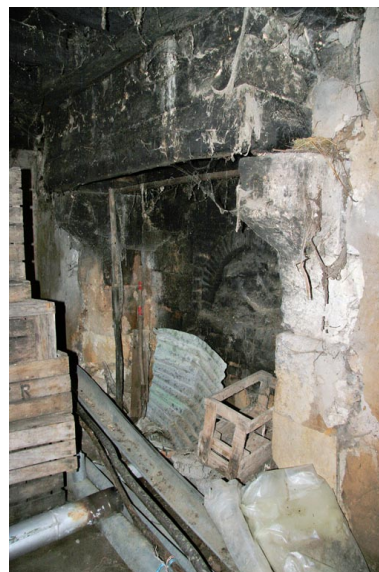
La vieille maison : cheminée à hotte droite sur corbeau de pierre sans saillie des piédroits. Phot. Jean-Baptiste Darrasse IVR52_20077201039NUCA
