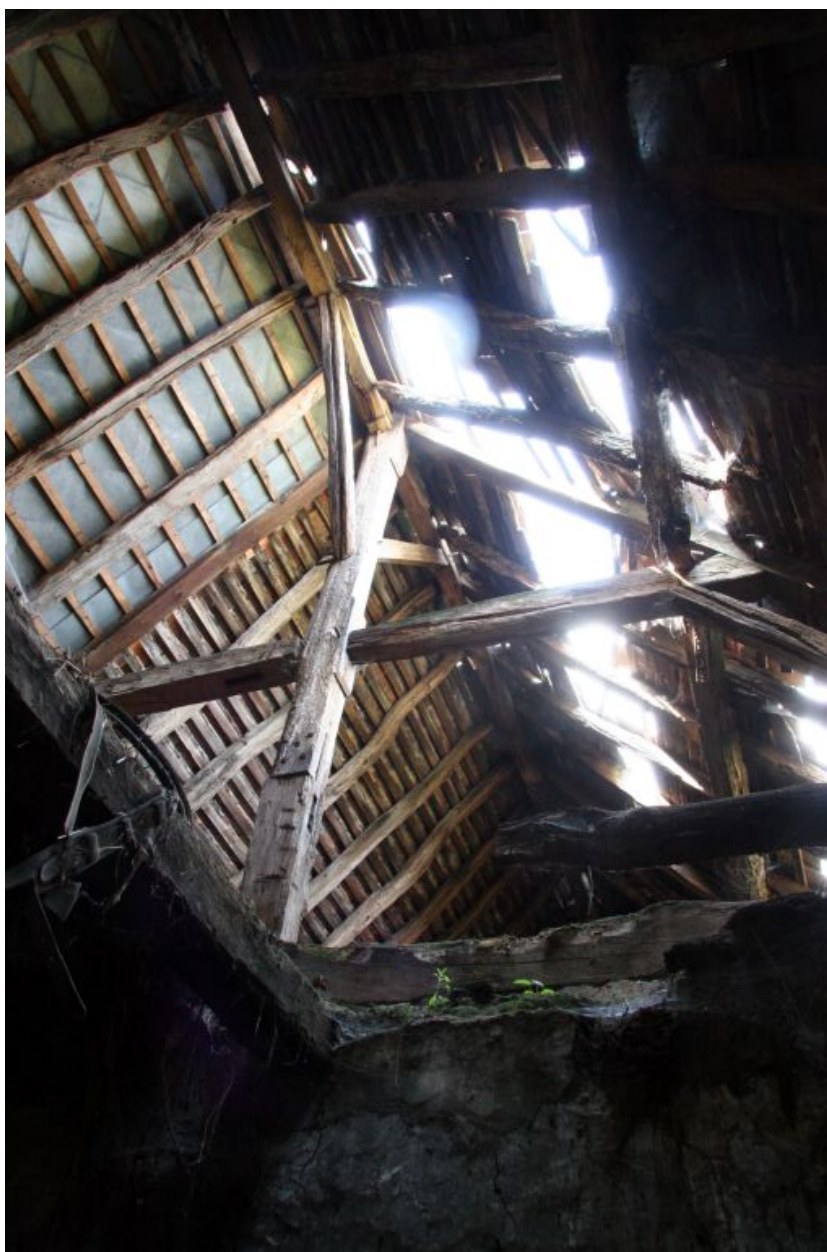
La vieille maison : charpente à pannes avec faux entrails à encoches (remaniée et consolidée).
