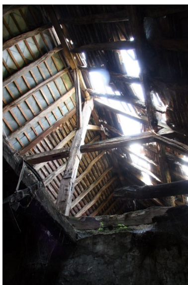
La vieille maison : charpente à pannes avec faux entrails à encoches (remaniée et consolidée). Phot. Jean-Baptiste Darrasse
