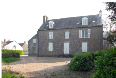
Vue de la façade sur jardin vers l'Est. Phot. Denis Pillet IVR52_20074400524NUCA
