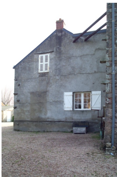
Vue du bâtiment accolé au corps principal. Phot. Denis Pillet IVR52_20074400526NUCA
