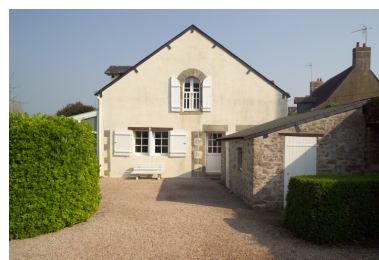
Vue de l'ancienne écurie vers le Nord. Phot. Denis Pillet IVR52_20074400527NUCA
