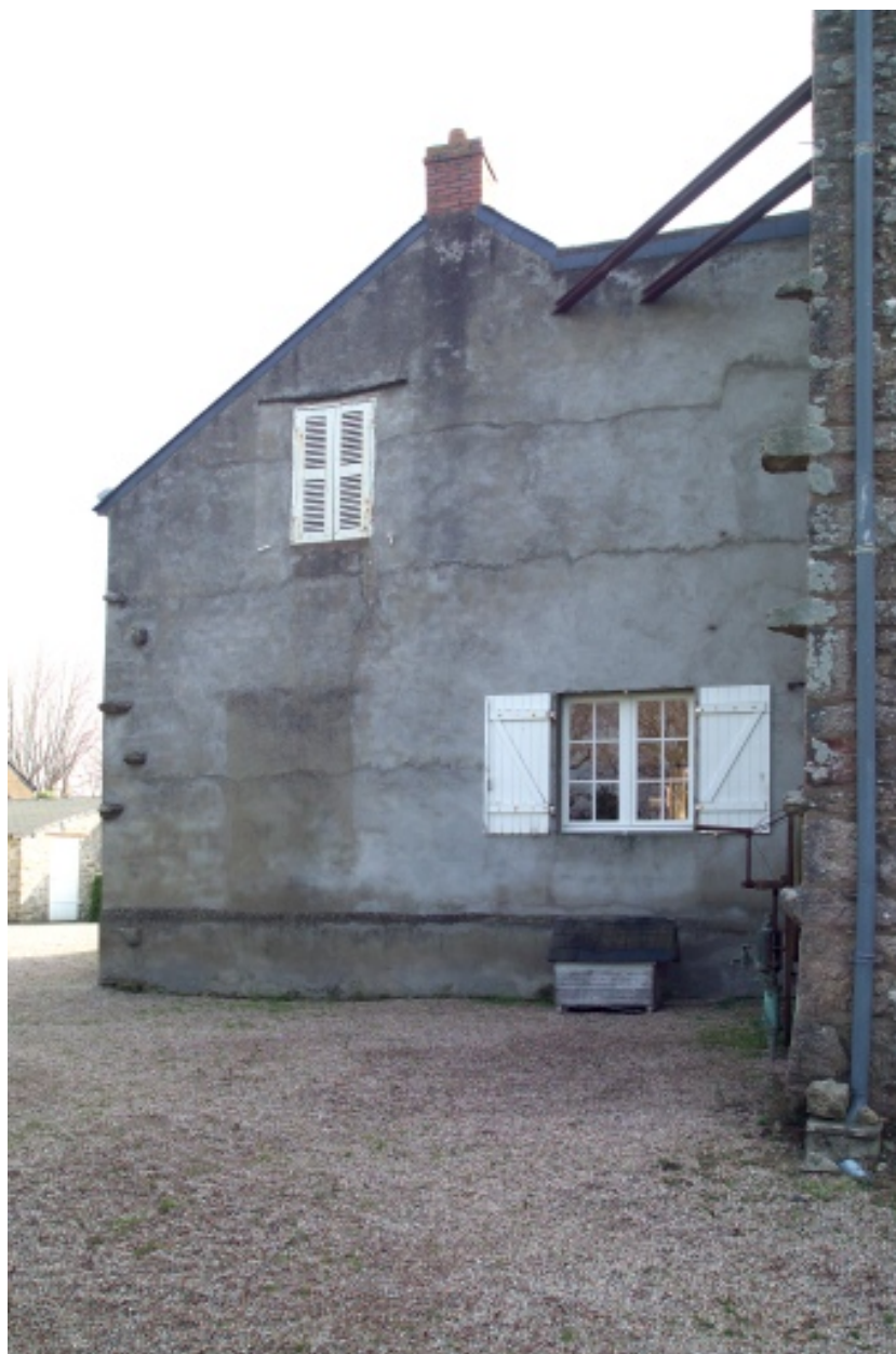
Vue du bâtiment accolé au corps principal.
