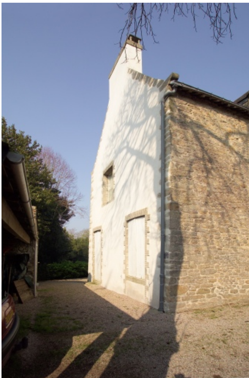
Vue du pignon sud vu vers l'Ouest.
