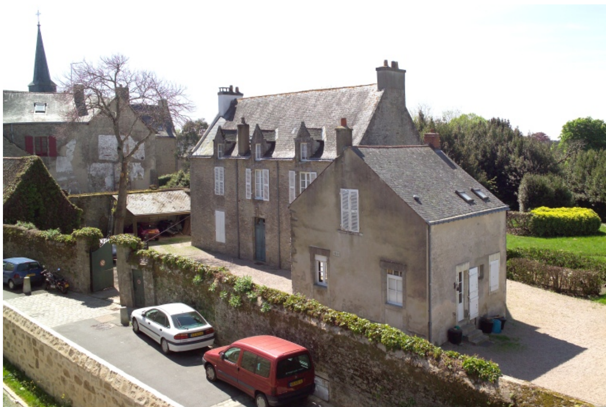
Vue générale vers le Sud-Ouest.
