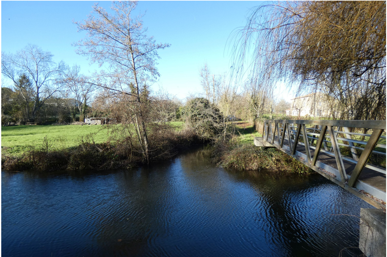
L'entrée du port sur la rive droite de la Rigole de la rive droite, franchie par une passerelle, vue depuis le sud.
