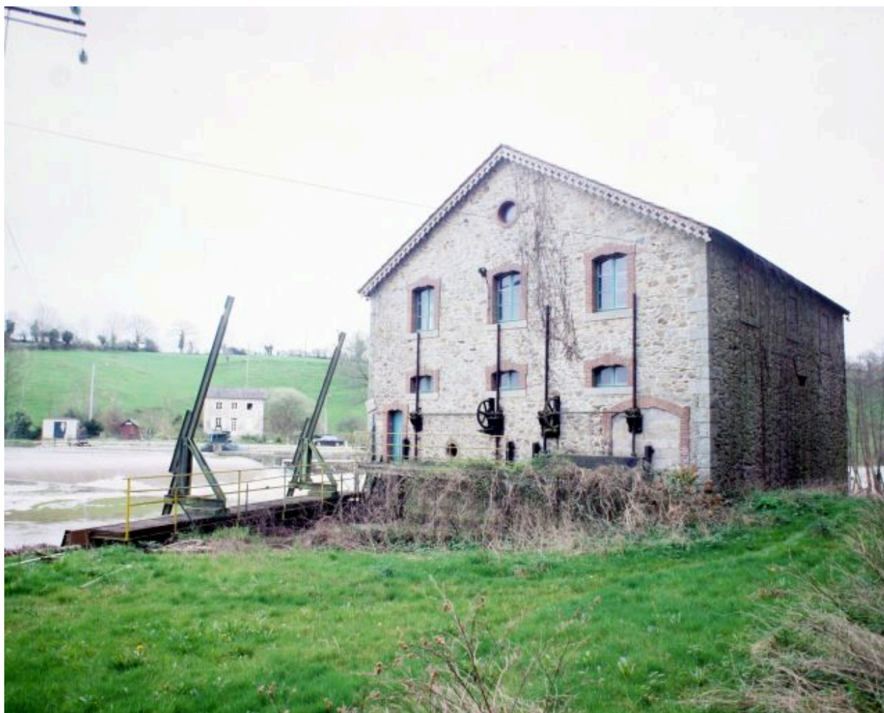
Façades nord et ouest.
