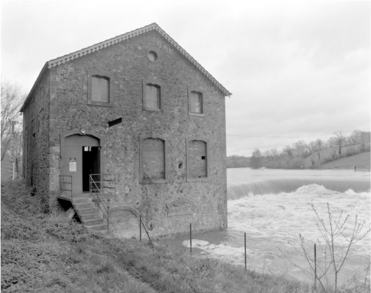
Façade sud (aval).
