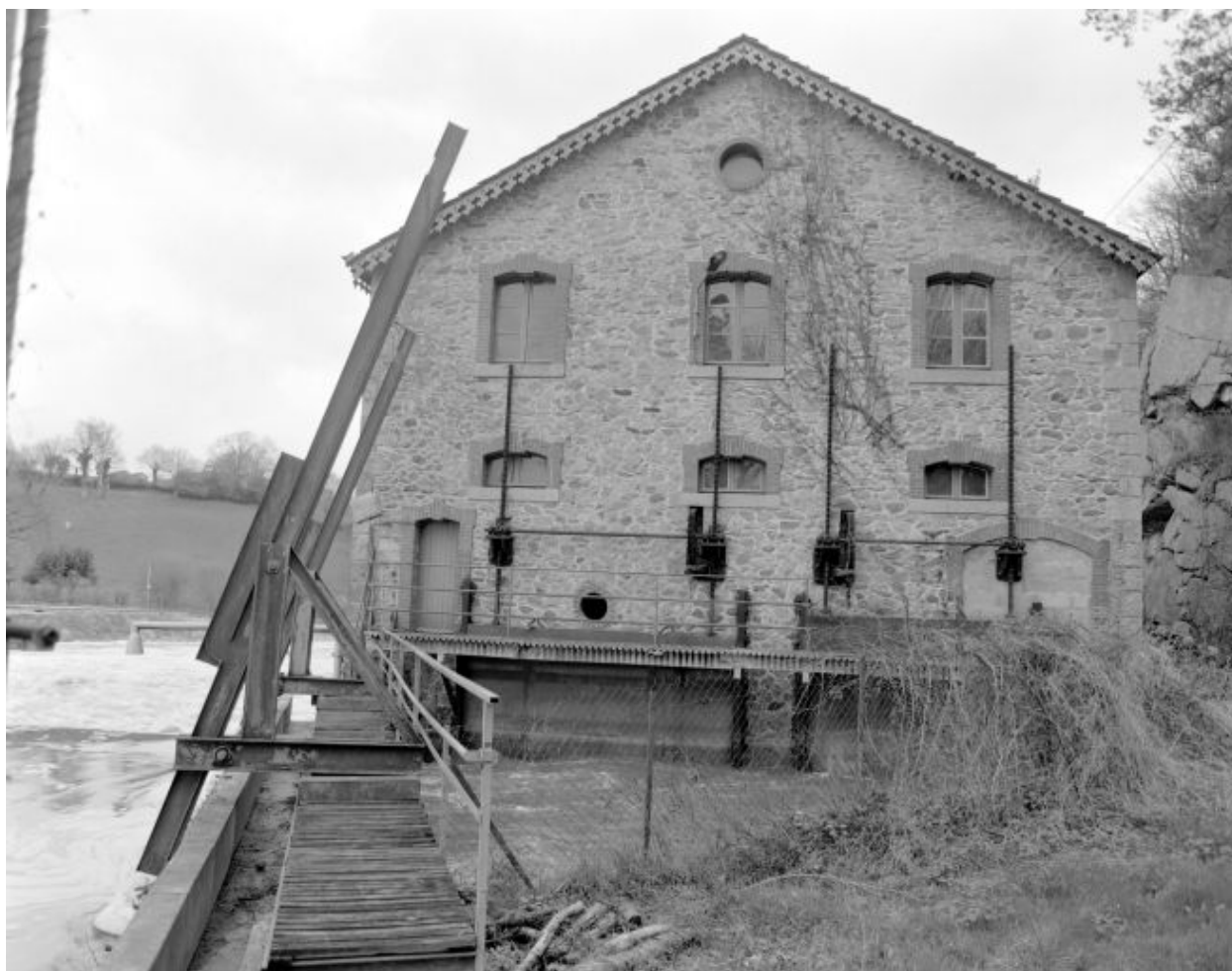
Façade nord (amont), canal d'alimentation et vannes motrices.
