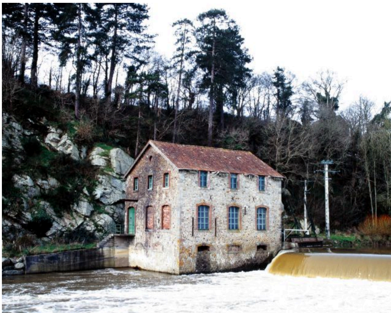
Vue de la rive gauche, en aval : façades sud et est.
