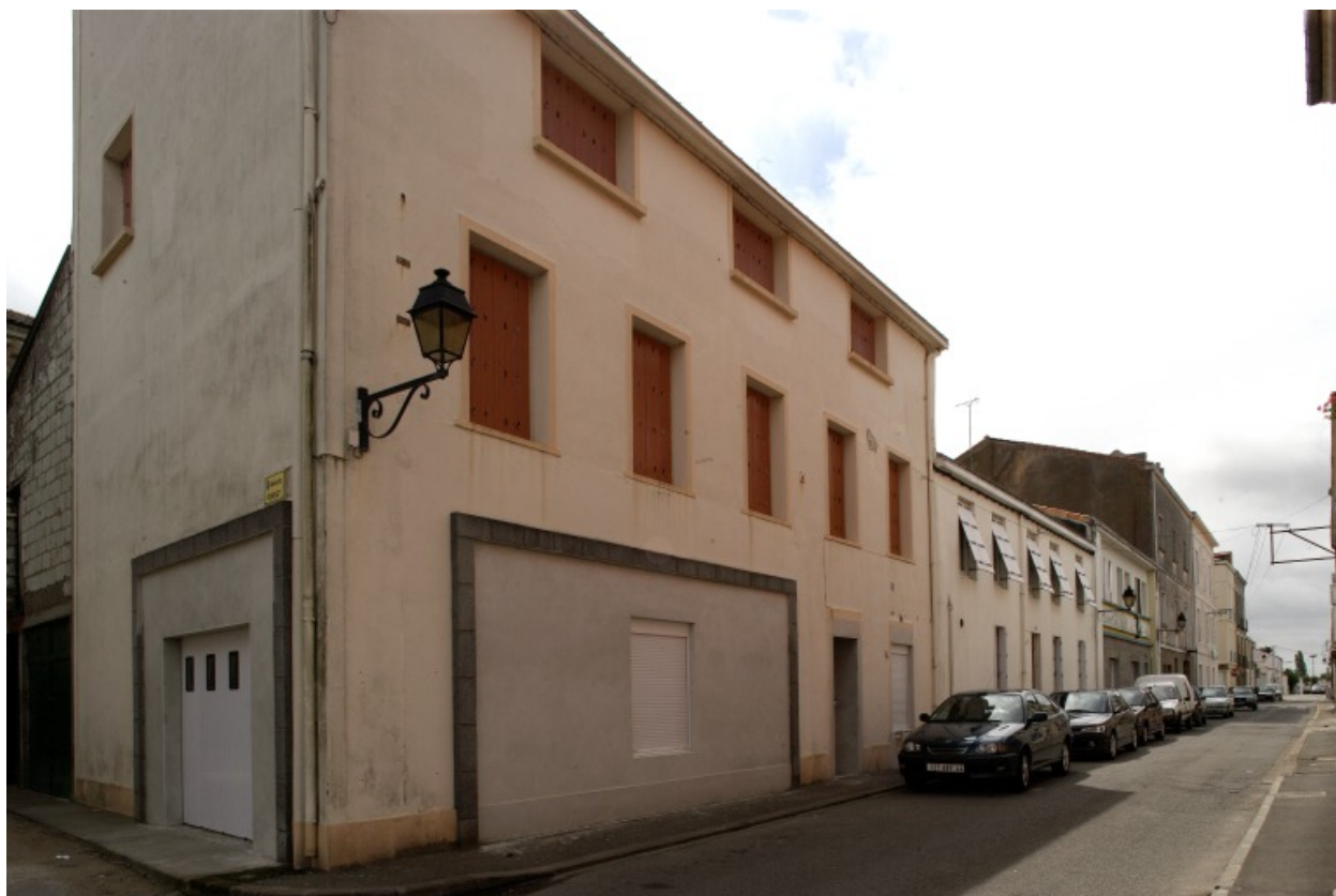
Vue de la rue Pasteur vers le sud depuis l'impasse Forest.
