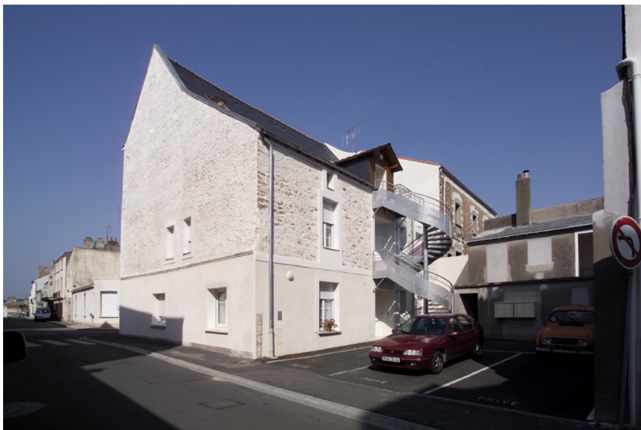
Le pignon et la façade postérieure vus depuis la rue Pierre-Jubau.
