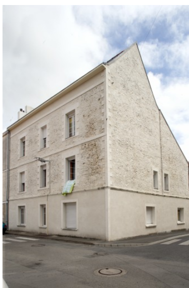
Vue d'ensemble de la maison n° 21. Phot. François Lasa IVR52_20054401123NUCA
