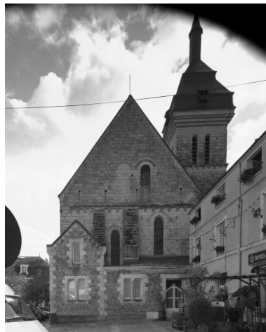
Pignon nord du chœur. Phot. Jean-Baptiste Darrasse IVR52_20047205876V
