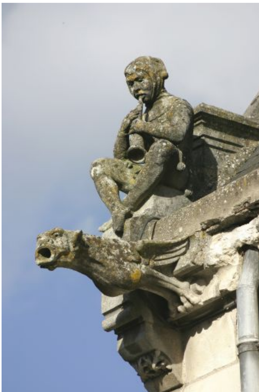
Façade postérieure à 1921 : sculpture.
