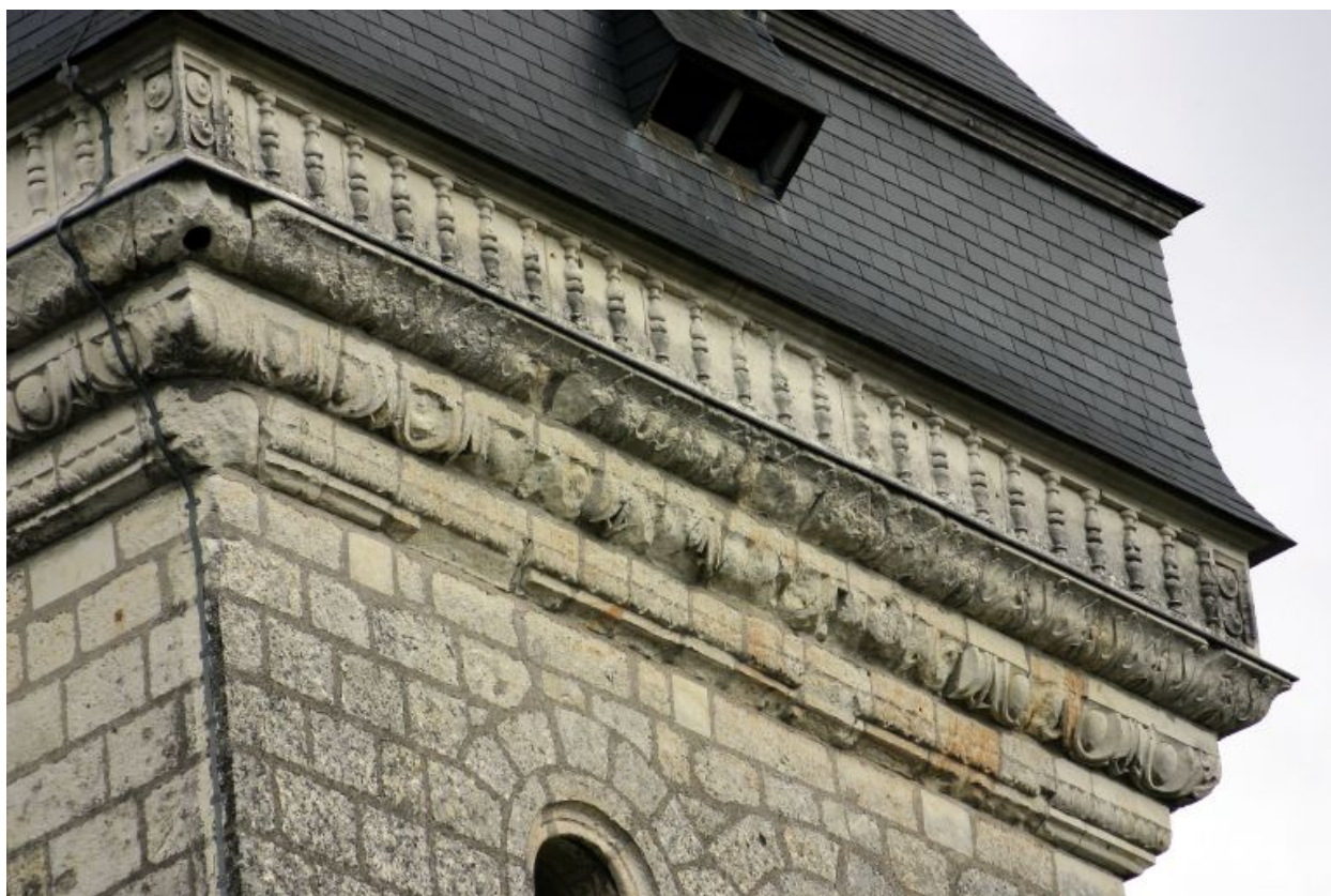
Le clocher : corniche d'oves et de dards.
