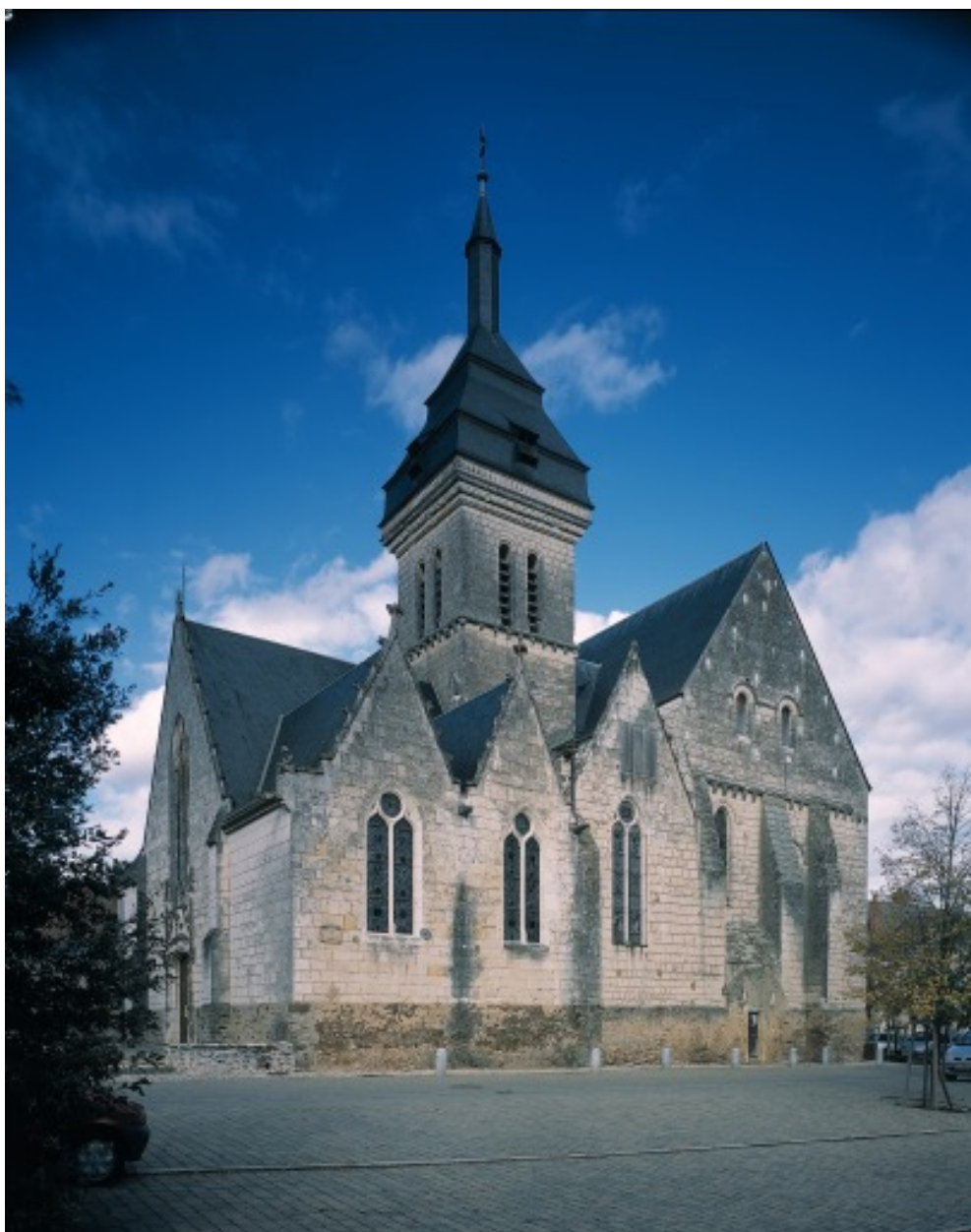
Eglise paroissiale Saint-Martin, vue de volume.
