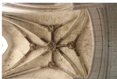
Bras droit du transept : voutes d'ogives avec Dieu le Père et les 4 évangélistes. Phot. Jean-Baptiste Darrasse IVR52_20047204047NUCA
