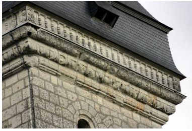
Le clocher : corniche d'oves et de dards. Phot. Jean-Baptiste Darrasse IVR52_20047204039NUCA
