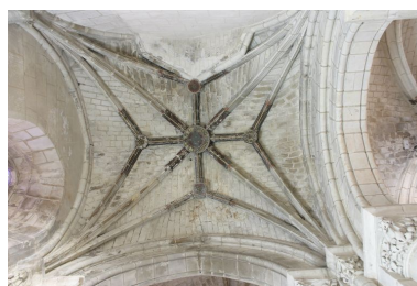
Bras gauche du transept : croisée d'ogives. Phot. Jean-Baptiste Darrasse IVR52_20047204048NUCA
