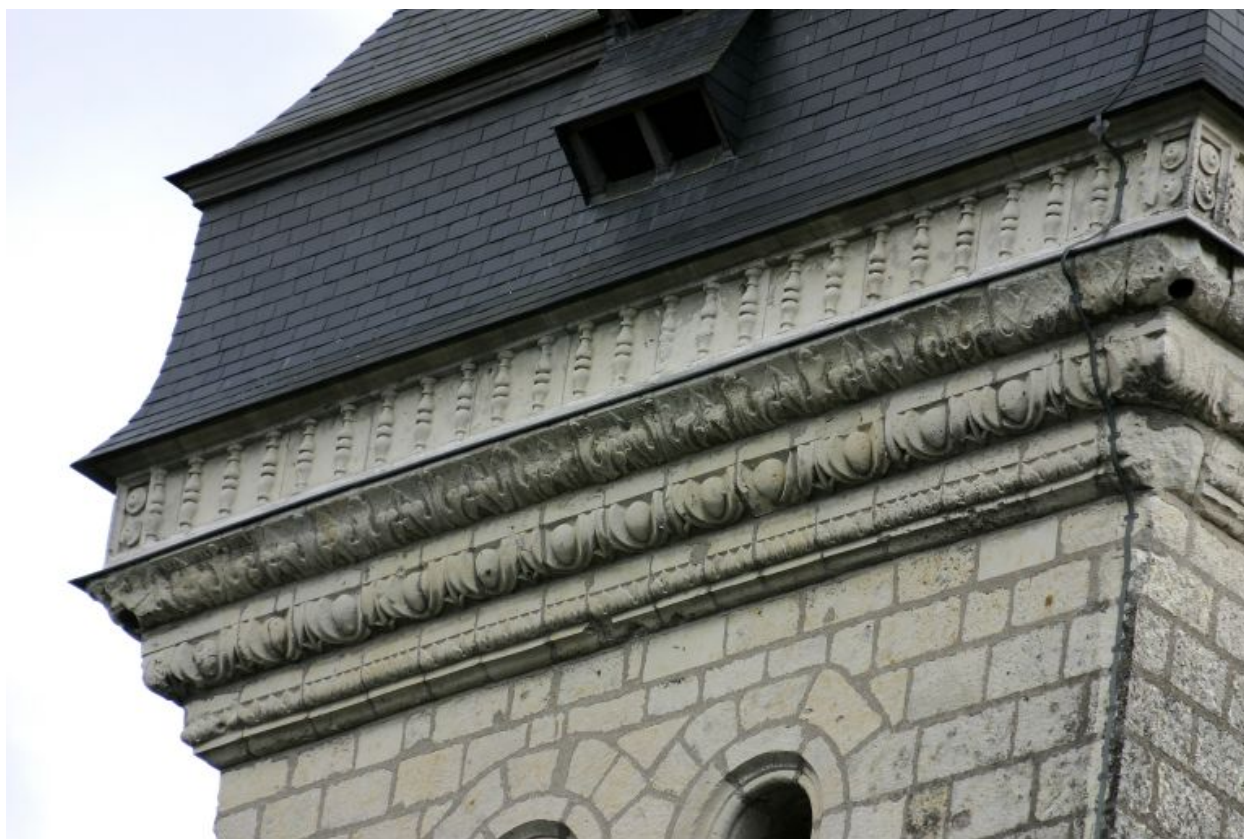
Le clocher : détail de la corniche.
