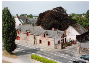
Vue générale des bâtiments bordant le boulevard de l'Abreuvoir et de la cour d'entrée. Phot. Denis (reproduction) Pillet IVR52_20074400214NUCA
