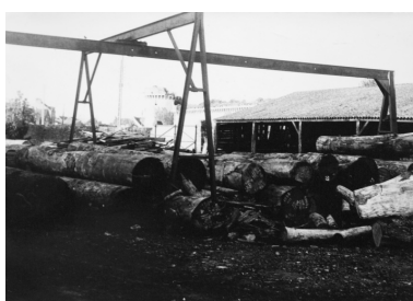
Grue déplaçant les grumes depuis l'aire de stockage vers la scierie. Phot. Denis (reproduction) Pillet IVR52_20074400207NUCA
