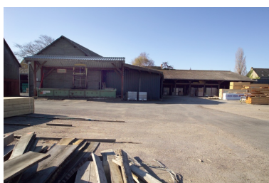
Aire de stockage et hangars récents. Phot. Denis Pillet IVR52_20074400588NUCA
