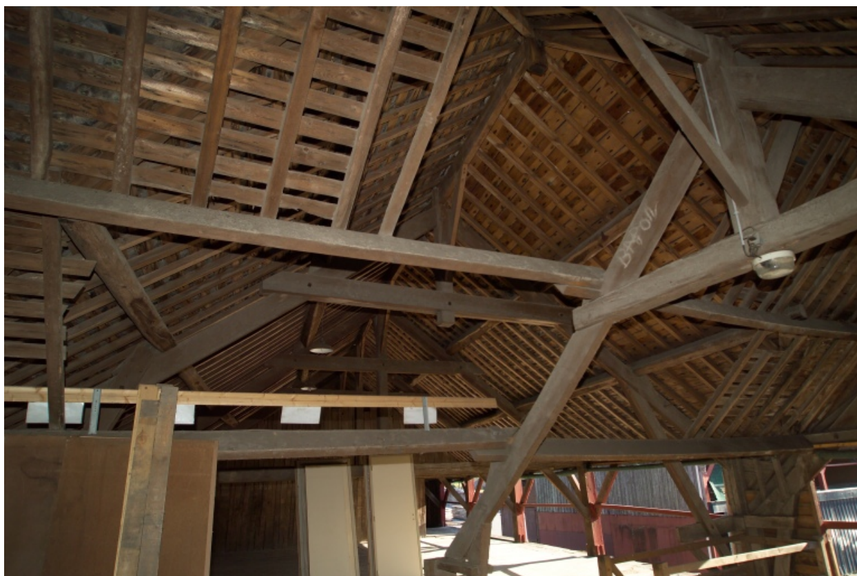
Cour d'entrée, détail de charpente d'un hangar.
