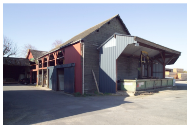
Vue du hangar de fond de la cour d'entrée. Phot. Denis Pillet IVR52_20074400583NUCA
