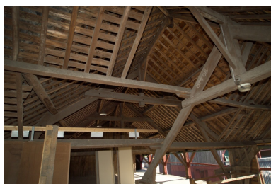
Cour d'entrée, détail de charpente d'un hangar. Phot. Denis Pillet IVR52_20074400575NUCA
