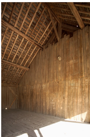
Cour d'entrée, étage de stockage d'un hangar. Phot. Denis Pillet IVR52_20074400579NUCA
