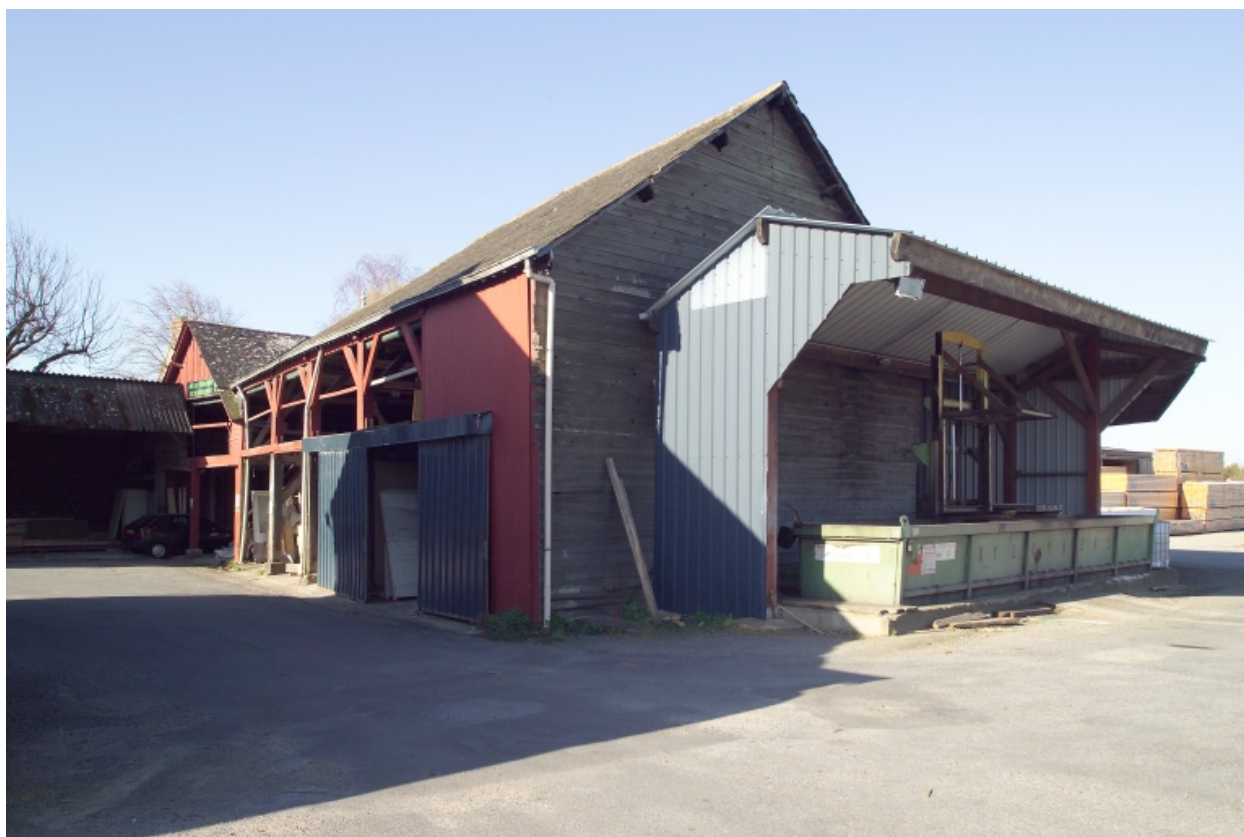
Vue du hangar de fond de la cour d'entrée.
