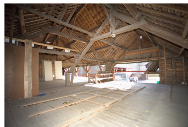
Cour d'entrée, étage de stockage d'un hangar. Phot. Denis Pillet IVR52_20074400574NUCA
