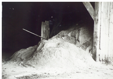
Hangar de stockage de la chaux. Phot. Denis (reproduction) Pillet IVR52_20074400196NUCA
