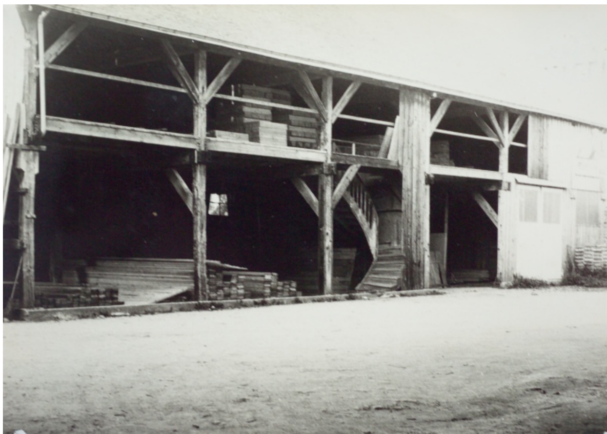
Hangar de stockage.
