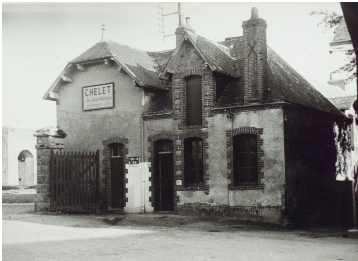
Bureau avant restauration.
