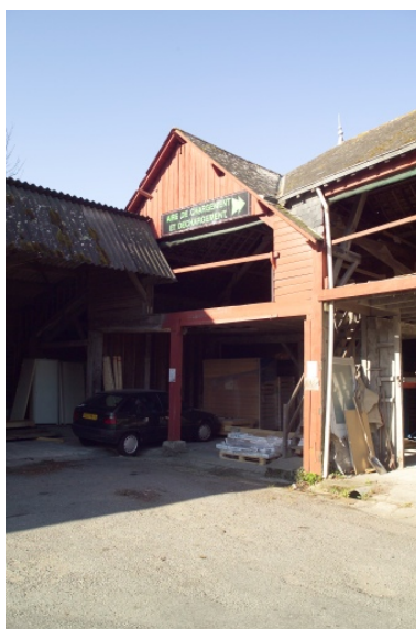
Cour d'entrée, détail de hangar. Phot. Denis Pillet IVR52_20074400581NUCA
