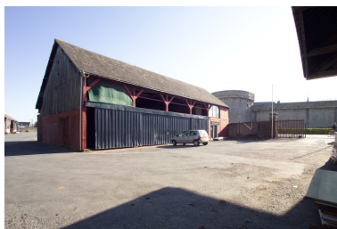
Cour d'entrée, hangar flanquant le portail. Phot. Denis Pillet IVR52_20074400596NUCA
