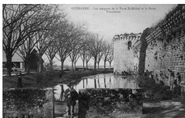
Carte postale du début du XXe siècle figurant les hangars bordant le boulevard. Phot. Denis (reproduction) Pillet IVR52_20074400210NUCA
