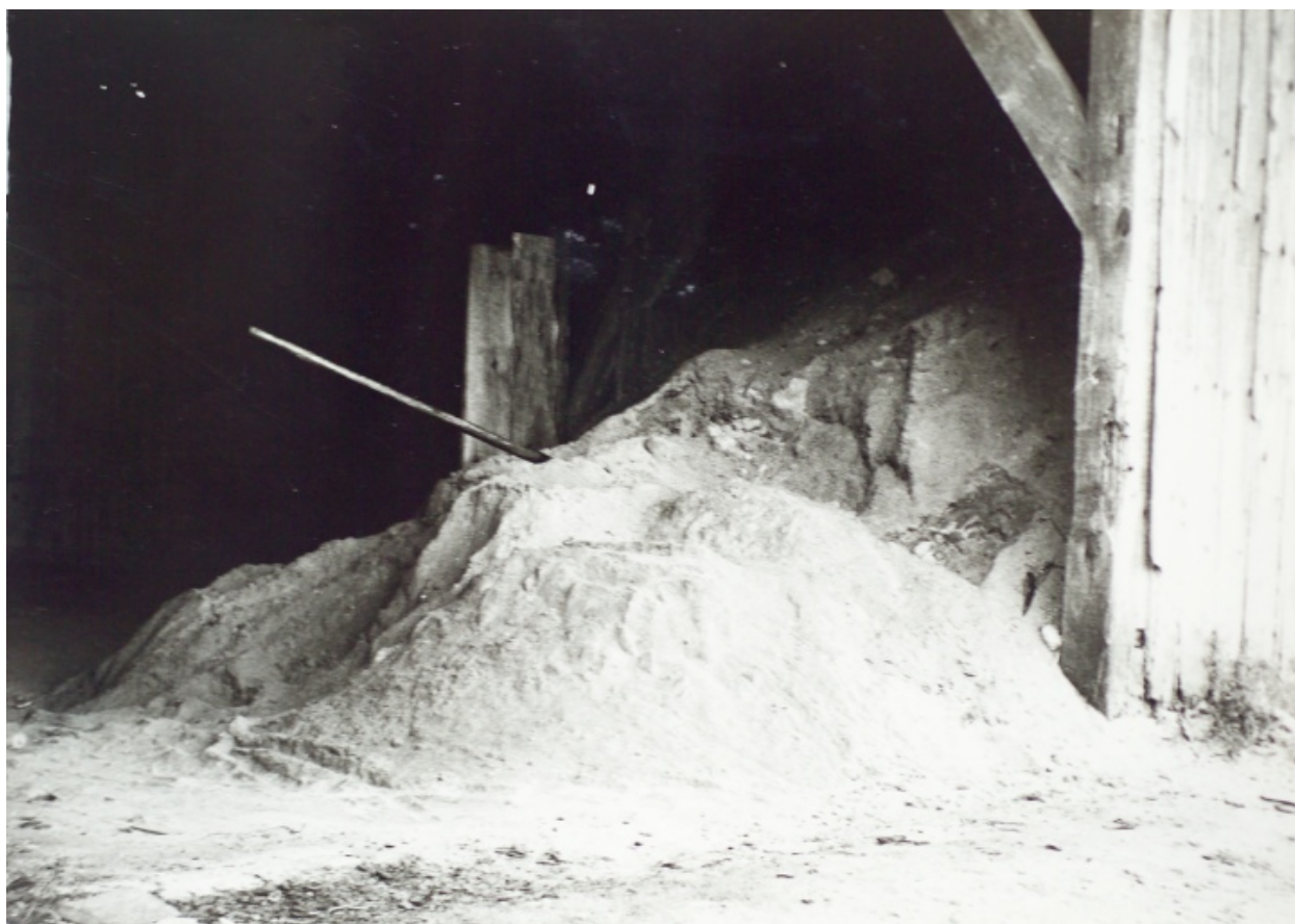
Hangar de stockage de la chaux.
