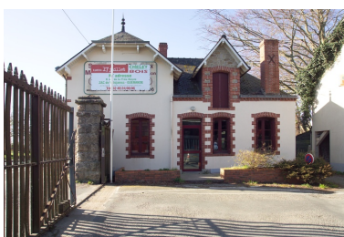
Bureau. Phot. Denis Pillet IVR52_20074400593NUCA
