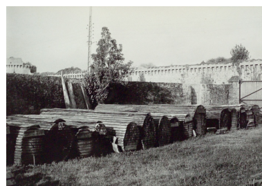
Grumes débitées. Phot. Denis (reproduction) Pillet IVR52_20074400201NUCA
