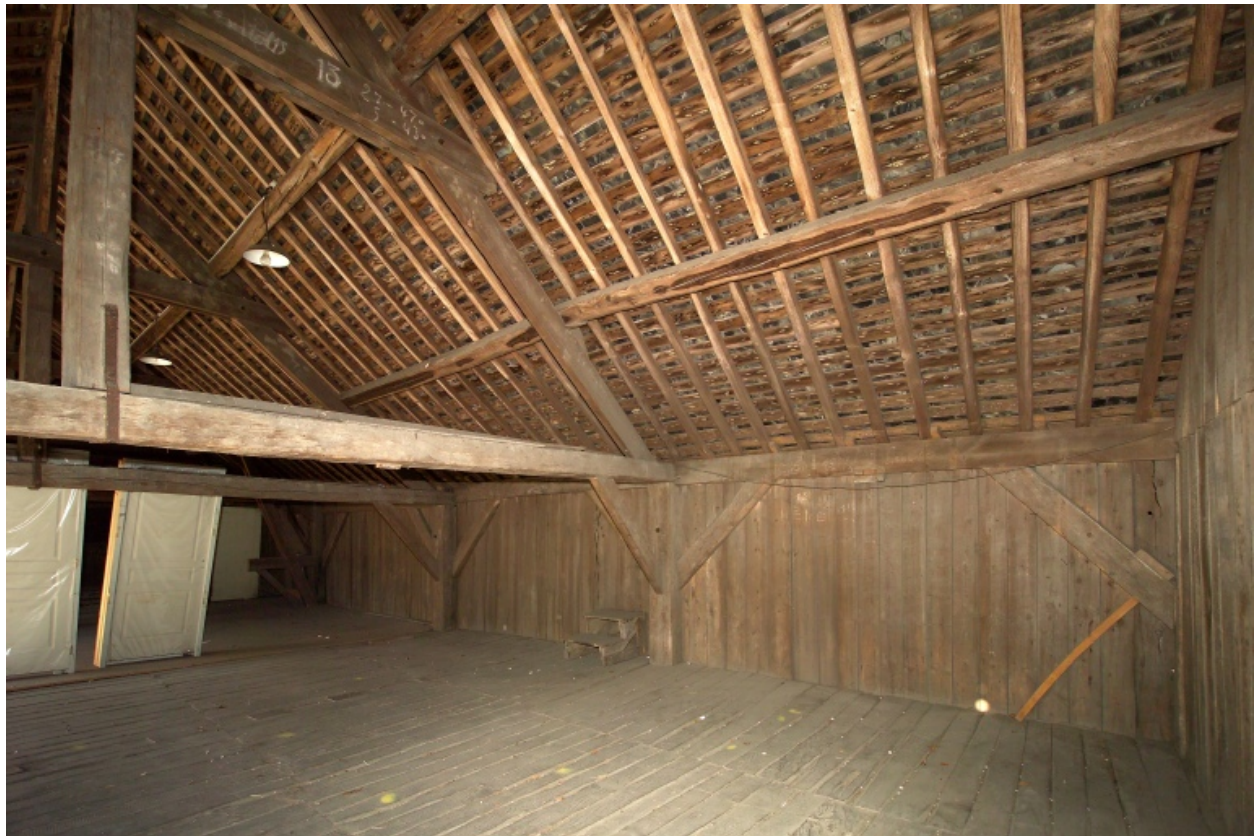
Cour d'entrée, détail de charpente d'un hangar.
