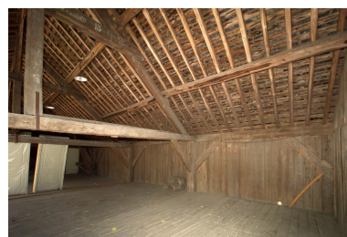
Cour d'entrée, détail de charpente d'un hangar. Phot. Denis Pillet IVR52_20074400580NUCA
