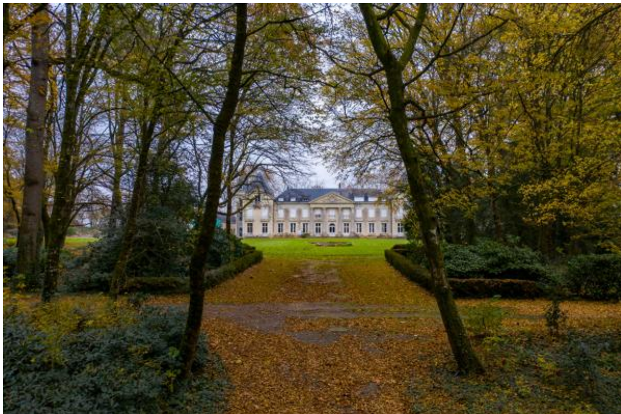
Vue de la façade postérieure depuis l'allée centrale.
