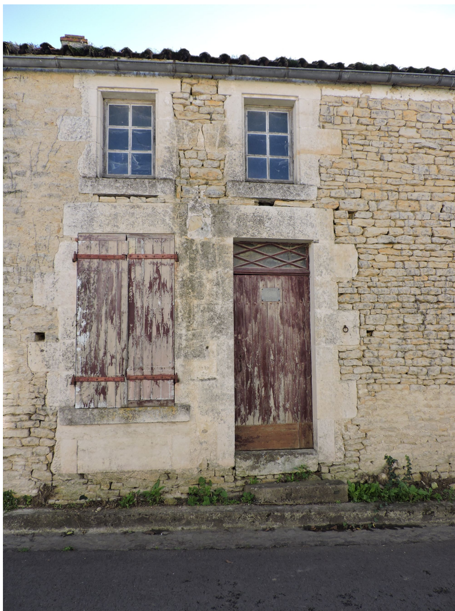
Les deux travées d'ouvertures de la façade du logis.
