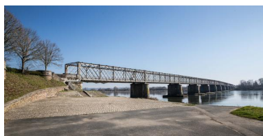
Vue générale depuis la rive nord. Phot. Pierre-Bernard Fourny IVR52_20194400165NUCA
