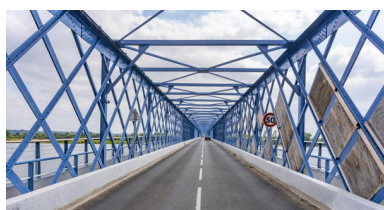
Vue du tablier et de la cage après les travaux de restauration. Phot. Pierre-Bernard Fourny IVR52_20214400900NUCA
