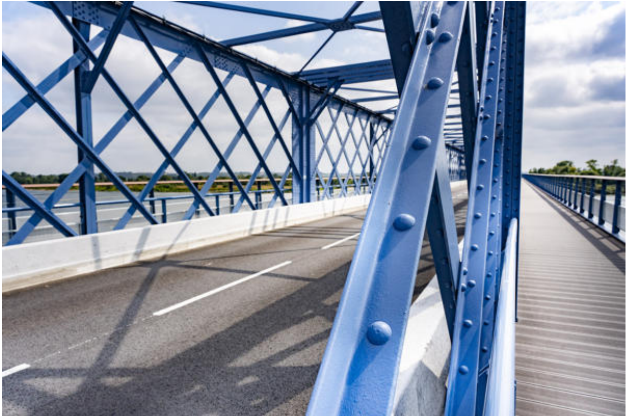
Vue de détail des rivets de la charpente métallique.
