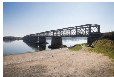
Vue générale depuis la rive nord. Phot. Pierre-Bernard Fourny IVR52_20194400167NUCA
