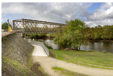
Vue du pont de la Pinsonnière en rive sud. Phot. Pierre-Bernard Fourny IVR52_20194401296NUCA
