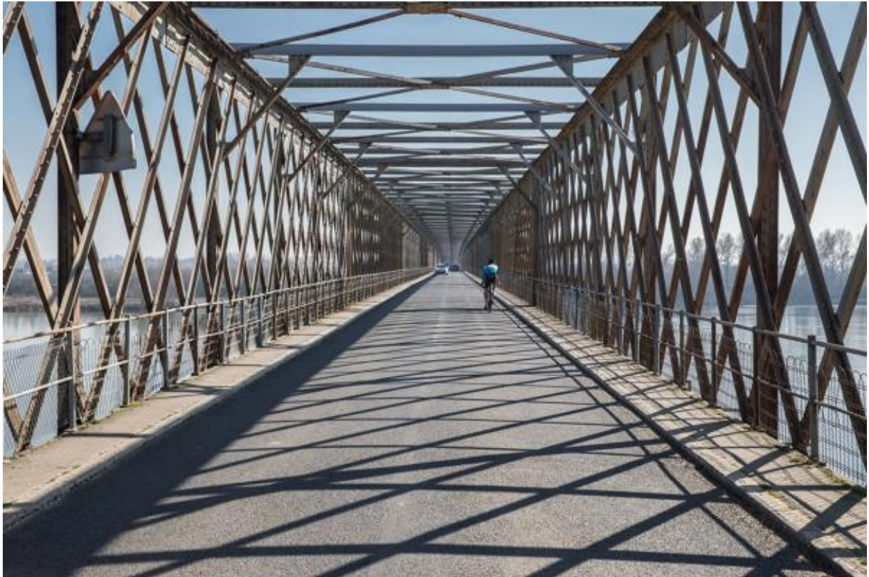
Vue du tablier et de la cage.
