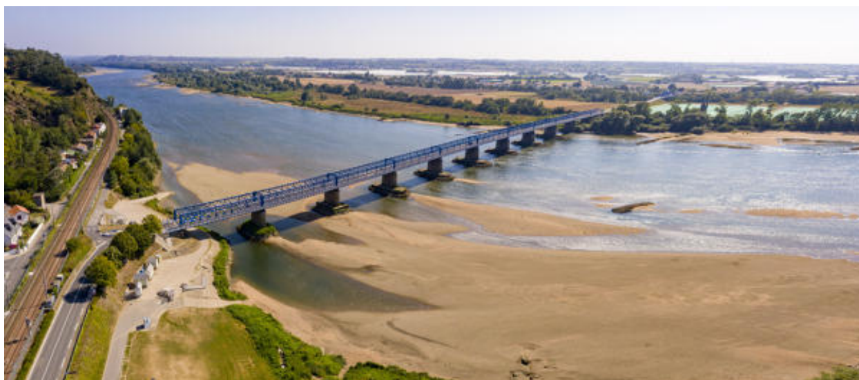
Vue aérienne des ponts de Mauves.
