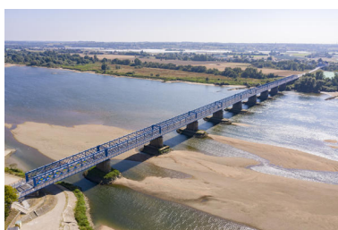
Vue aérienne des ponts de Mauves. Phot. Pierre-Bernard Fourny IVR52_20214400933NUCA
