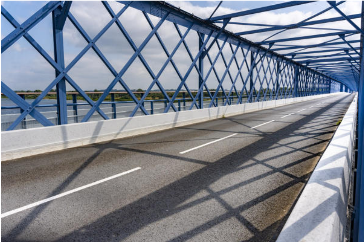
Vue de détail de la chaussée.
