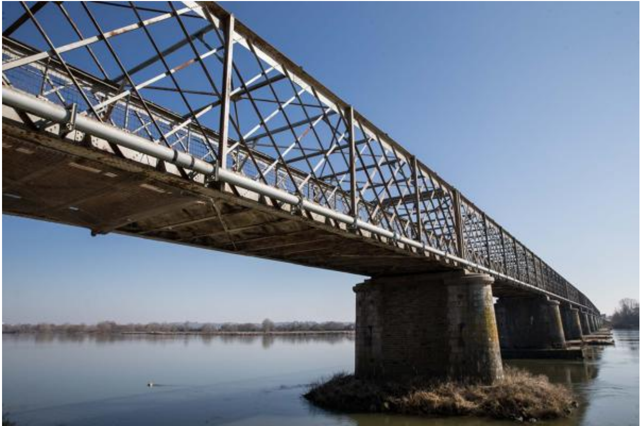
Piles et cage depuis la rive nord.
