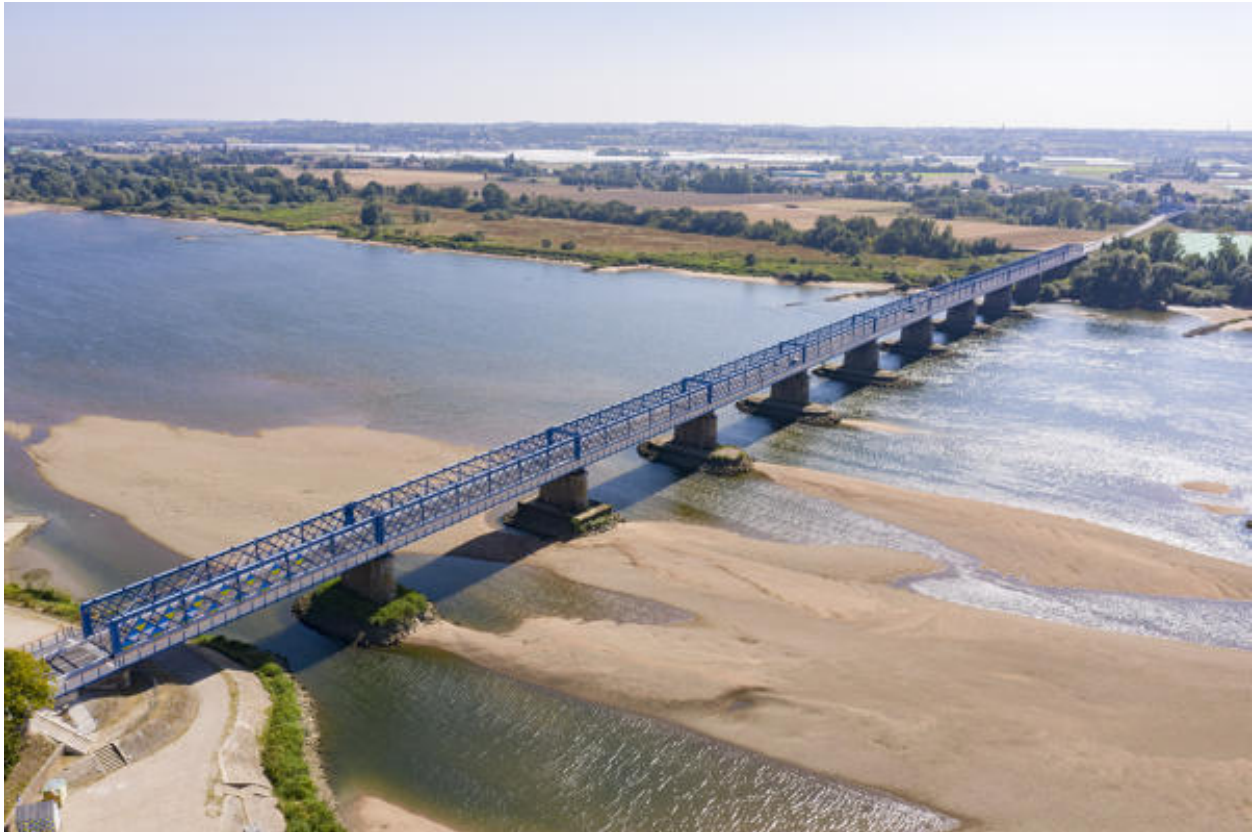
Vue aérienne des ponts de Mauves.
