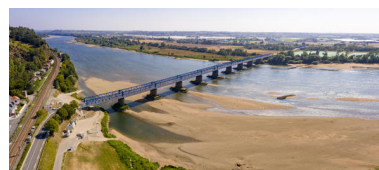
Vue aérienne des ponts de Mauves. Phot. Pierre-Bernard Fourny IVR52_20214400934NUCA
