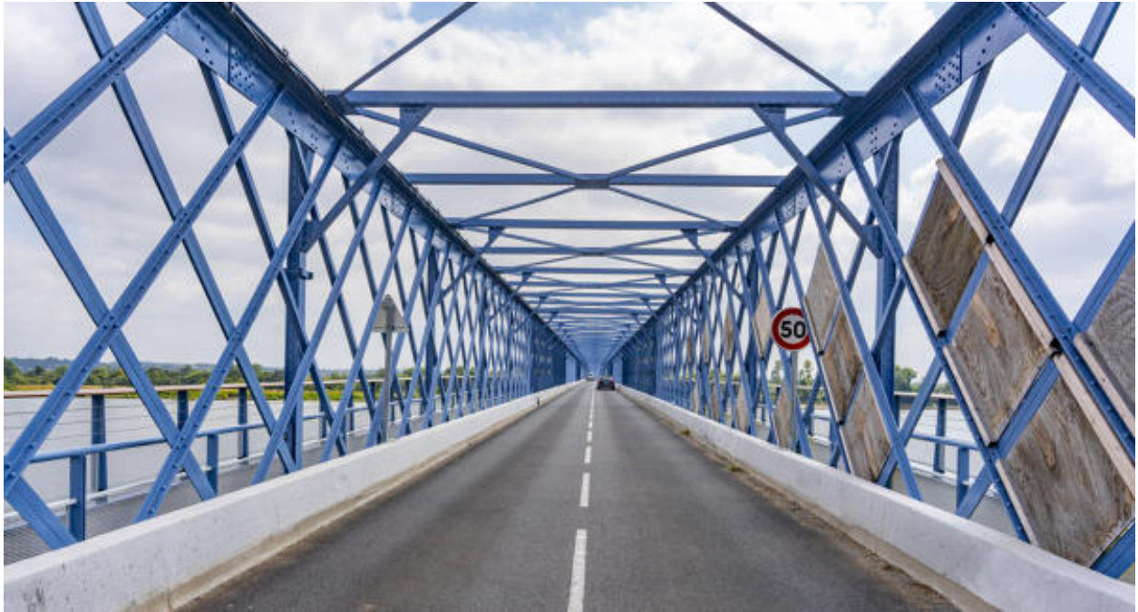
Vue du tablier et de la cage après les travaux de restauration.
