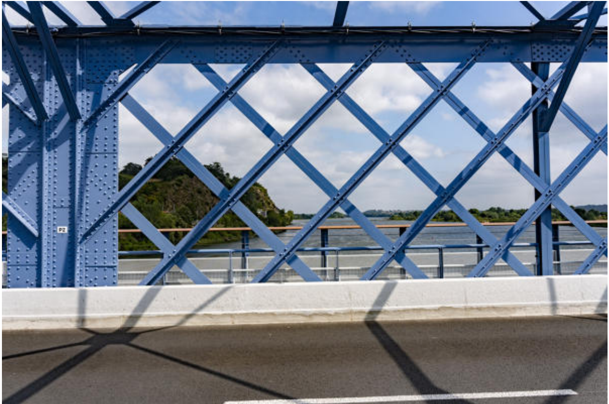
Vue de détail du treillis de la charpente métallique.
