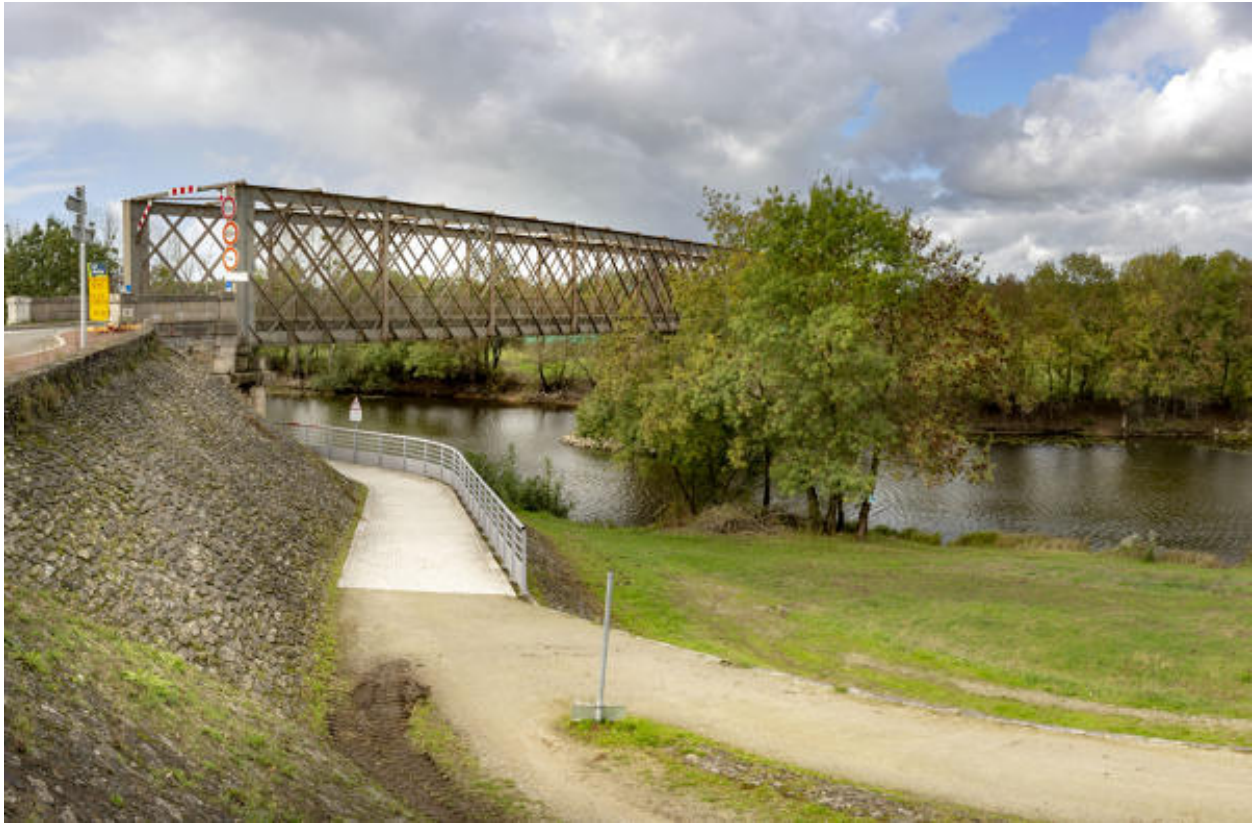
Vue du pont de la Pinsonnière en rive sud.
