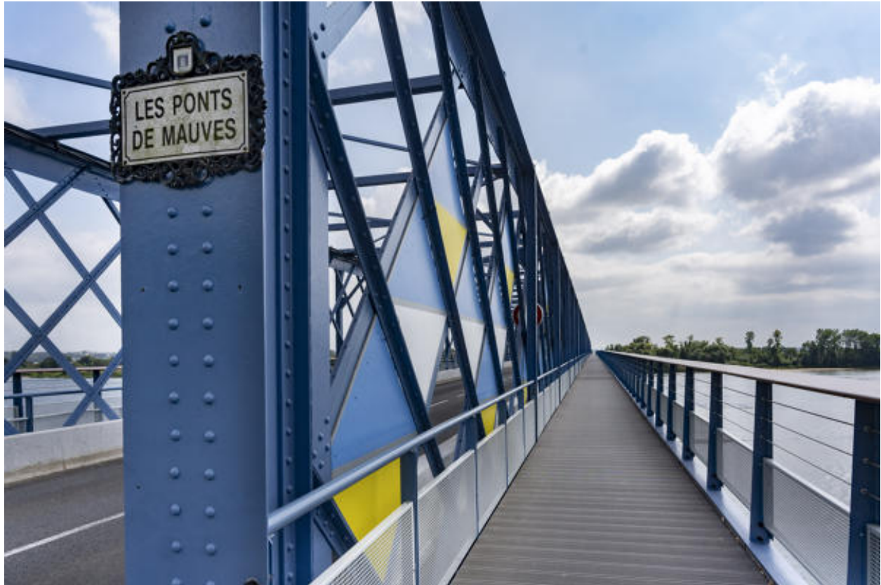
Vue de détail de la passerelle en encorbellement et de la plaque du pont.
