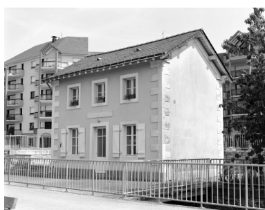
La maison éclusière. Au-devant le canal qui permettait le fonctionnement de la roue de la filature.
