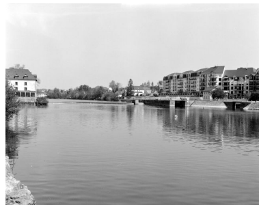
Vue d'ensemble du site depuis la rive droite en aval : moulin, barrage, pertuis, écluse, canal de dérivation de l'ancienne filature, maison éclusière.
