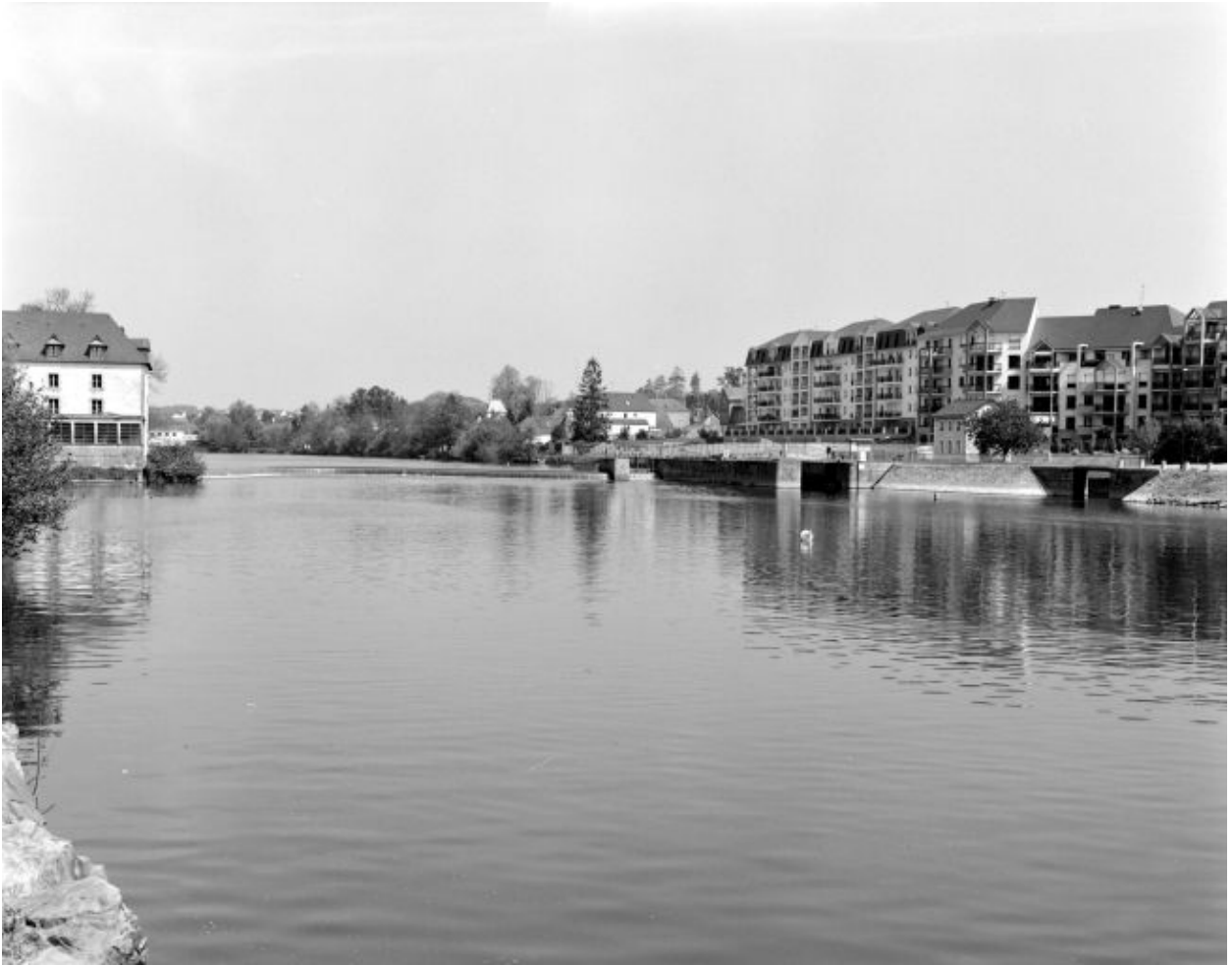
Vue d'ensemble du site depuis la rive droite en aval : moulin, barrage, pertuis, écluse, canal de dérivation de l'ancienne filature, maison éclésièrè.
