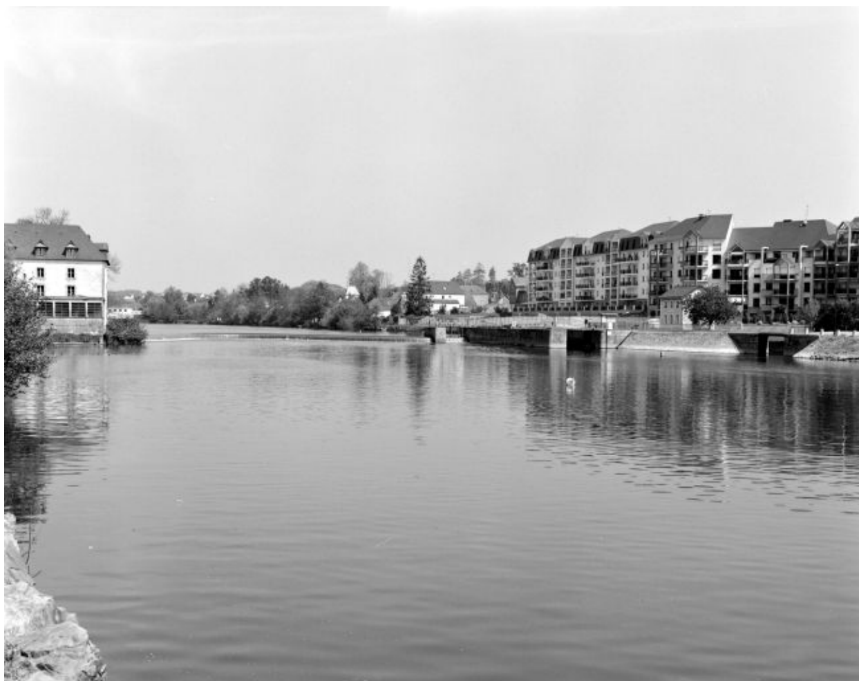
Vue d'ensemble du site depuis la rive droite en aval : moulin, barrage, pertuis, écluse, canal de dérivation de l'ancienne filature, maison éclusière.
