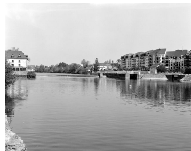
Vue d'ensemble du site depuis la rive droite en aval : moulin, barrage, pertuis, écluse, canal de dérivation de l'ancienne filature, maison éclusière. Phot. François Lasa IVR52_20025300617X
