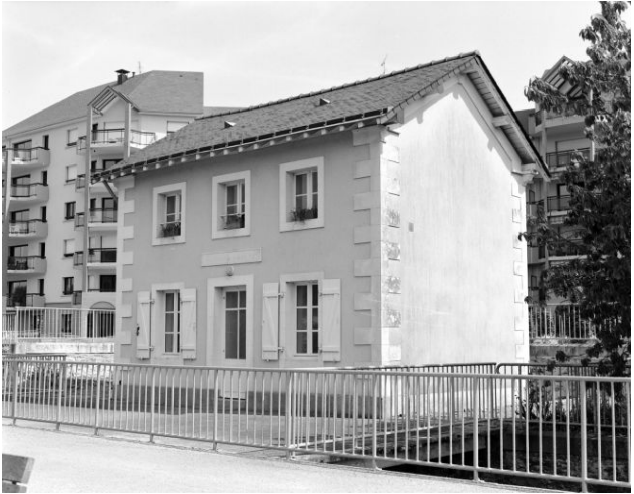
La maison éclusière. Au-devant le canal qui permettait le fonctionnement de la roue de la filature.
