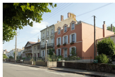
Vue d'ensemble depuis le quai. Phot. François Lasa IVR52_20054401440NUCA
