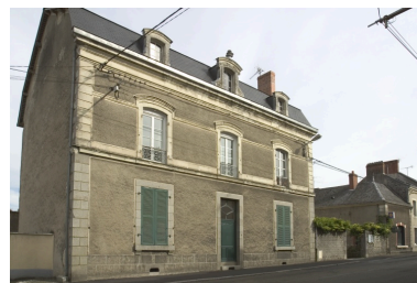
Vue d'ensemble depuis la rue au sud-ouest. Phot. François Lasa IVR52_20045303101NUCA
