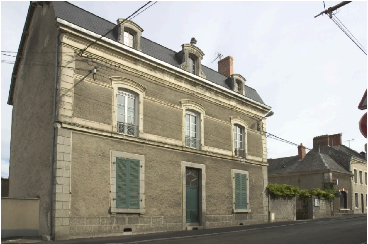
Vue d'ensemble depuis la rue au sud-ouest.
