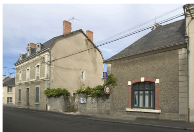
Vue d'ensemble depuis la rue au sud-est. Phot. François Lasa IVR52_20045303103NUCA
