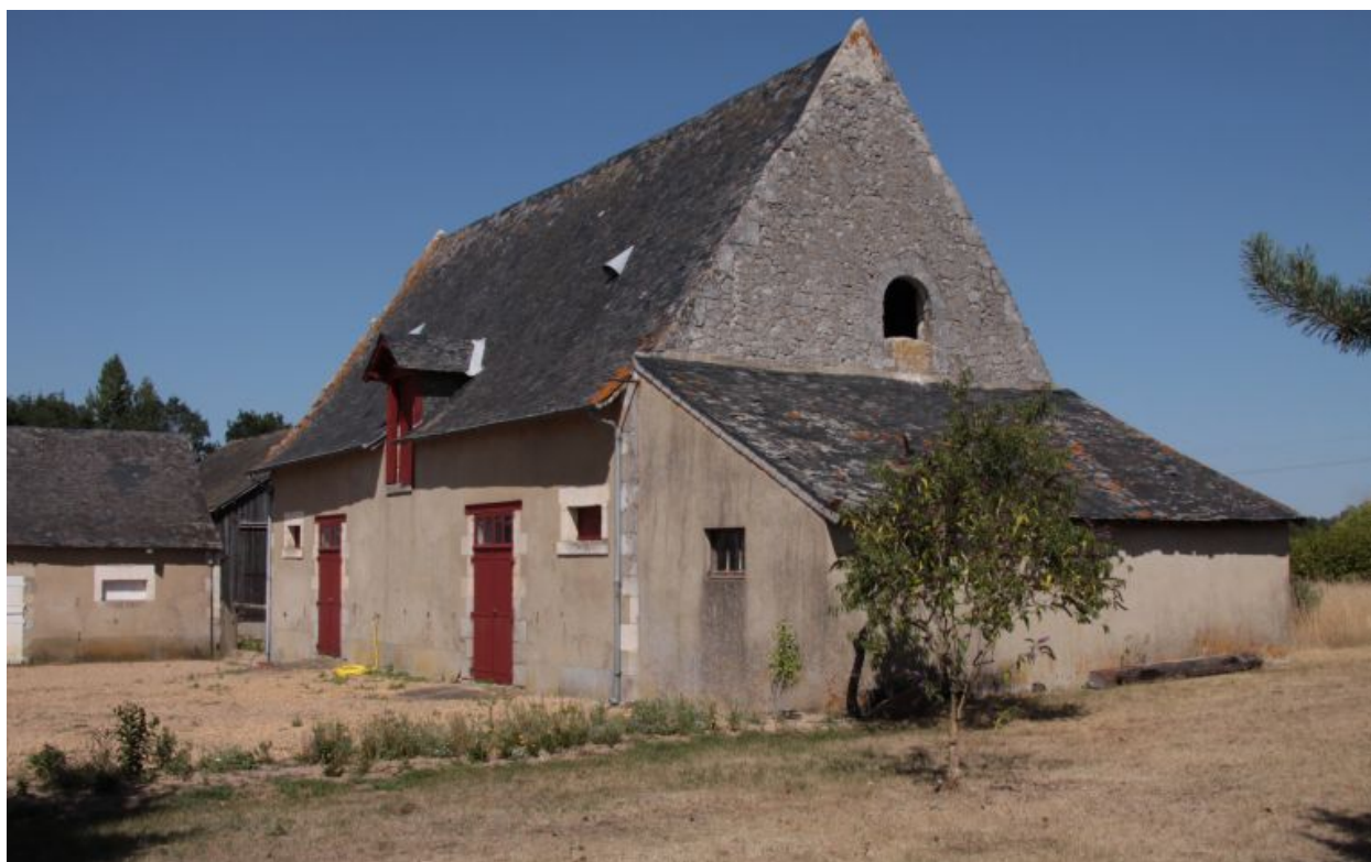
La grange, vue de volume.
