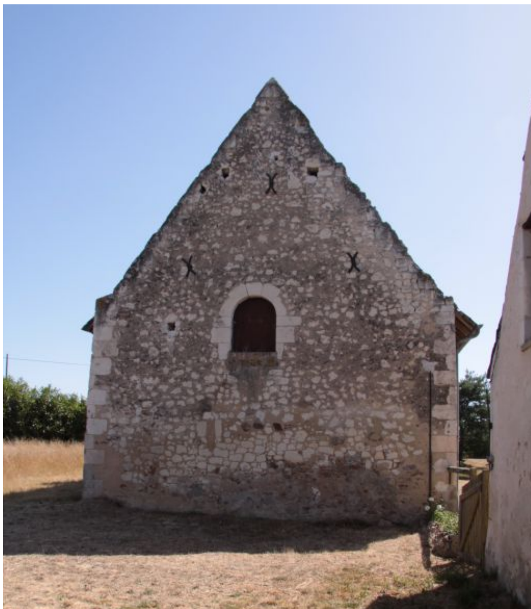
La grange, pignon nord.
