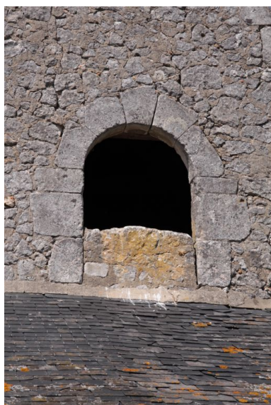
La grange, détail de la baie du pignon sud. Phot. Jean-Baptiste Darrasse IVR52_20097200460NUCA
