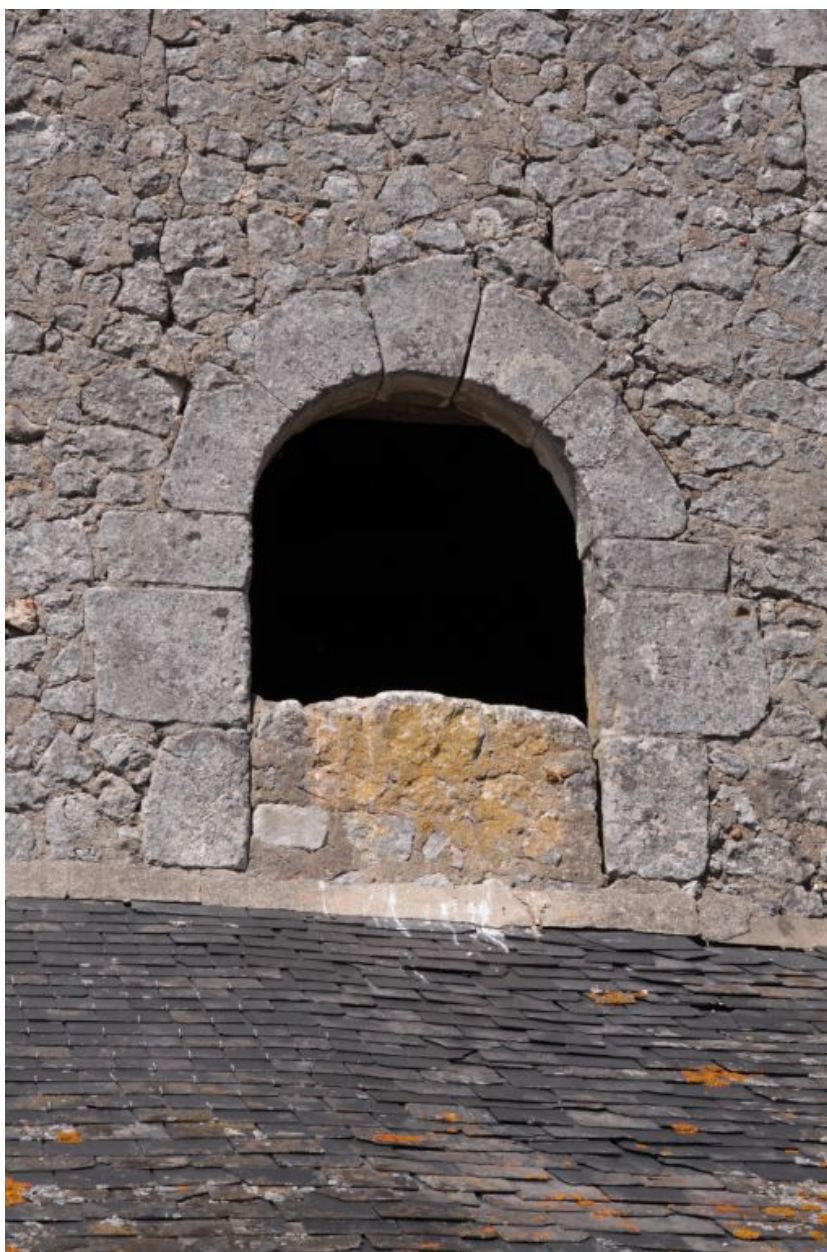
La grange, détail de la baie du pignon sud.
