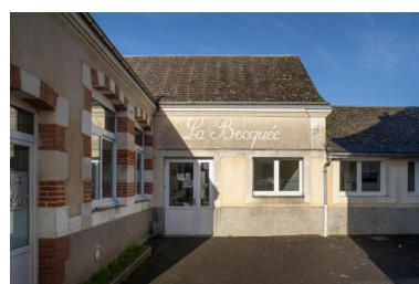
Aile gauche des classes, réaffectée en cantine scolaire. Phot. Thierry Seldubuisson IVR52_20247200011NUCA
