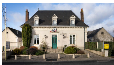
Élévation sur rue. Phot. Thierry Seldubuisson IVR52_20247200015NUCA
