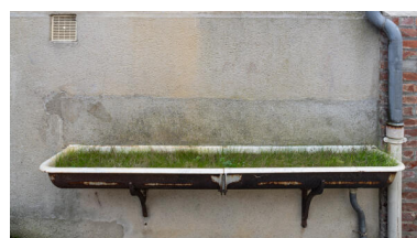
Lavabo extérieur placé contre la façade postérieure de la maison. Phot. Thierry Seldubuisson IVR52_20247200014NUCA
