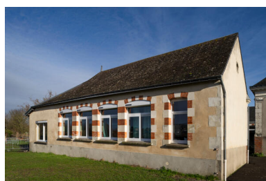
Élévation postérieure de l'aile gauche des classes. Phot. Thierry Seldubuisson IVR52_20247200013NUCA
