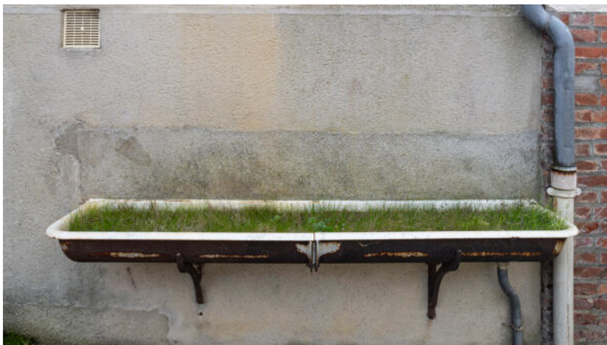
Lavabo extérieur placé contre la façade postérieure de la maison.
