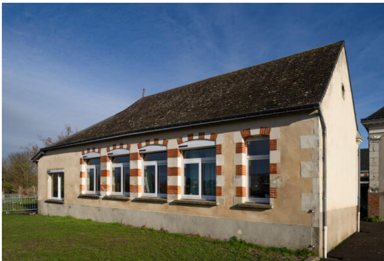
Élévation postérieure de l'aile gauche des classes.
