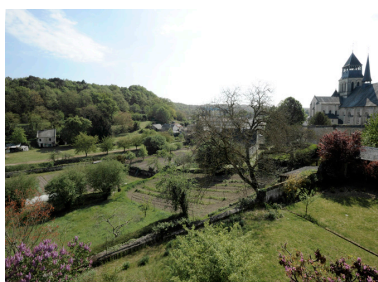
Vue depuis l'étage, sur les anciens jardins de la Secrétainerie et de l'Abbesse. Phot. Bruno Rousseau, Phot. Youenn Communeau IVR52_20114901679NUCA
