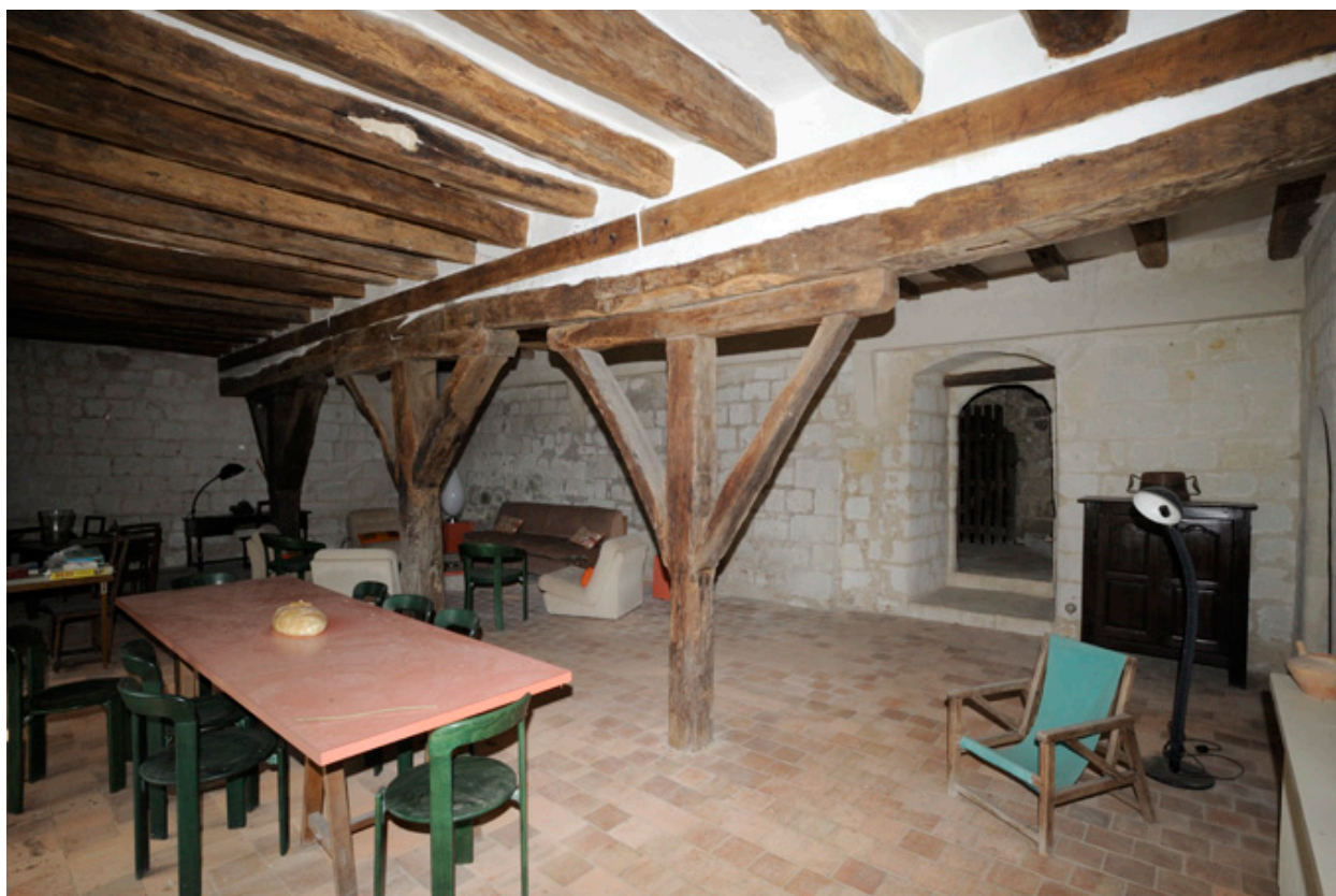
Salle basse : murs sud (au fond) et ouest (à droite).
