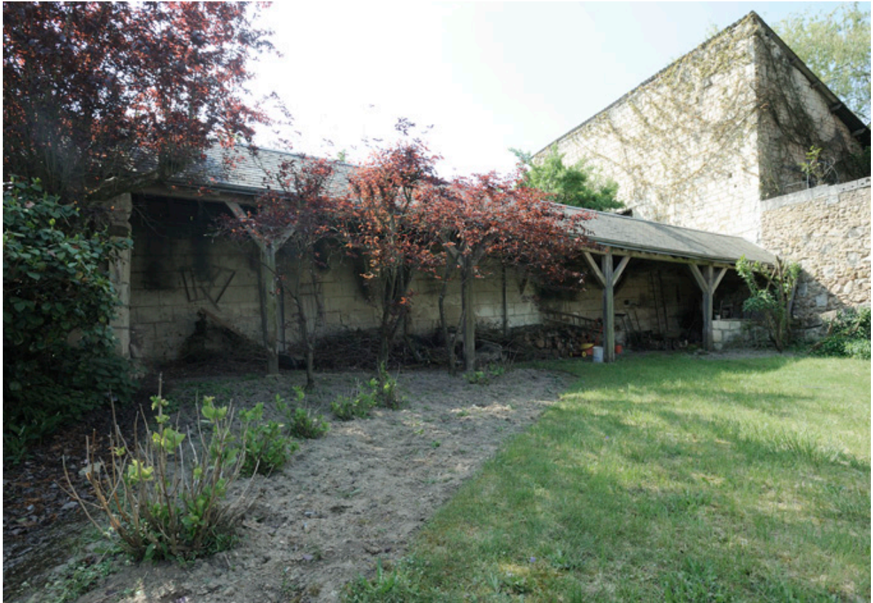
Jardin : apprentis, ancien préau de l'école.
