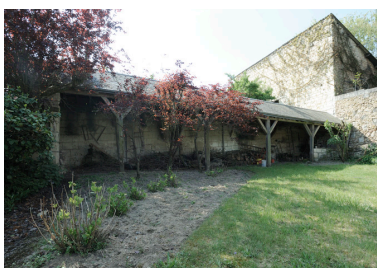
Jardin : appentis, ancien préau de l'école. Phot. Bruno Rousseau, Phot. Youenn Communeau IVR52_20114901672NUCA
