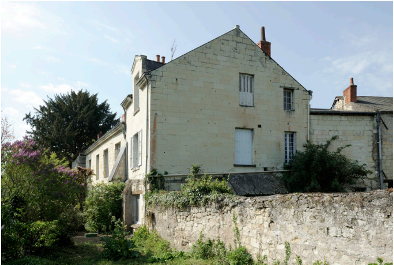
Façade nord, depuis le jardin.
