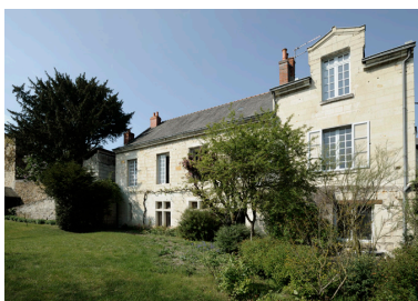
Vue d'ensemble depuis le jardin. Phot. Bruno Rousseau, Phot. Youenn Communeau IVR52_20114901674NUCA
