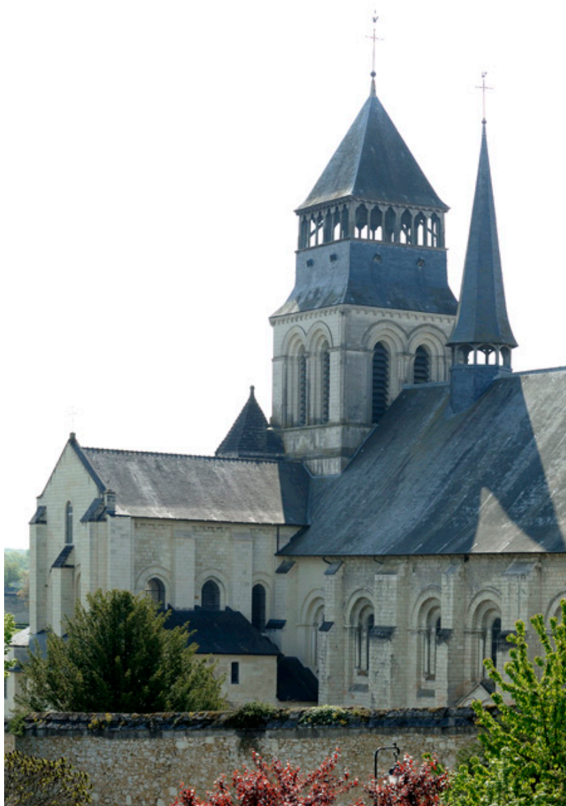
Vue depuis l'étage, sur l'église abbatiale.
