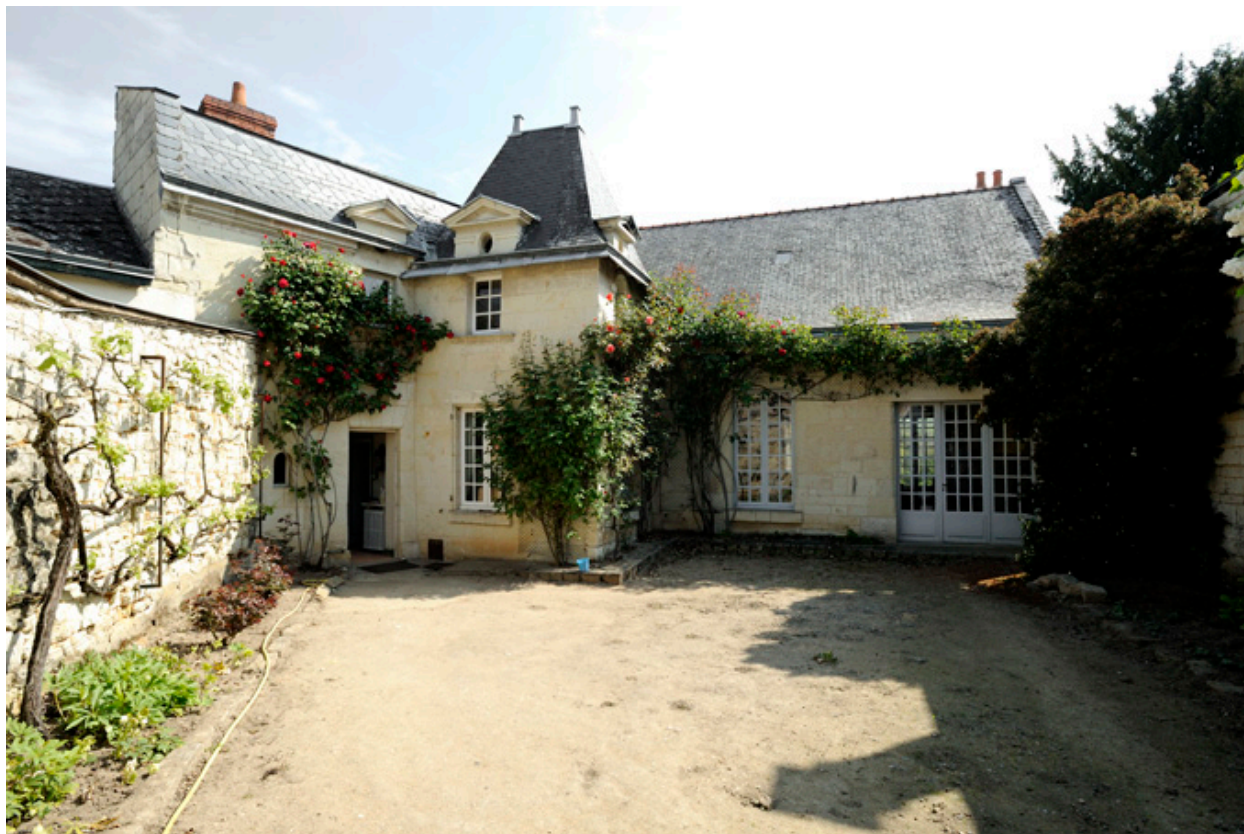
Vue générale sur la façade principale.
