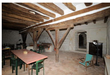
Salle basse : murs sud (au fond) et ouest (à droite). Phot. Bruno Rousseau, Phot. Youenn Communeau IVR52_20114901678NUCA
