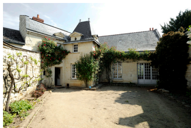
Vue générale sur la façade principale. Phot. Bruno Rousseau, Phot. Youenn Communeau IVR52_20114901682NUCA
