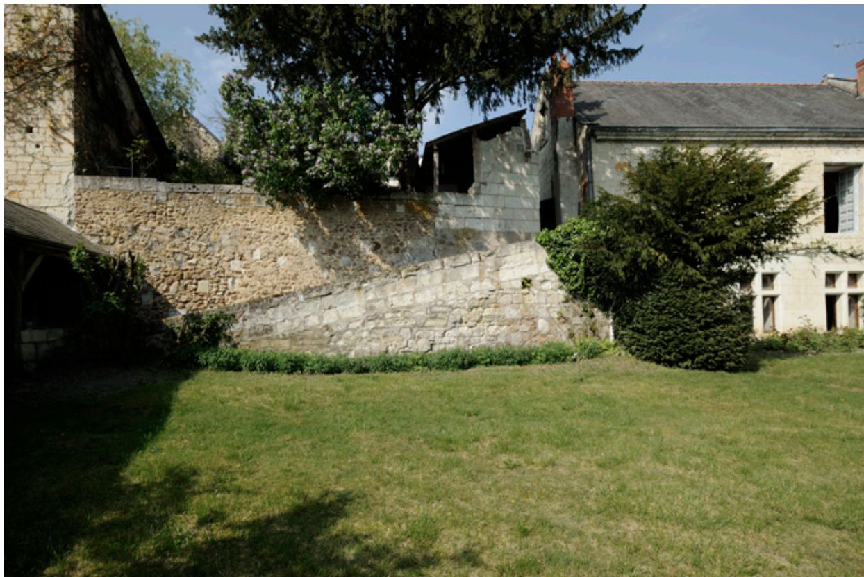
Jardin et rampe d'accès à la cour.
