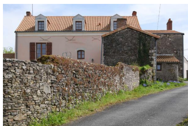
La Peltrie. Vue d'ensemble depuis le nord. Phot. Armelle Maugin IVR52_20254900538NUCA
