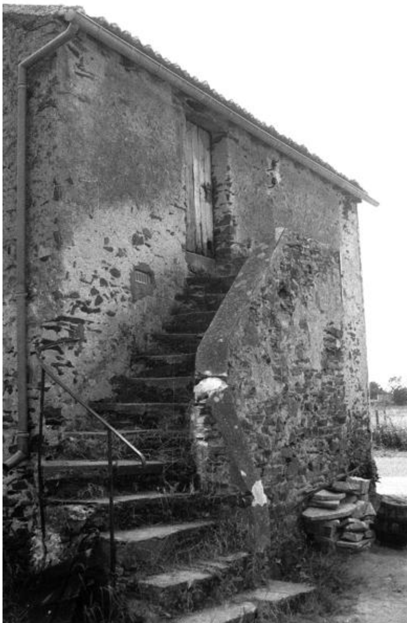
La Barbonnière. Détail de l'escalier permettant l'accès au grenier.
