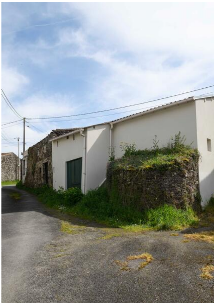
Haut-Cimetière (le) ; Chapelle (rue de la) 9, 11. Détail du four à pain.
