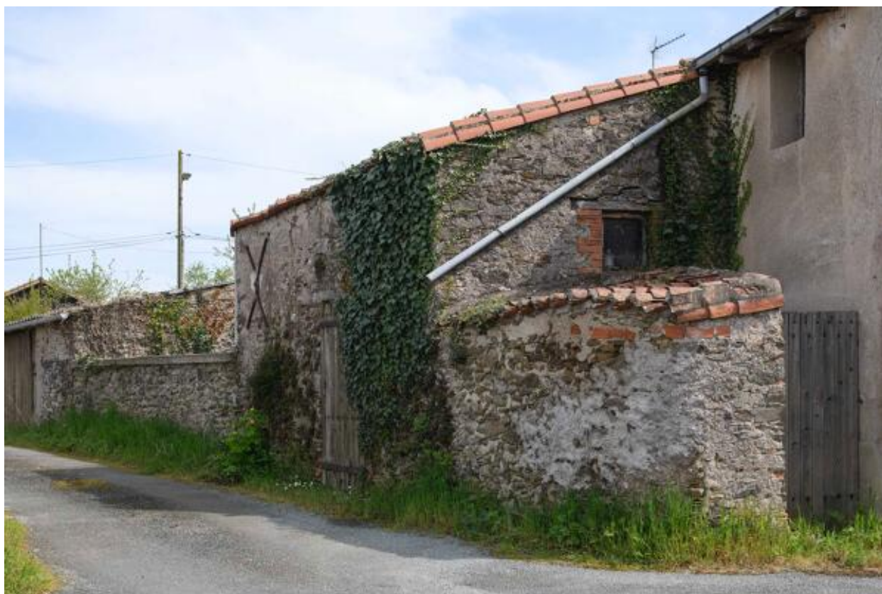
Haut-Cimetière (le) ; Peltrie (rue de la) 1 , 3, 5. Détail du four à pain.
