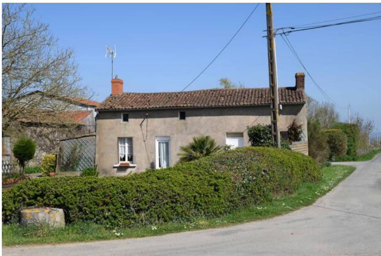
Les Moulins-Pinot (18e siècle). Vue du logis.
