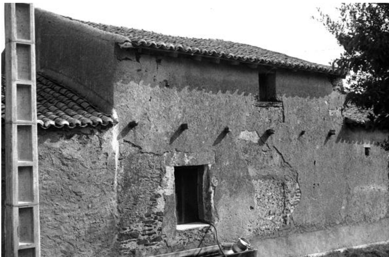
La Commazière. Vue de la façade sur rue prise lors du pré-inventaire en 1972.
