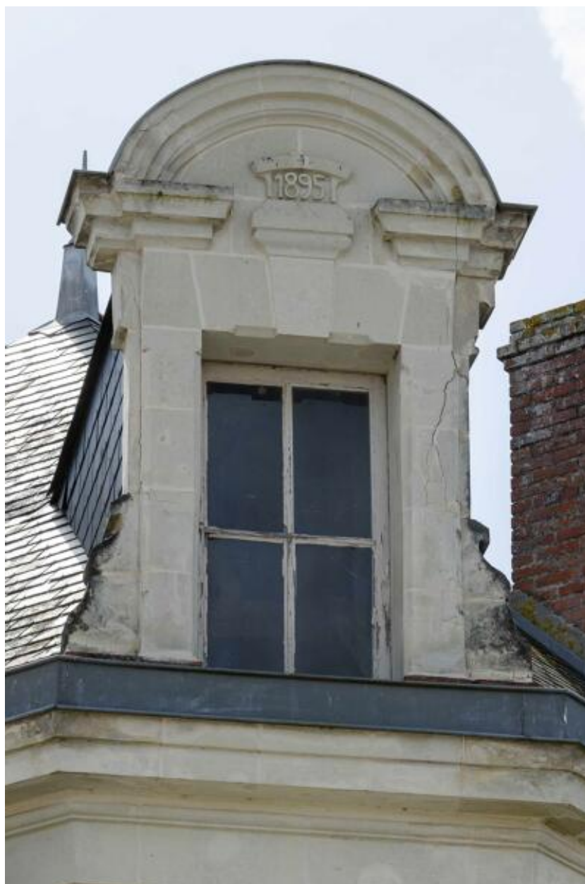
Bourg. Maison, 1 place de la Mairie. Détail de la lucarne datée 1895.
