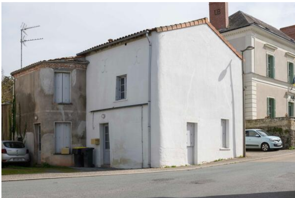
Bourg. Maison, 50 rue des Mauges.
