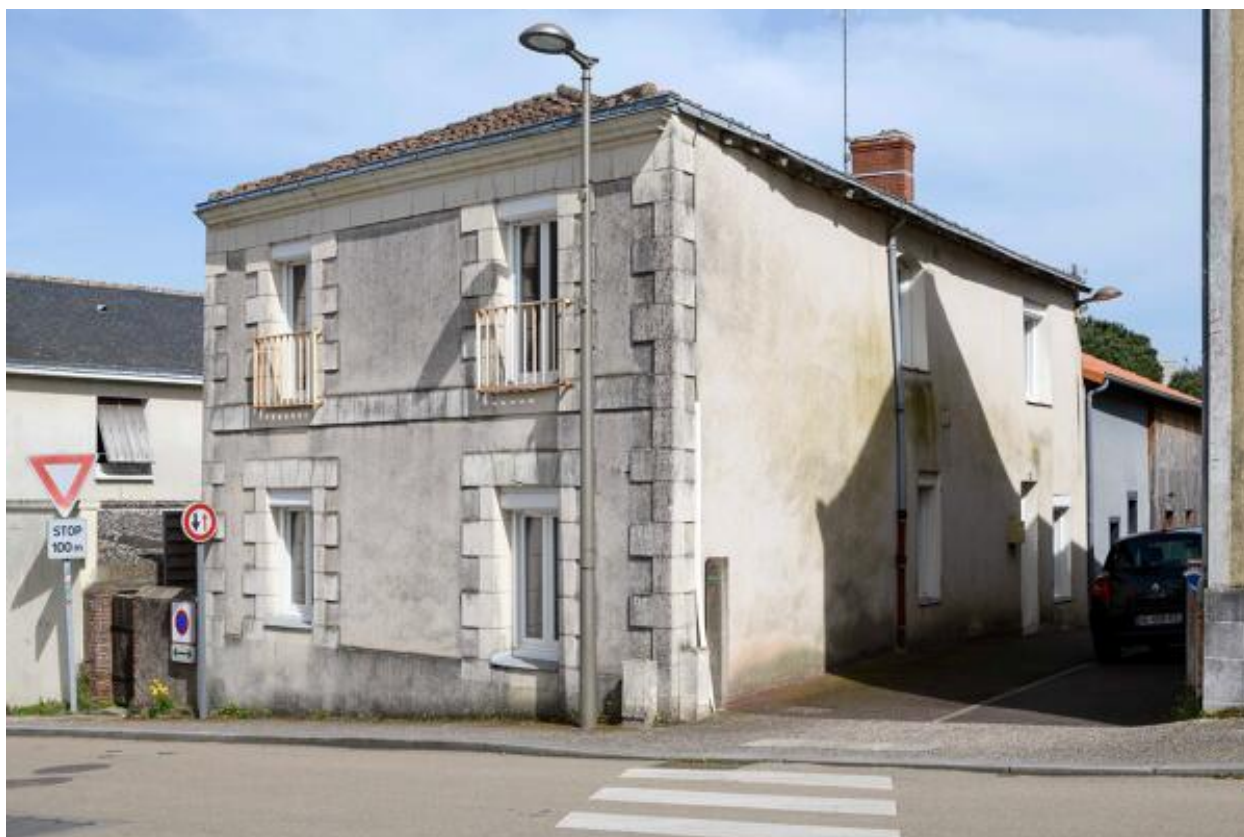
Bourg ; Mauges (rue des) 40. Maison datée 1732 (linteau de la fenêtre du mur gouttereau sud), remaniée dans le 1er quart du 20e siècle.
