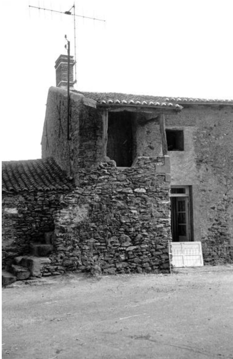
Le Clairay. Vue du logis et de l'escalier d'accès au grenier.
