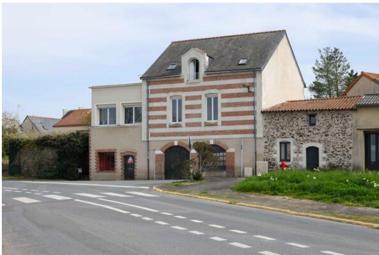
Bourg. Maison, 54 rue des Mauges.
