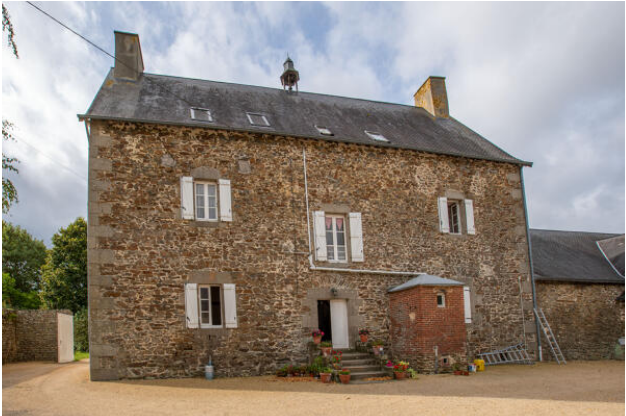
La façade postérieure de la maison.
