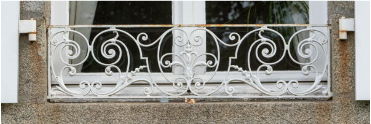
Un garde-corps de fenêtre.
