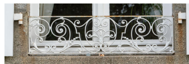
Un garde-corps de fenêtre. Phot. Pierre-Bernard Fourny IVR52_20235301550NUCA
