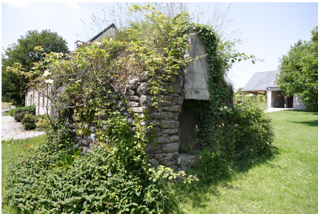
Vue du four à pain.
