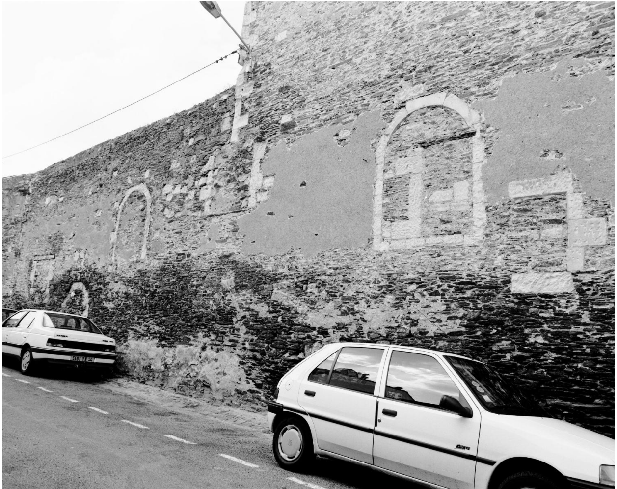
Bâtiment du chapitre/grande sacristie et mur d'enclos de la cour de service : baies murées de bâtiments disparus. Les deux grandes baies en plein cintre, alignées, appartenant peut-être à la première église.
