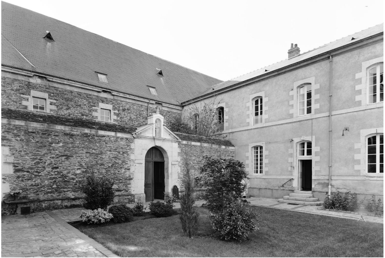
Cour d'entrée dite cour des Tourières : angle nord-ouest. A gauche, portail de la clôture et bâtiment oriental du cloître ; à droite, aile nord des parloirs.
