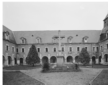
Cour du cloître : aile est. Phot. François Lasa IVR52_19814900298V
