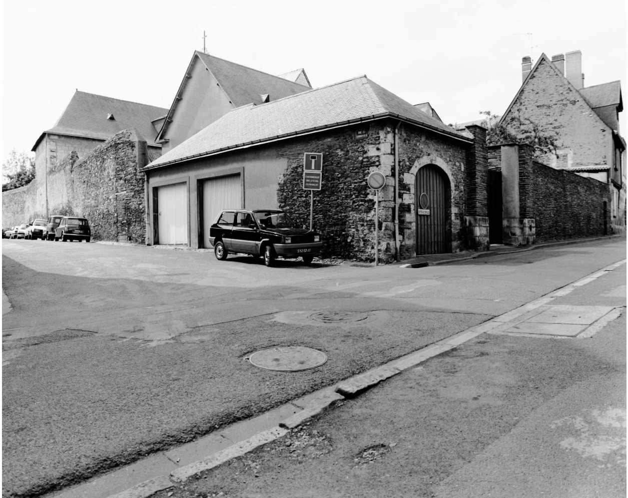
Vue de situation sur la rue du Tambourin (à gauche) et la rue Lionnaise (à droite). de gauche à droite : bâtiment du chapitre/grande sacristie, pignon de l'église, portail d'accès à la cour de l'église (n°37), petit logis dénaturé, logis de Puygaillard.
