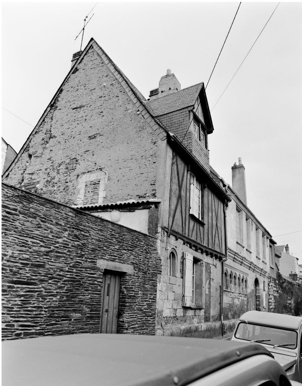
Logis de Puygaillard formant l'entrée du couvent, au n° 39 : façade sur rue, trois-quarts gauche.
