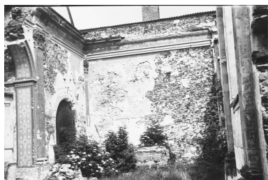
Eglise, chœur, élévation intérieure vers nord-ouest, état après les bombardements de 1944, fotogr., de H. Enguehard, [v. 1950]. Autr. Henri Enguehard, Repro. Patrice Giraud IVR52_20044904234NUC
