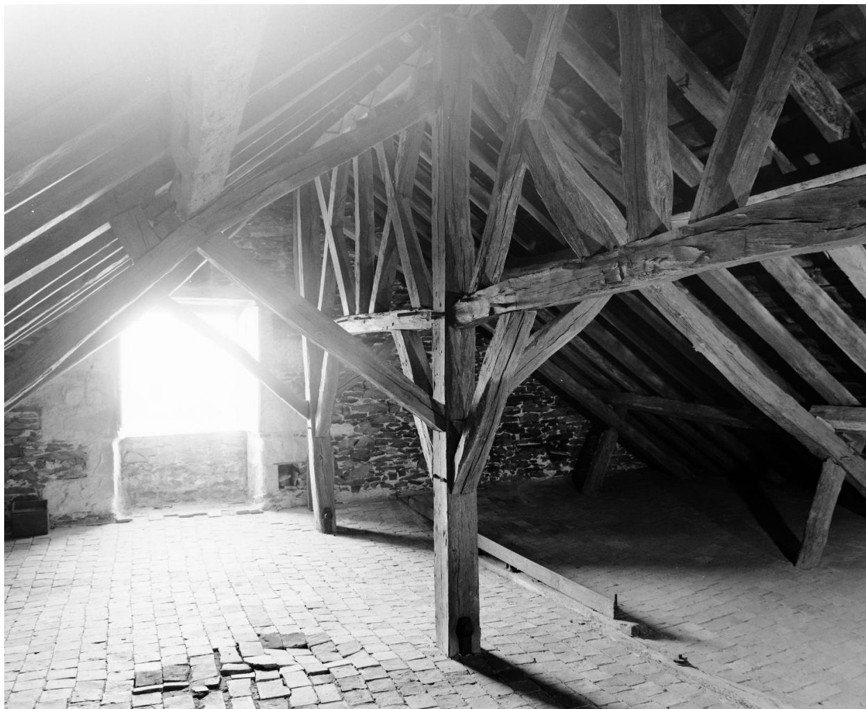
Bâtiment du noviciat, second étage de comble : vue d'ensemble de la charpente d'est en ouest.
