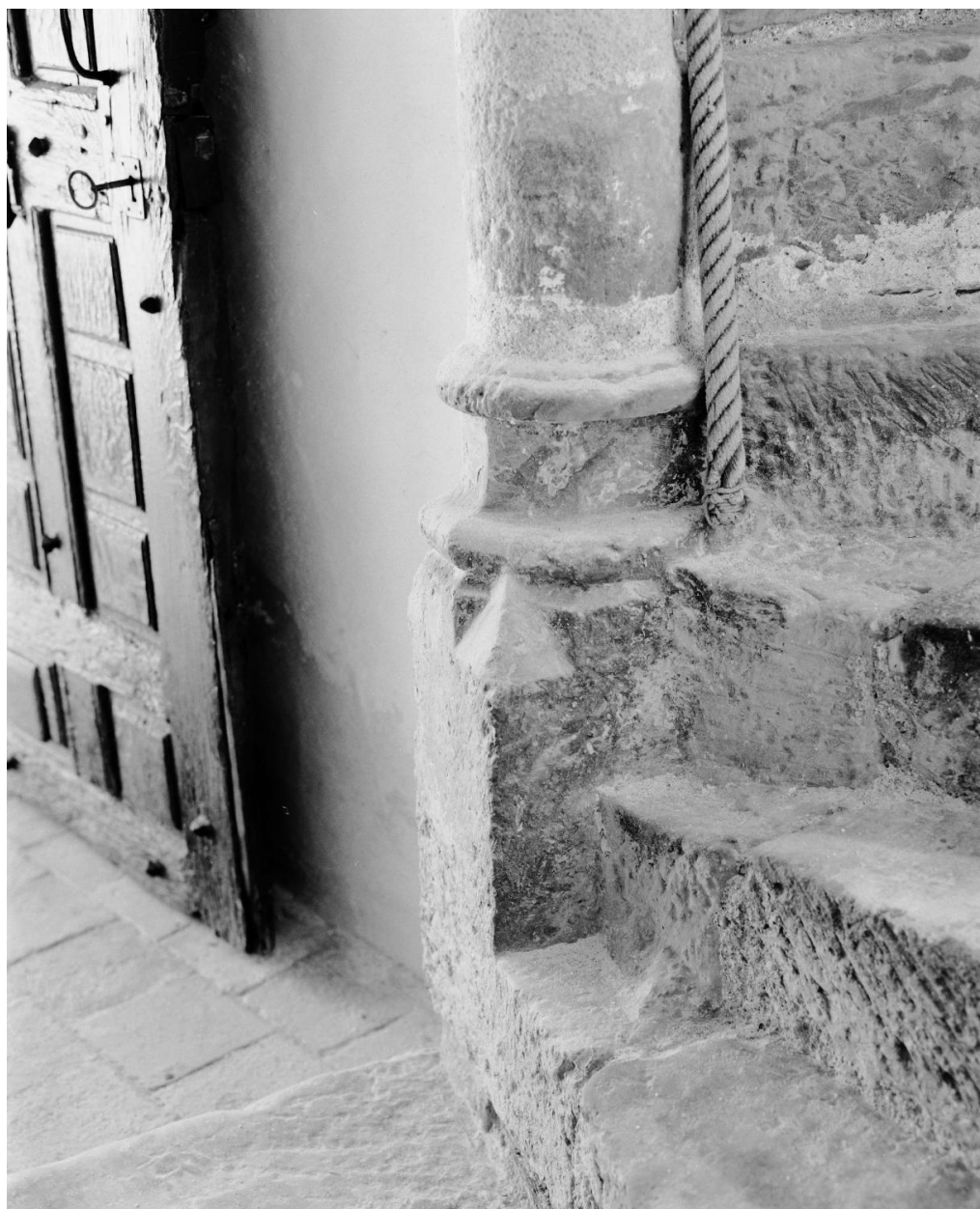
Logis de Puygaillard, escalier : base du noyau.
