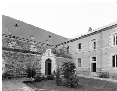
Cour d'entrée dite cour des Tourières : angle nord-ouest. A gauche, portail de la clôture et bâtiment oriental du cloître ; à droite, aile nord des parloirs. Phot. François Lasa IVR52_19974900838V
