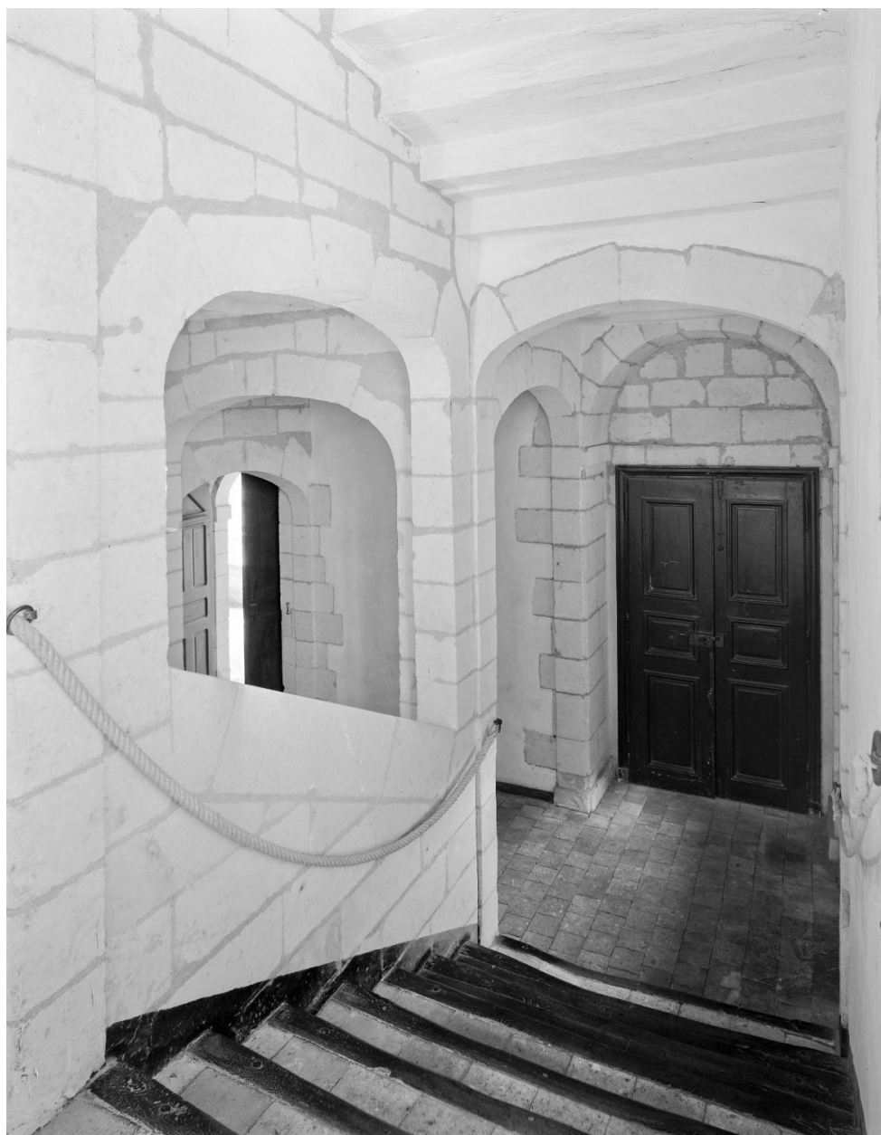
Cloître, aile sud, grand escalier : palier du premier étage.
