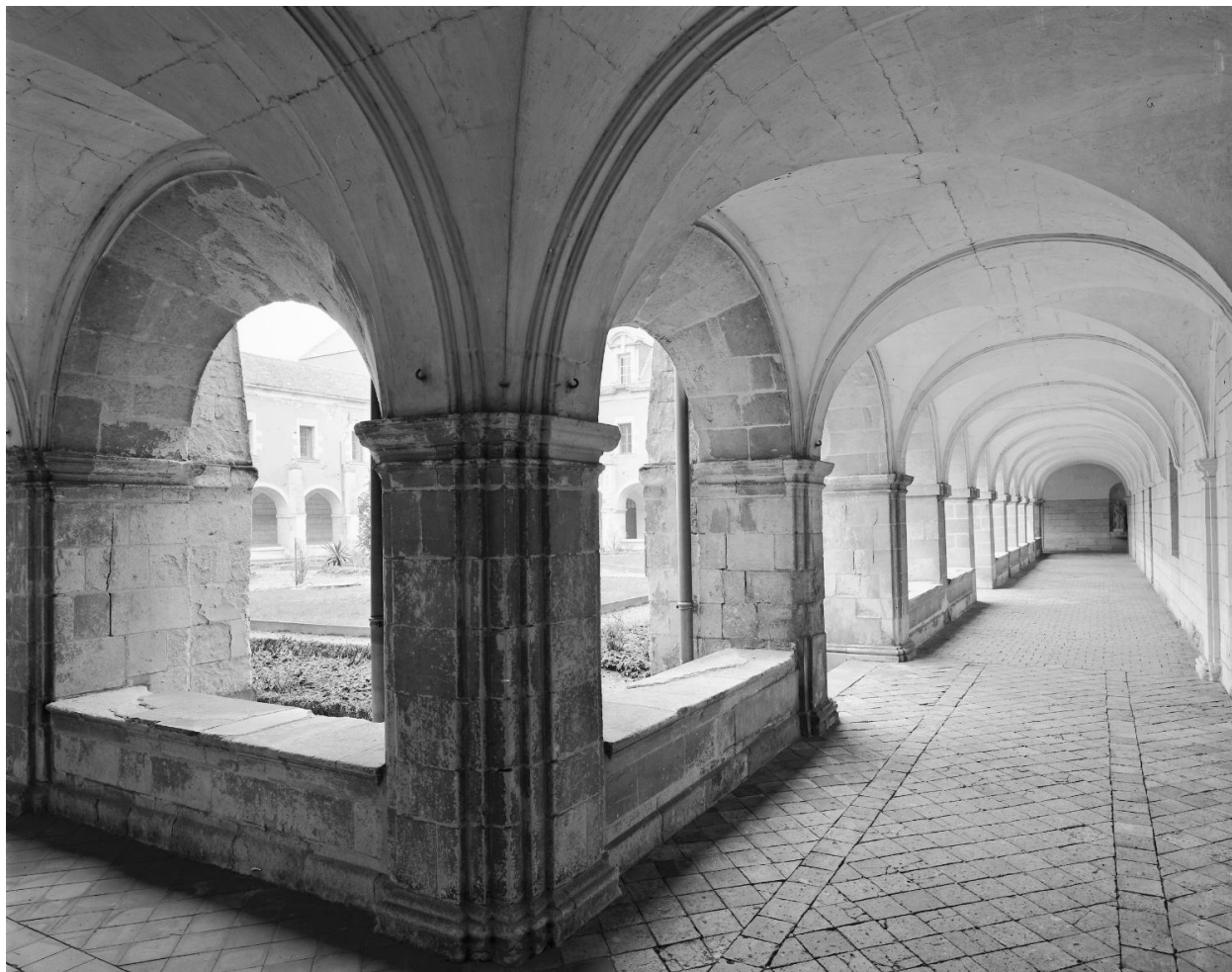
Galerie est du cloître, vue en axe sud-nord.
