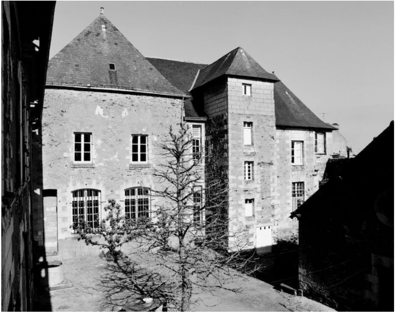
Bâtiments sur la cour de service : façades ouest de l'avant-choeur ou vestibule des religieuses (à gauche) et de la grande sacristie/salle du chapitre (à droite).
