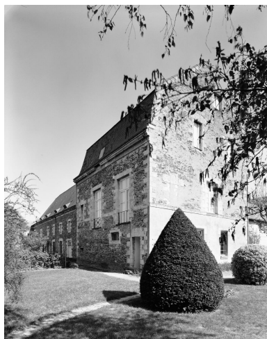
Bâtiment du noviciat (au premier plan) et aile nord du cloître : façades nord et pignon ouest, sur les jardins.
