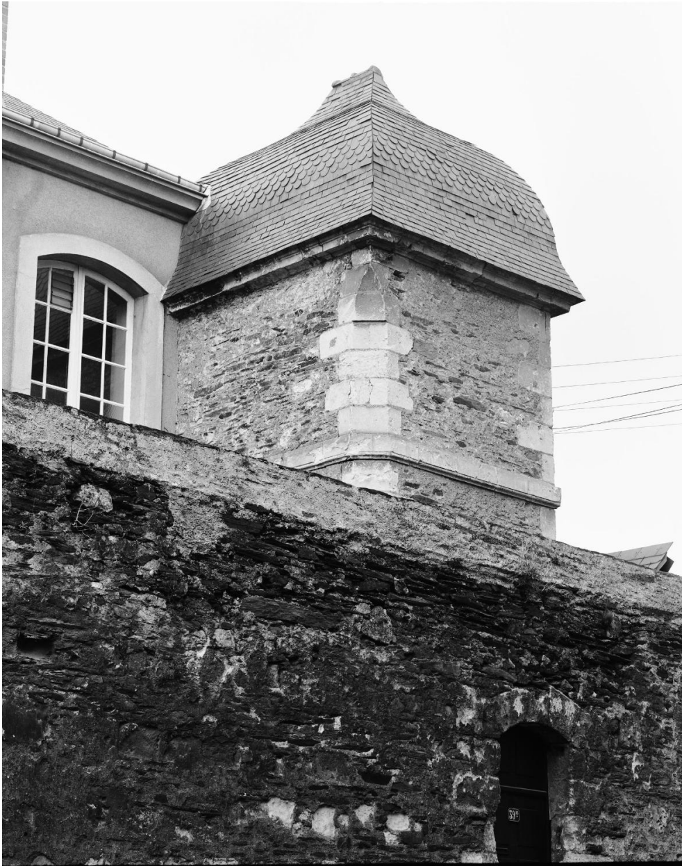
Pavillon jouxtant à l'est l'aile double des parloirs et logis de la marquise de Férolle : élévation sur rue, partie haute.
