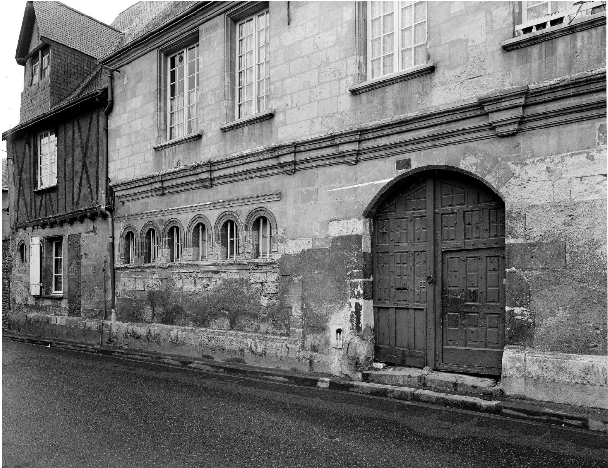
Logis de Puygaillard formant l'entrée du couvent, au n° 39 : façade sur rue, trois-quarts droit, vue rapprochée.
