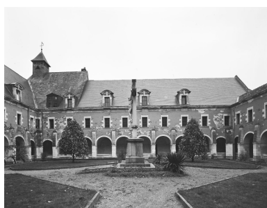
Cour du cloître : aile sud. Phot. François Lasa IVR52_19814900297V
