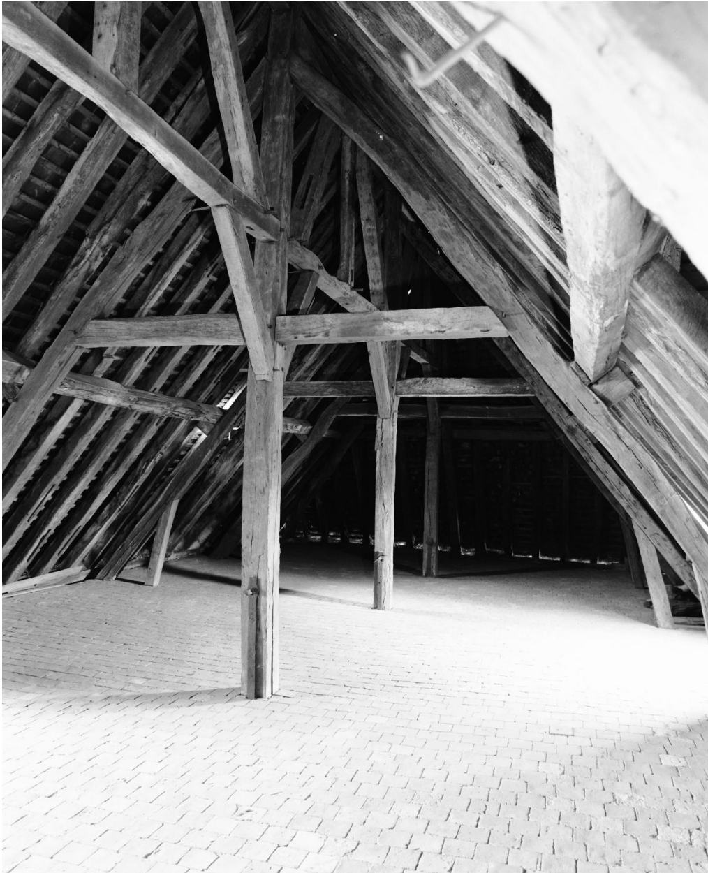
Corps de bâtiment de la grande sacristie et de la salle du chapitre, étage de comble : vue d'ensemble de la charpente en axe nord-sud.
