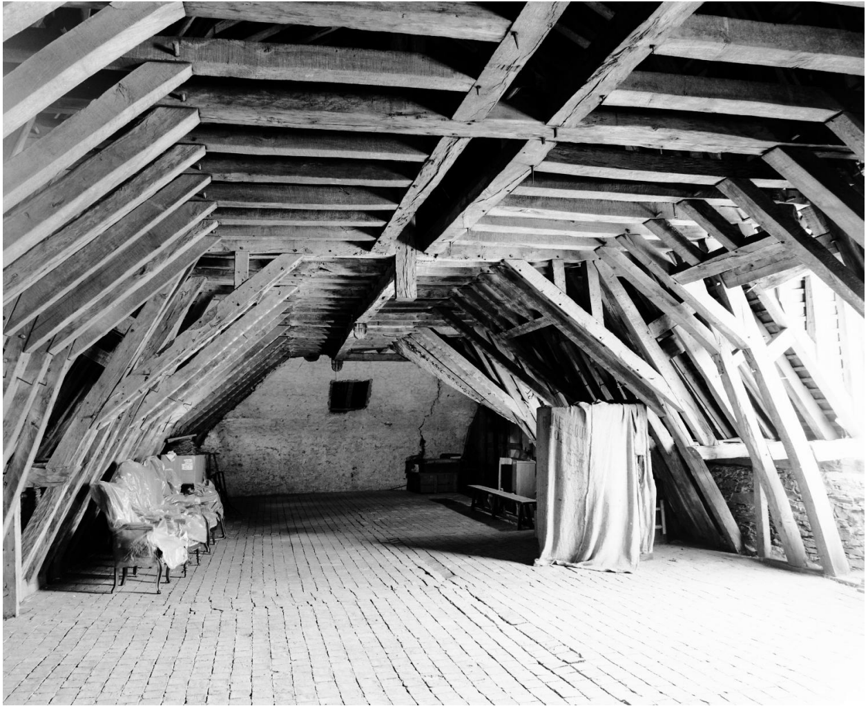
Aile nord du cloître, étage de comble, partie est de la charpente, vue depuis l'ouest. Au premier plan, partie avec premier sous-faîtage dédoublé marquant la seconde campagne de construction.
