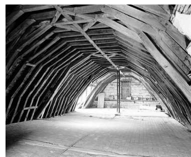
Corps de bâtiment de l'avant-choeur et du chœur des religieuses, étage de comble : vue d'ensemble de la charpente d'ouest en est. Sur le mur du fond, en partie basse, vestige de la corniche de l'église primitive. Phot. François Lasa IVR52_19974900934X
