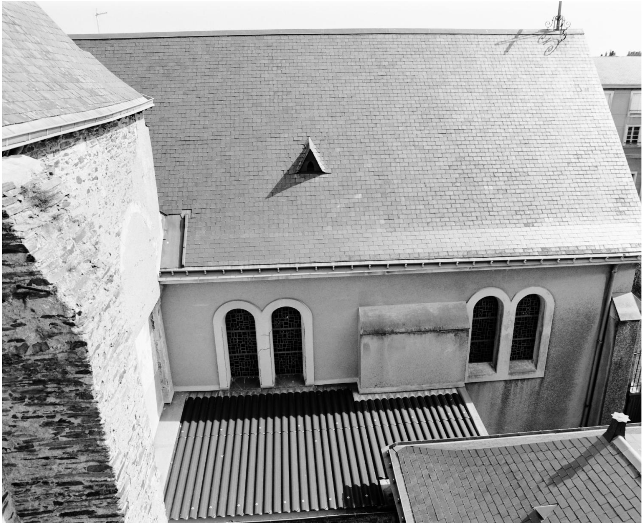
Eglise Sainte-Thérèse actuelle : façade latérale gauche (ouest).
