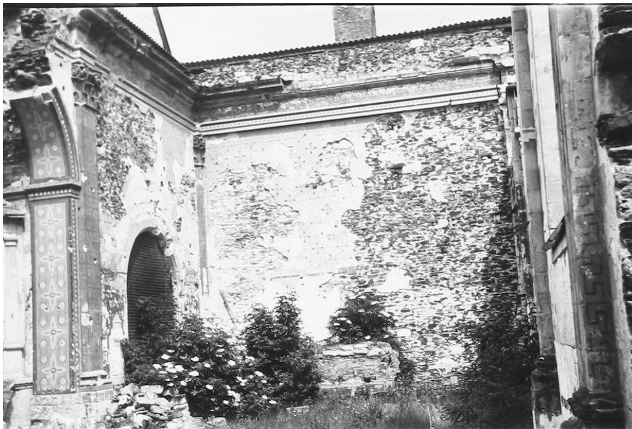
Eglise, choeur, élévation intérieure vers nord-ouest, état après les bombardements de 1944, fotogr., de H. Enguehard, [v. 1950].
