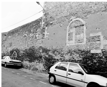
Bâtiment du chapitre/grande sacristie et mur d'enclos de la cour de service : baies murées de bâtiments disparus. Les deux grandes baies en plein cintre, alignées, appartenant peut-être à la première église.
