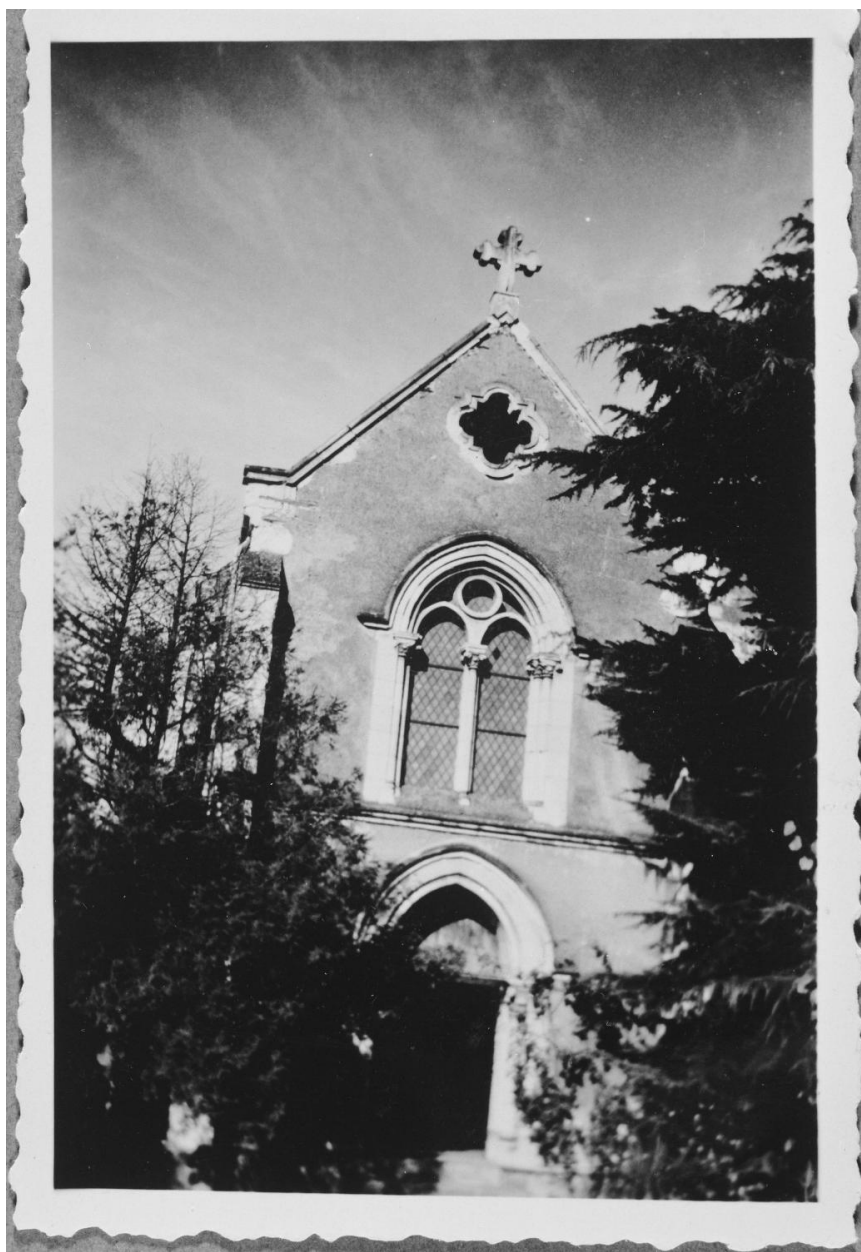
Jardin, chapelle de l'Ermitage : façade principale, fotogr., milieu 20e siècle.
