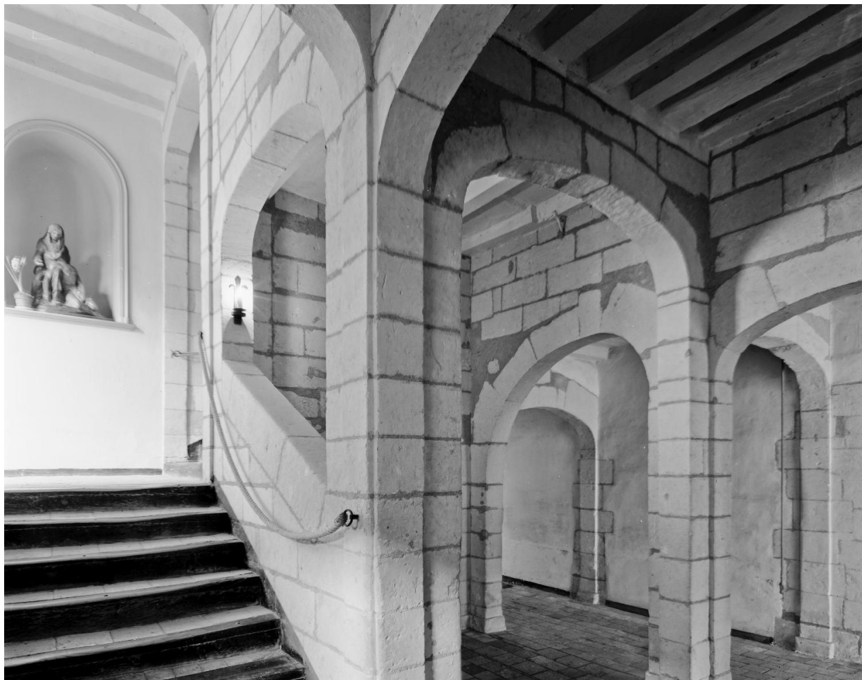
Aile sud du cloître, vestibule et départ du grands escalier, depuis le nord-est.
