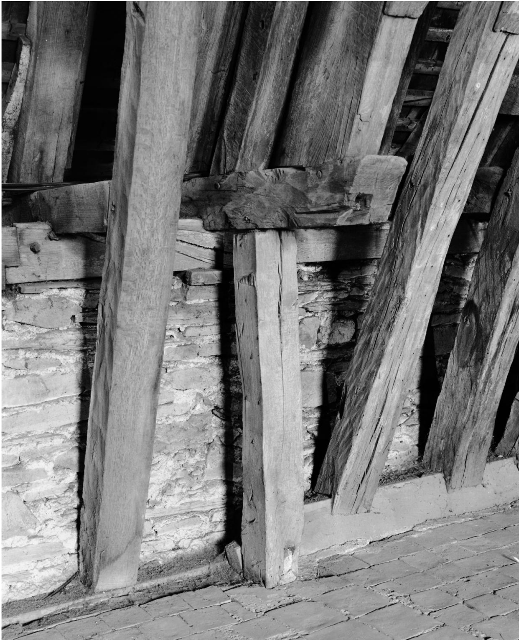
Aile nord du cloître, étage de comble, charpente : détail sur le surcroît à la jonction des deux campagnes de construction.
