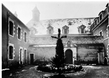
Cour d'entrée dite cour des Tourières : face ouest vers la clôture, fotogr., [av. 1944].
