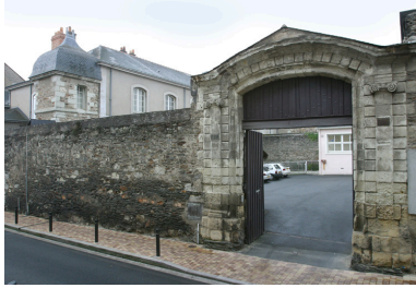
Portail de la cour d'entrée de la marquise de Férolle, 41 rue Lionnaise. Phot. Patrice Giraud IVR52_20024904401NUCA
