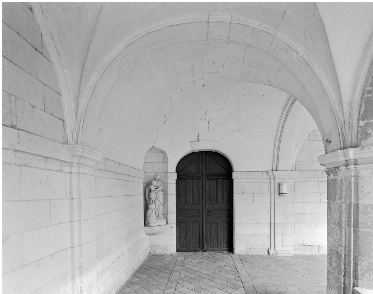
Galleries du cloître : travée d'angle sud-est. Au fond, porte du grand escalier.
