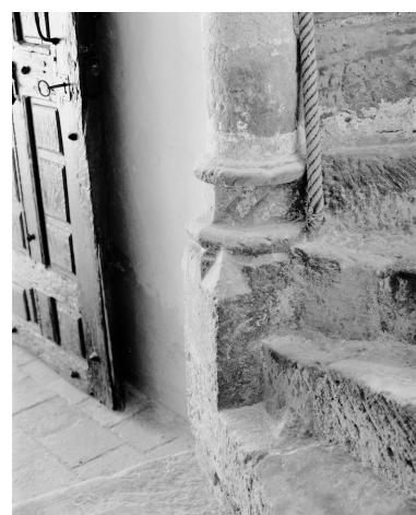
Logis de Puygaillard, escalier : base du noyau.
