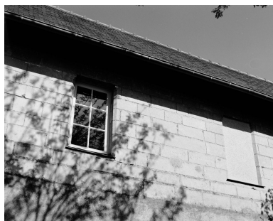
Aile ouest du cloître, façade sur jardin : détail sur les 2e et 3e baies du premier étage.
