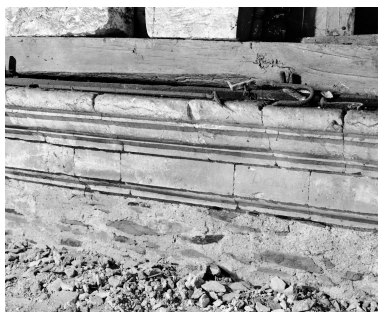
Corps de bâtiment de l'avant-choeur et du chœur des religieuses, étage de comble, mur est : détail sur la corniche fossile de l'église primitive. Phot. François Lasa IVR52_19974900935X
