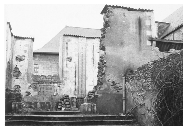
Eglise, mur est : degrés d'accès à la nef depuis la cour de l'église, état après les bombardements de 1944, photogr., de H. Enguehard, [v. 1950]. Autr. Henri Enguehard, Repro. François Lasa IVR52_20044904230NUC
