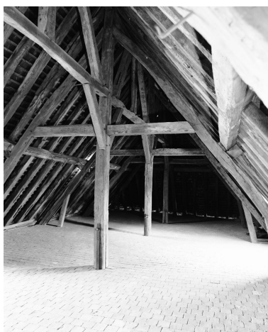
Corps de bâtiment de la grande sacristie et de la salle du chapitre,
