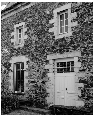
Aile nord du cloître, façade nord, sur jardin : détail sur la porte vers cloître et fenêtres voisines.
