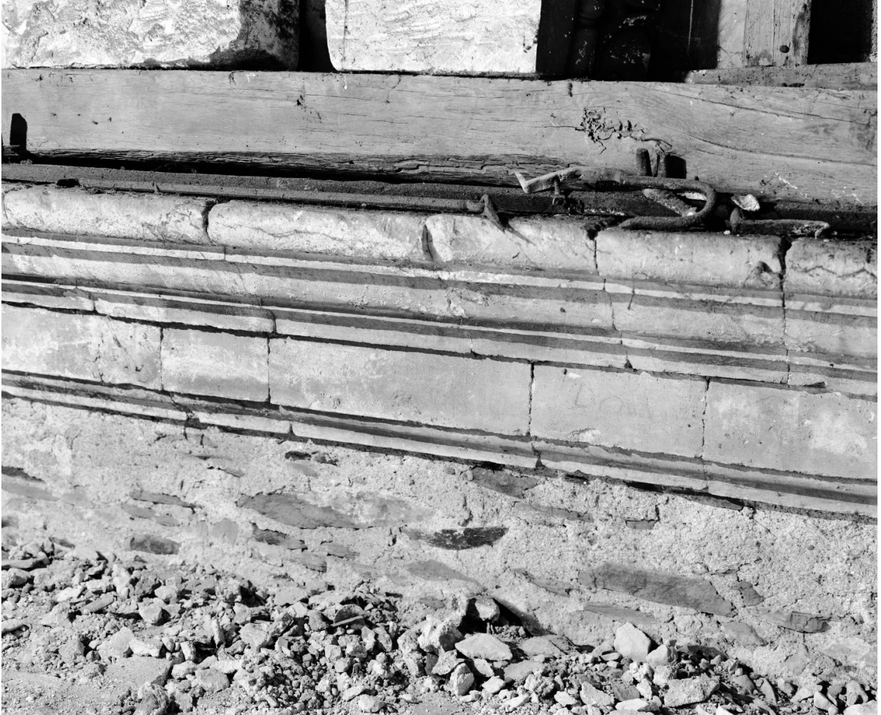
Corps de bâtiment de l'avant-choeur et du choeur des religieuses, étage de comble, mur est : détail sur la corniche fossile de l'église primitive.
