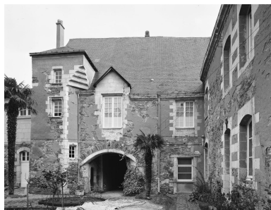
Logis de Puygaillard : façade cour. Phot. Patrice Giraud, Phot. François Lasa IVR52_19804902807V
