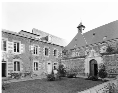
Cour d'entrée : angle sud-ouest. A gauche : aile de parloirs et toit du chœur des religieuses en arrière-plan. A droite, portail de la clôture et bâtiment orientale du cloître. Phot. François Lasa IVR52_19974900839V
