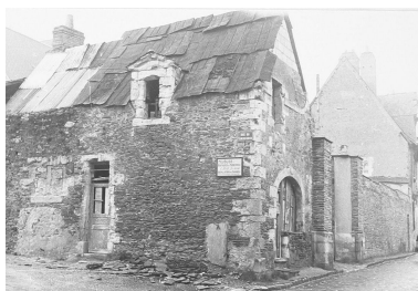
Logis annexe à l'angle des rues du Tambourin et Lionnaise, état après les bombardements de 1944, fotogr., de H. Enguehard, [v. 1950]. Phot. Patrice Giraud, Autr. Henri Enguehard IVR52_20044904238NUC
