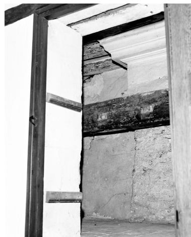
Bâtiment du noviciat, rez-de-chaussée (occupé par une boulangerie en 1808), mur est : vestiges d'une hotte de cheminée.
