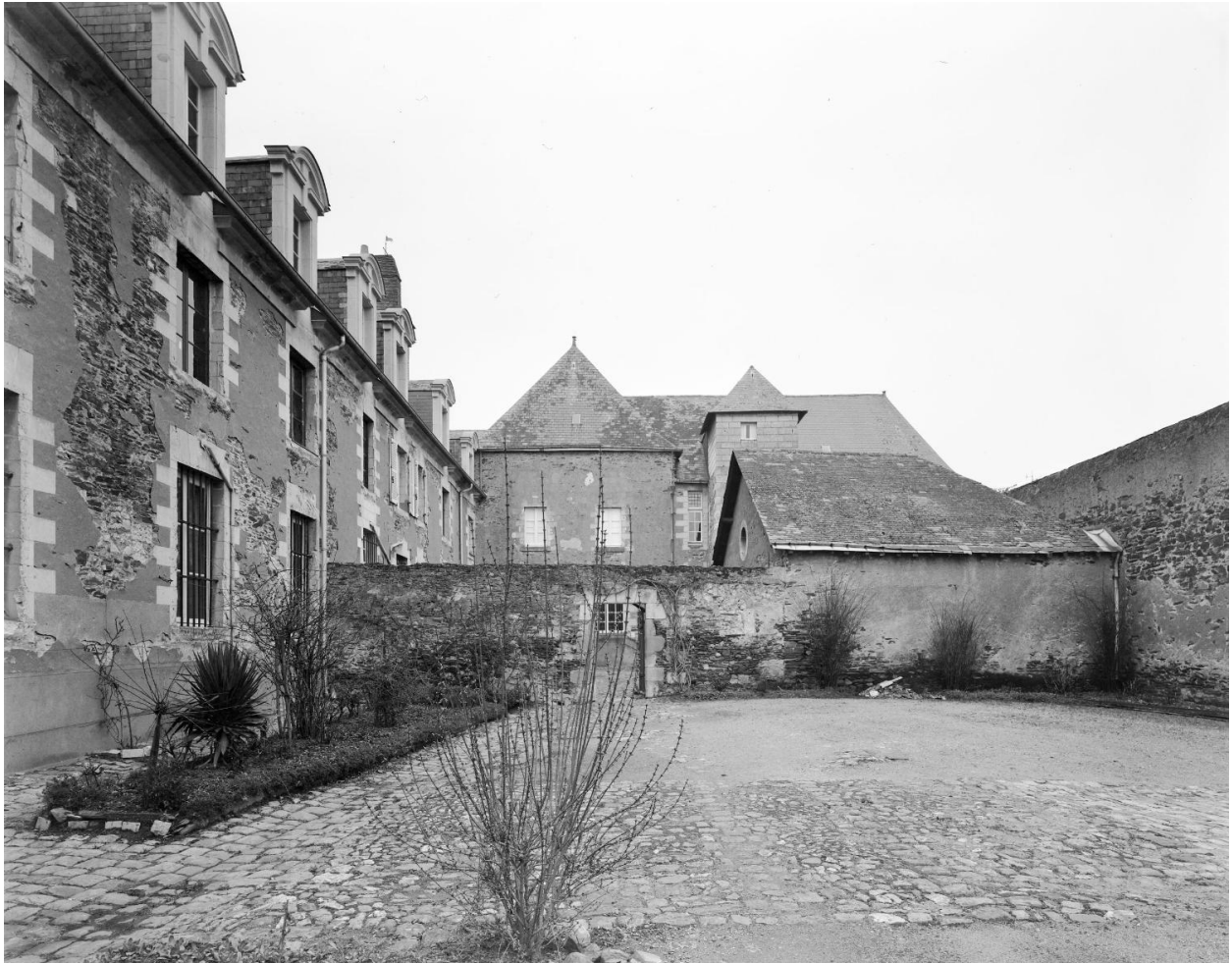
Cours de service au sud : à gauche, revers de l'aile sud du cloître ; au fond, corps de bâtiments du chœur des religieuses et de la salle du chapitre : façades ouest.
