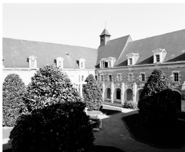
Cour du cloître : angle est, vue depuis le corridor d'étage de l'aile ouest. Phot. François Lasa IVR52_19974900920X
