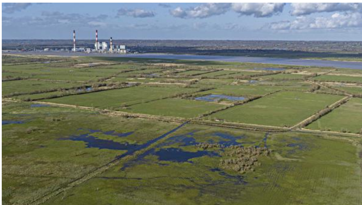
Ancienne île de Belle-Ile au Pellerin. En arrière-plan, la centrale thermique de Cordemais.
