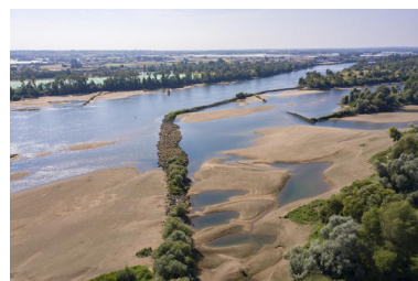
Digues et épis en Loire à la hauteur de Mauves-sur-Loire. Phot. Pierre-Bernard Fourny IVR52_20214400940NUCA
