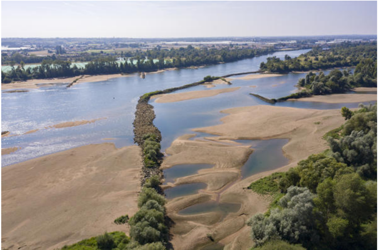
Digues et épis en Loire à la hauteur de Mauves-sur-Loire.
