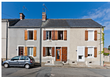
Elévations sur la rue des trois maisons. Phot. Yves Guillotin IVR52_20147201832NUCA
