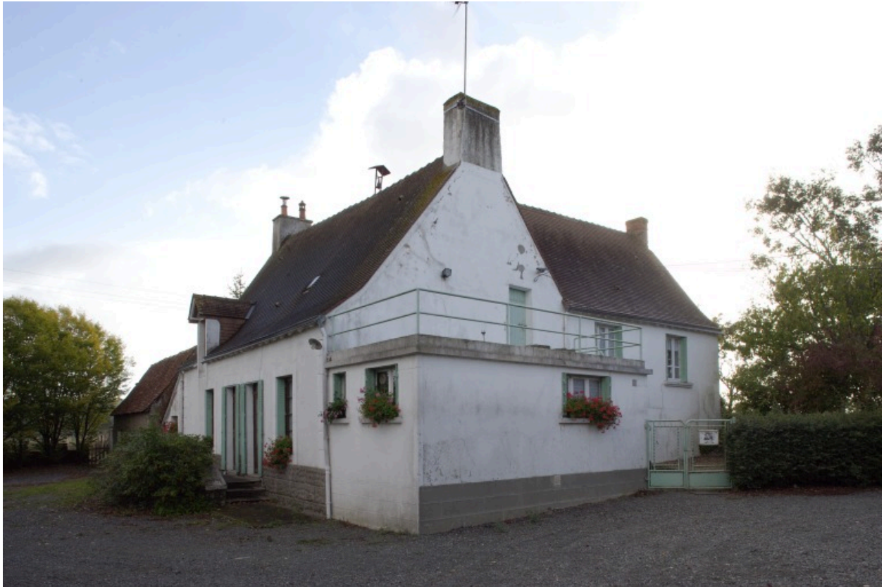
Le logis vu depuis le nord-ouest.
