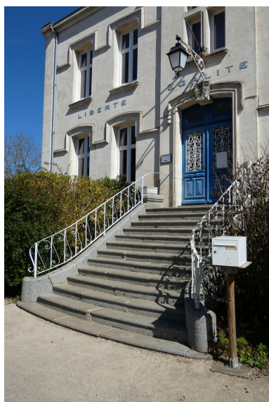
L'escalier. Phot. Yannis Suire IVR52_20238501319NUCA
