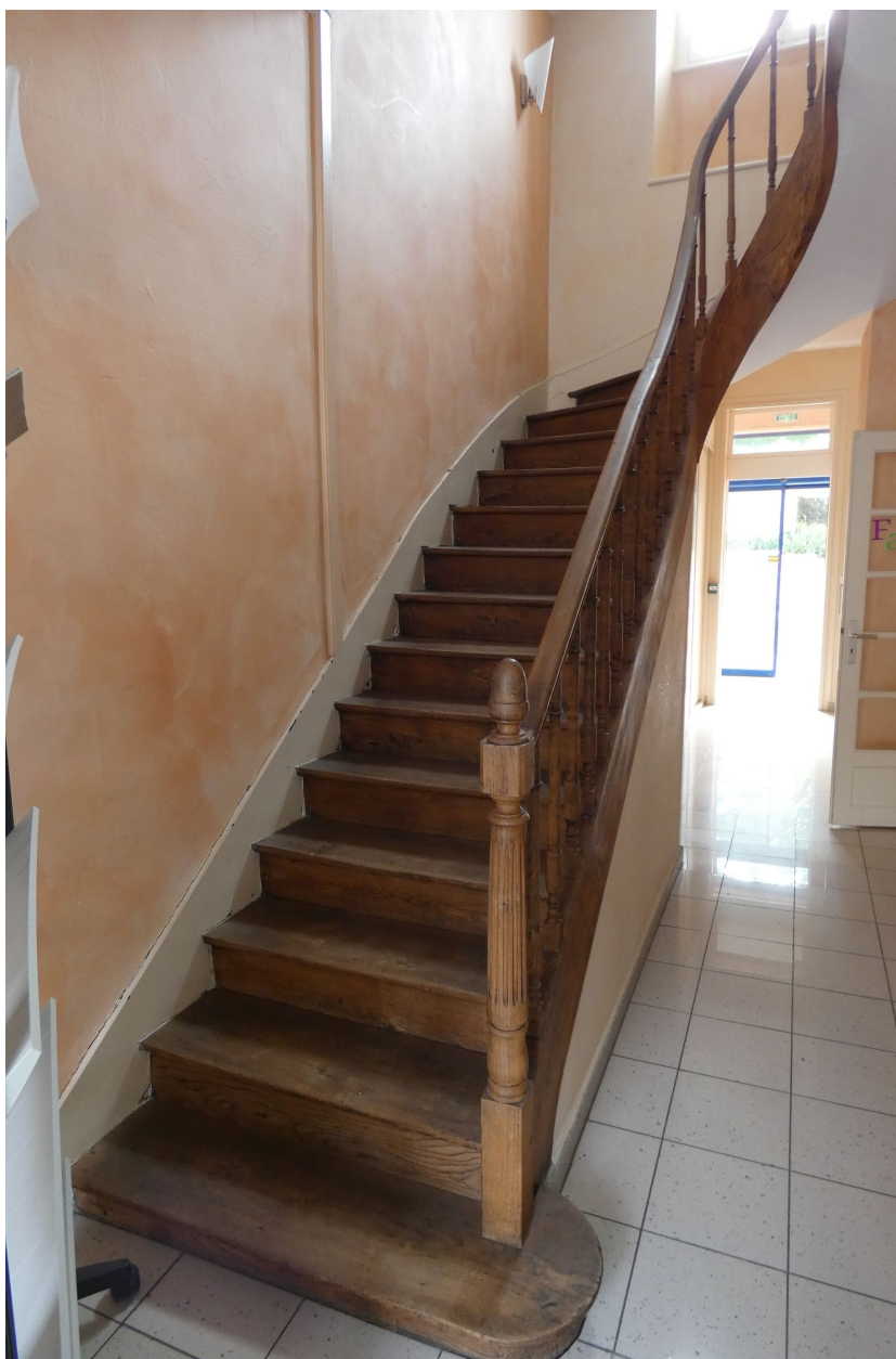
Escalier tournant en bois dans le couloir central de l'ancien logement d'enseignantes.
