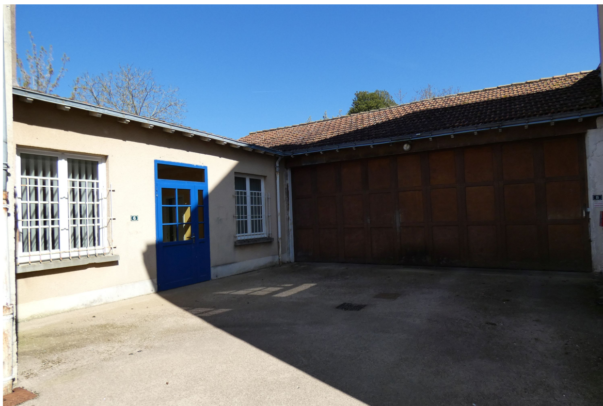
Salle de classe et remise dans l'angle nord-est.
