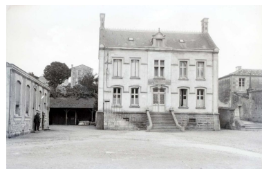
Le bureau de poste et la mairie, à gauche, dans l'ancienne école de filles, vers 1930. Repro. Yannis Suire IVR52_20238502336NUCA
