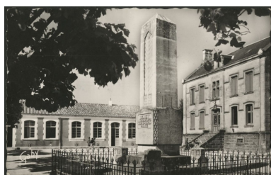
L'école et la mairie vues depuis le sud-ouest vers 1960. Repro. Yannis Suire IVR52_20238502331NUCA
