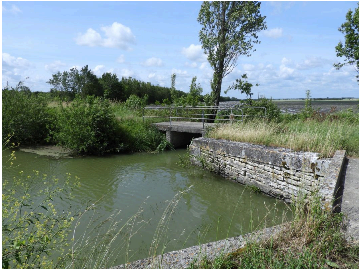
Le site de l'ancienne bonde du Tape cul. A l'arrière-plan, le pont en béton qui a remplacé la bonde.
