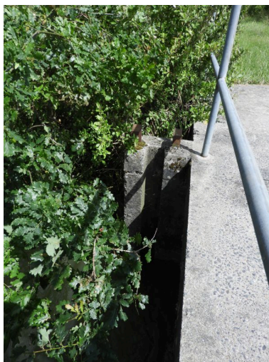
Batardeau sur le côté amont du pont et de l'ancienne bonde. Phot. Yannis Suire IVR52_20198503516NUCA
