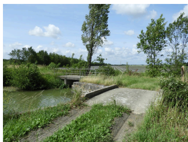
Le pont sur le canal de ceinture qui longe la levée d'Ecoué, au premier plan, avant le pont qui a pris la place de la bonde, à l'arrière-plan. Phot. Yannis Suire IVR52_20198503510NUCA
