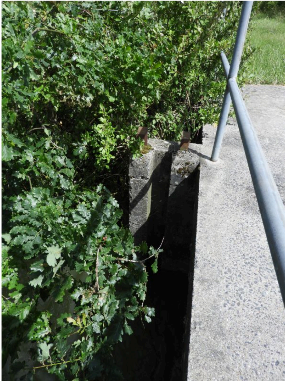
Batardeau sur le côté amont du pont et de l'ancienne bonde.
