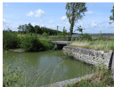
Le site de l'ancienne bonde du Tapecul. A l'arrière-plan, le pont en béton qui a remplacé la bonde. Phot. Yannis Suire IVR52_20198503509NUCA
