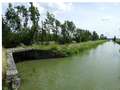
Le canal du Pont aux chèvres, à droite, vu depuis le pont de l'ancienne bonde, et, à gauche, le pont sur le canal de ceinture. Phot. Yannis Suire IVR52_20198503511NUCA
