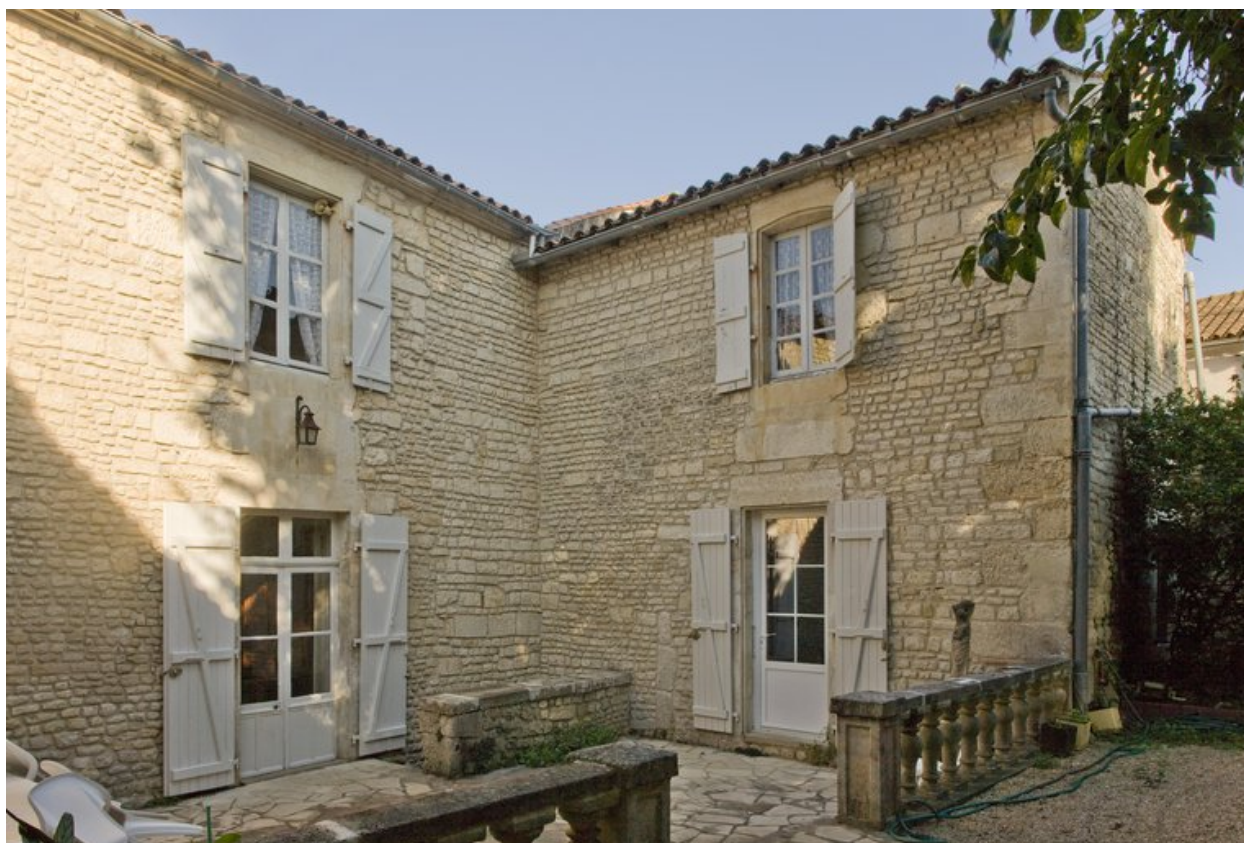
Vue partielle des façades sur cour : partie droite.
